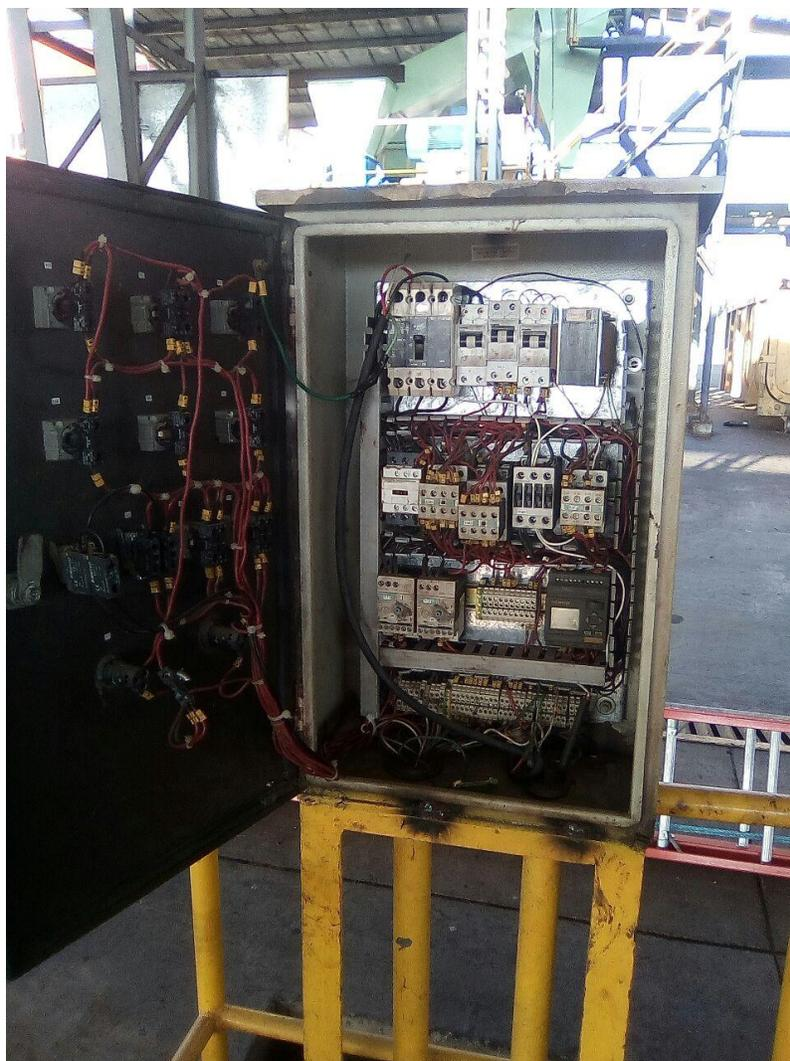
Figura 34.estructura interna de panel en mesa de volteo. *Fuente: autor*
