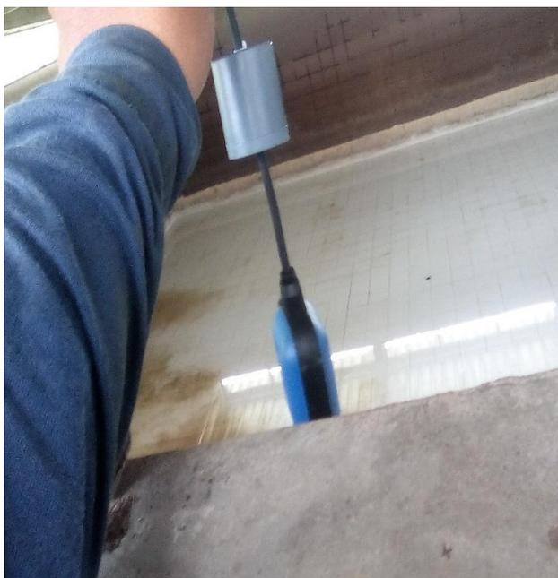
Figura 48. Montaje de boya plástica tipo flotador. *Fuente: autor*
