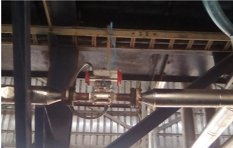
Figura 45. Válvula Bray con actuador neumático. *Fuente: autor*
