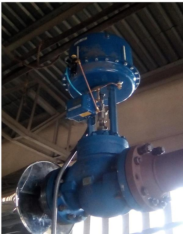
Figura 43. Válvula proporcional en la entrada del distribuidor. *Fuente: autor*
