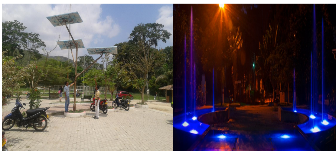
Figura 55. Instalación banco de paneles solares para la luminaria de la plazoleta de la vida (UFPSO). Fuente: Universidad Francisco de Paula Santander Ocaña.
