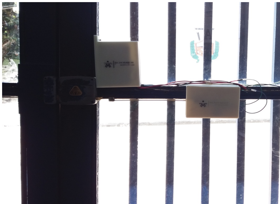
Figura 41. Instalación completa del sistema de ingreso al Tecnoparque. Fuente: Autor.
