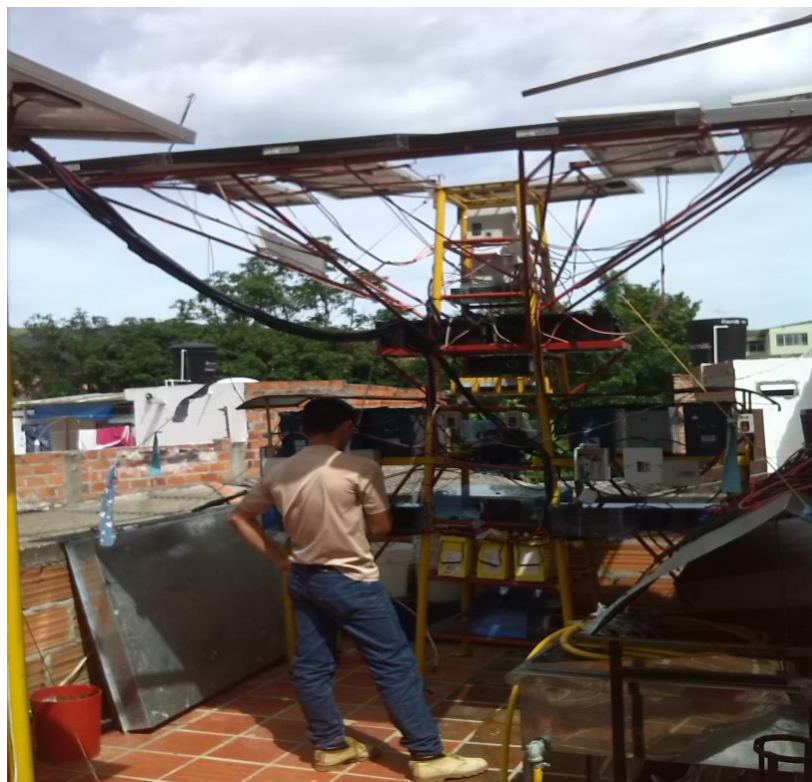
Figura 56. Instalación de la planta solar ubicada en el barrio el palomar. Fuente: Tecnoparque.
