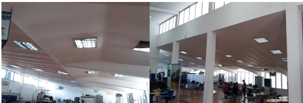
Figura 58. Iluminación del Tecnoparque. Fuente: Autor.
