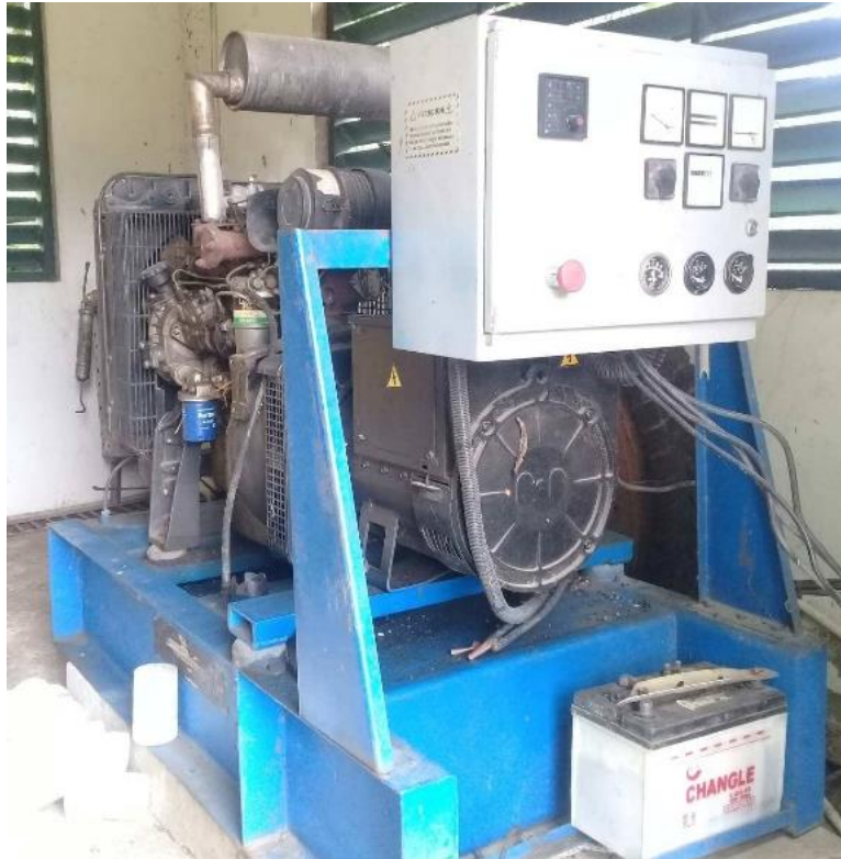
Figura 8. Generador Perkins 30 KW
