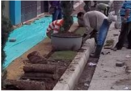
SUMINISTRO E INSTALACION DE CESPED
