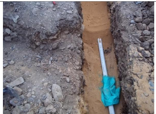
RELLENO PARA PROTECCION DE TUBERIA
