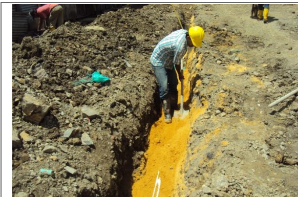
RELLENO PARA PROTECCION DE TUBERIA
