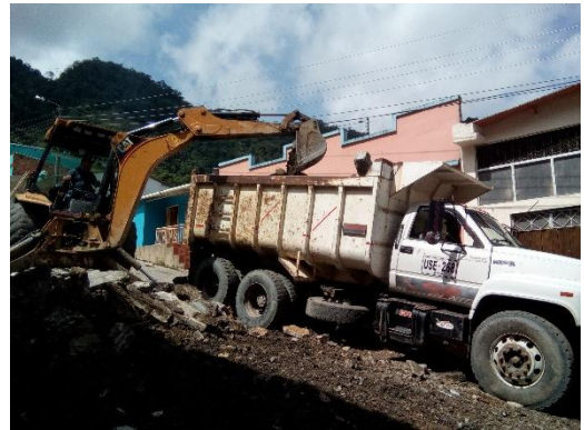
CARGUE Y TRANSPORTE MATERIAL DE DESECHO
