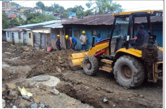
EXCAVACION Y RETIRO
