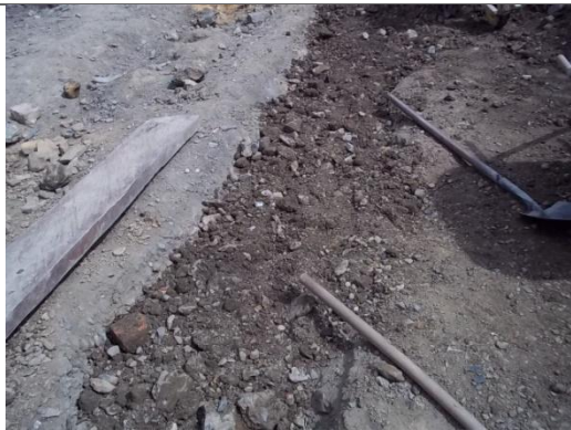
RELLENO EN MATERIAL COMUN
