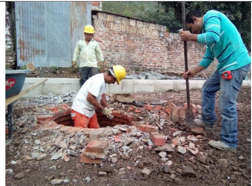
ADECUACIÓN DE POZO DE INSPECCIÓN INICIAL
