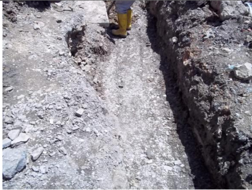
COMPACTACION DEL TERRENO PLANCHA TIPO RANA
