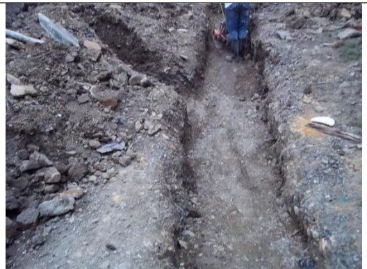
COMPACTACION DEL TERRENO PLANCHA TIPO RANA
