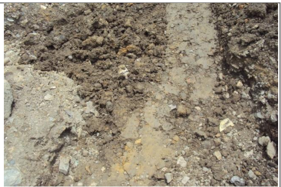
COMPACTACION DEL TERRENO PLANCHA TIPO RANA
