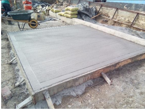
VACIADO DE CONCRETO HIDRÁULICO
