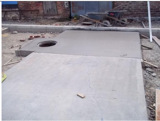
VACIADO DE CONCRETO HIDRÁULICO
