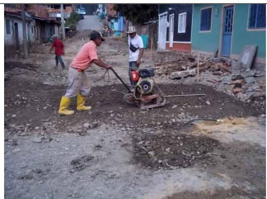
COMPACTACION DEL TERRENO
