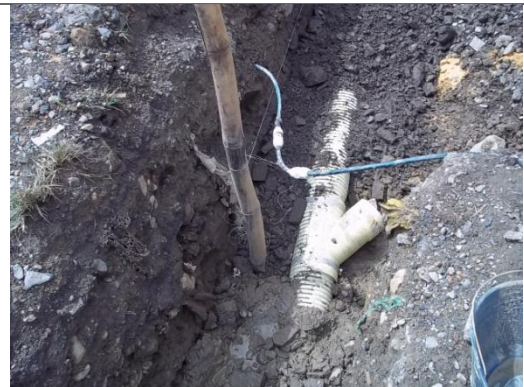
MATERIAL SELECCIONADO PARA PROTECCION DE TUBERIA – SILLAS YE
