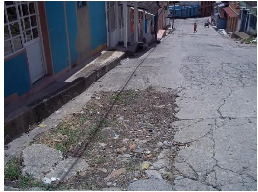
DEMOLICION DE PAVIMENTO
