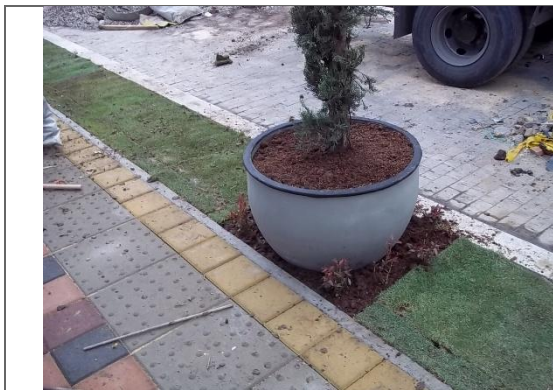
SUMINISTRO E INSTALACION DE PINOS VELA INCLUYE MATERA EN CONCRETO
