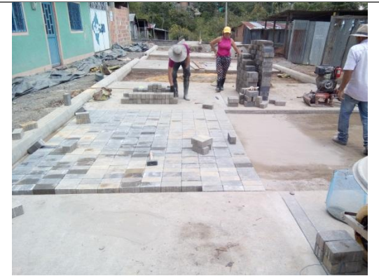
SUM/INST DE ADOQUIN PARA PAVIMENTO
