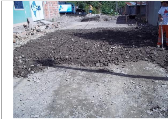
RELLENO Y COMPACTACION DEL TERRENO EN MATERIAL SELECCIONADO Y COMUN
