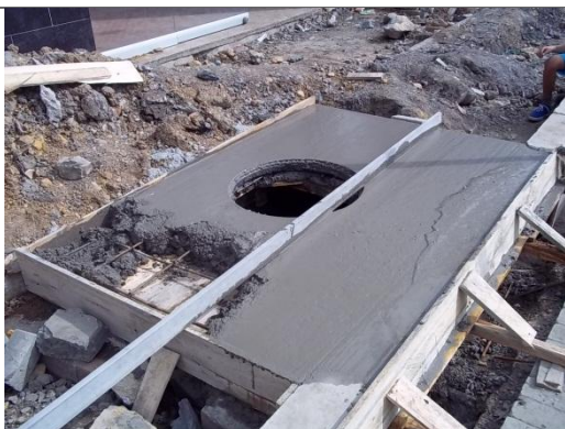
FORMALETA Y VACIADO DE CONCRETO
