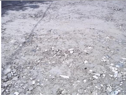
COMPACTACION DEL TERRENO
