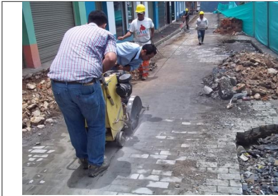
DEMOLICION PAVIMENTO EN ADOQUIN
