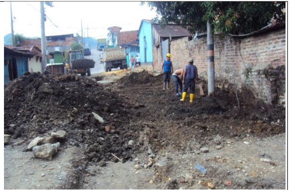
EXCAVACION Y RETIRO
