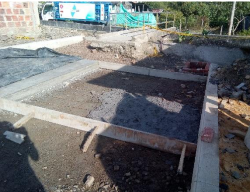
VACIADO DE CONCRETO HIDRÁULICO
