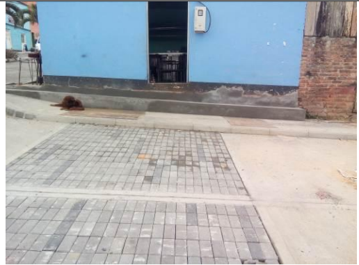
CONCRETO PARA CONTENCIÓN DE ANDEN
