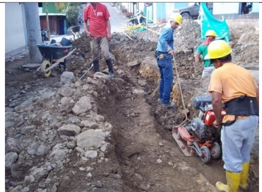
COMPACTACION DEL TERRENO
