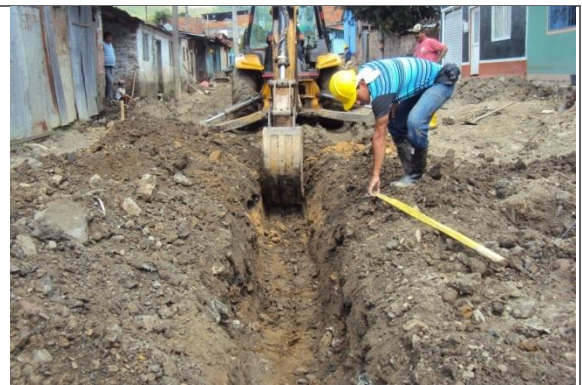
EXCAVACIONES PARA RED PRINCIPAL DE ACUEDUCTO
