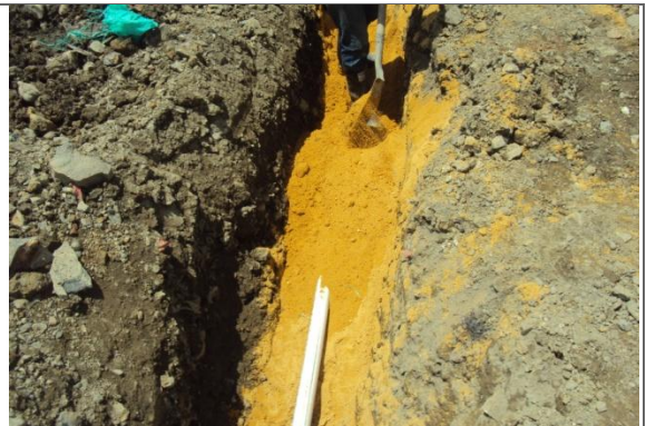
RELLENO PARA PROTECCION DE TUBERIA
