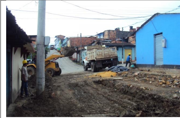
EXCAVACION Y RETIRO
