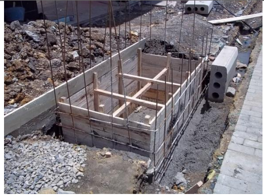
FORMALETA Y VACIADO DE CONCRETO
