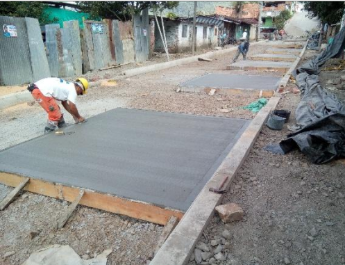
VACIADO DE CONCRETO HIDRÁULICO
