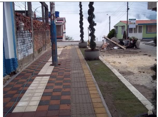
SUMINISTRO E INSTALACION DE PINOS VELA INCLUYE MATERA EN CONCRETO
