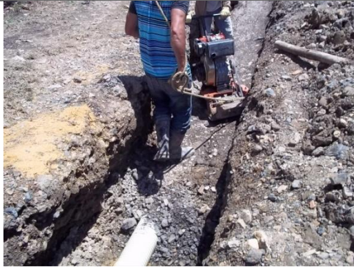
COMPACTACION DEL TERRENO PLANCHA TIPO RANA
