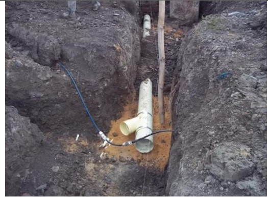
CAMA PARA TUBERIA – SILLAS YE
