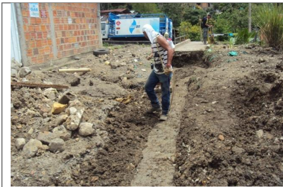
COMPACTACION DEL TERRENO PLANCHA TIPO RANA
