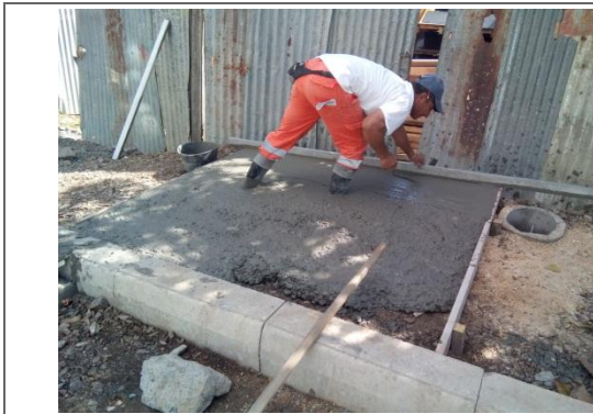
VACIADO DE CONCRETO
