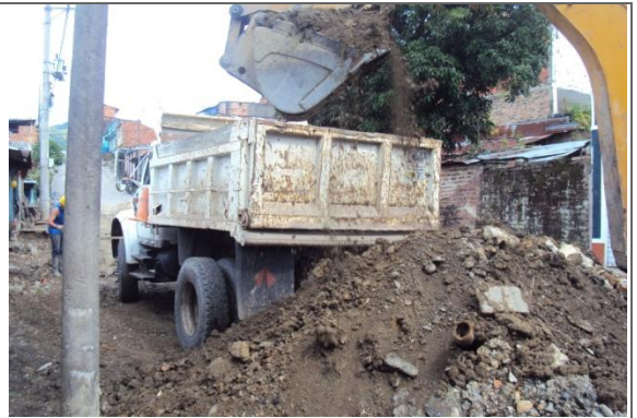
EXCAVACION Y RETIRO
