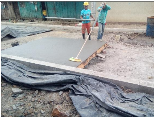
VACIADO DE CONCRETO HIDRÁULICO
