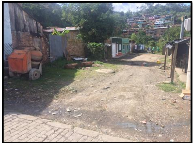
Figura 4.1 Calle 5 Fuente: Director de Obra
