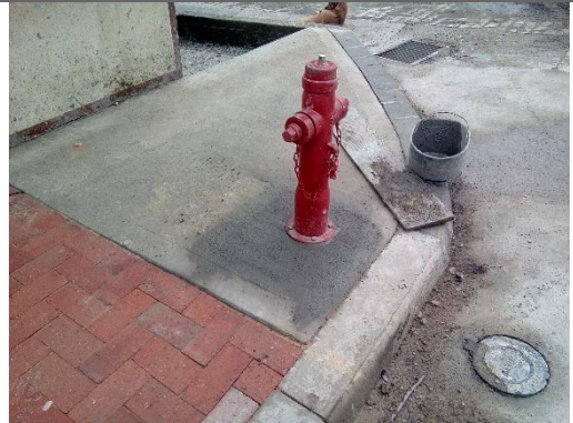
SUM/INST DE HIDRANTE
