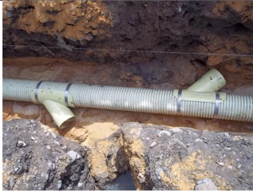
CAMA PARA TUBERIA – SILLAS YE
