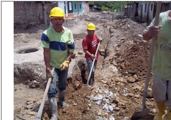
EXCAVACIONES PARA RED PRINCIPAL Y DOMICILIARIA DE ACUEDUCTO
