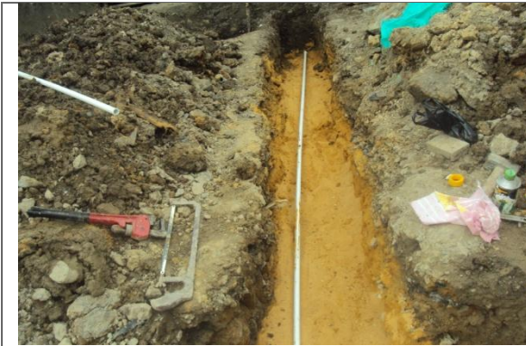
INSTALACION RED DOMICILIARIA EN TUBERIA PVC 1/2"
