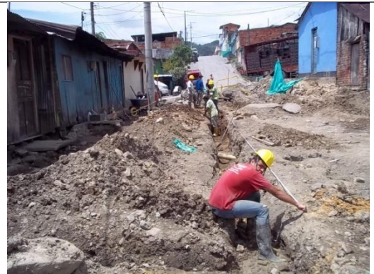
RELLENO EN MATERIAL COMUN
