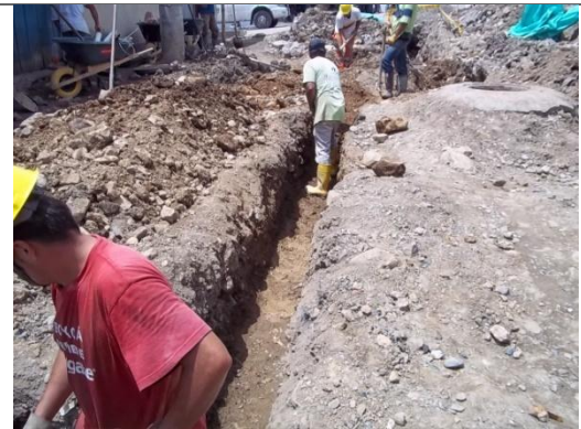
EXCAVACIONES PARA RED PRINCIPAL Y DOMICILIARIA DE ACUEDUCTO
