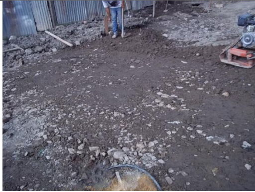
COMPACTACION DEL TERRENO
