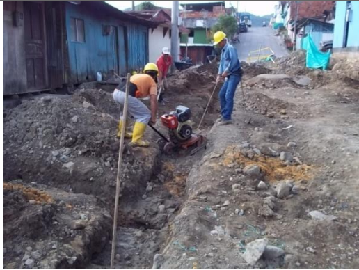
COMPACTACION DEL TERRENO
