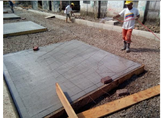
VACIADO DE CONCRETO HIDRÁULICO
