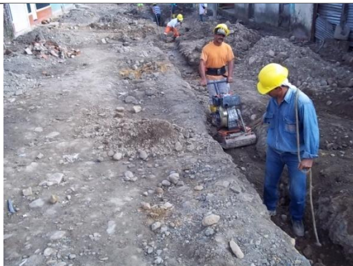
COMPACTACION DEL TERRENO
