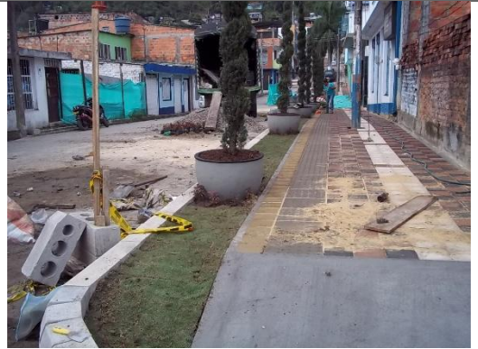
SUMINISTRO E INSTALACION DE CESPED
