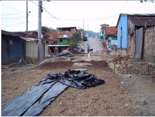
RELLENO EN MATERIAL SELECCIONADO
