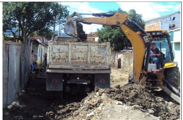
EXCAVACION Y RETIRO
