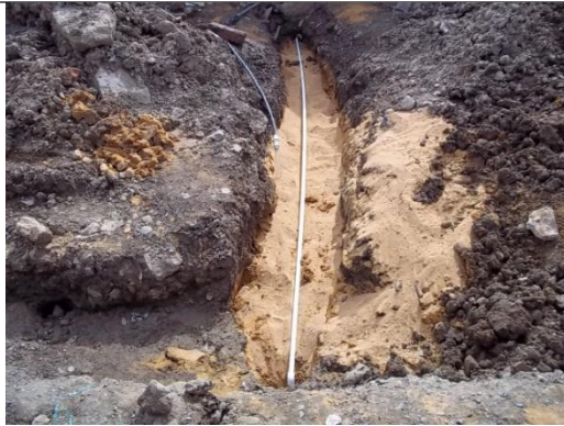
INSTALACION RED DOMICILIARIA EN TUBERIA PVC 1/2"
