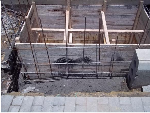
FORMALETA Y VACIADO DE CONCRETO
