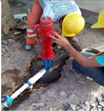
SUM/INST DE HIDRANTE
