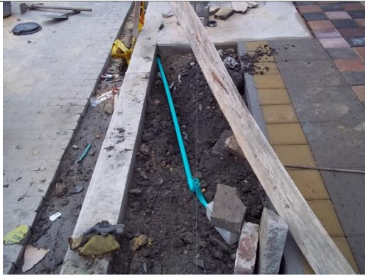
SALIDA PARA ALUMBRADO NORMAL
