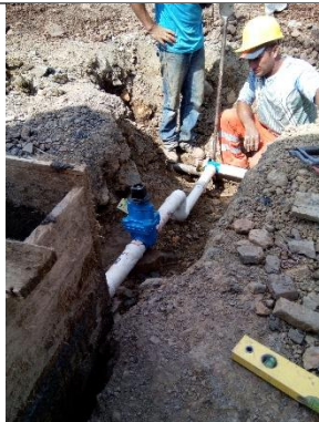
SUM/INST DE HIDRANTE
