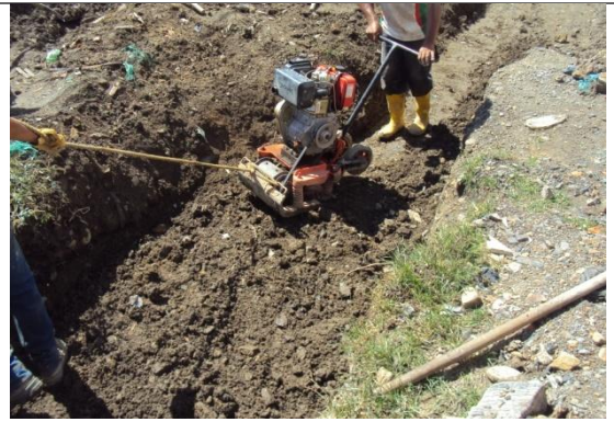
COMPACTACION DEL TERRENO PLANCHA TIPO RANA
