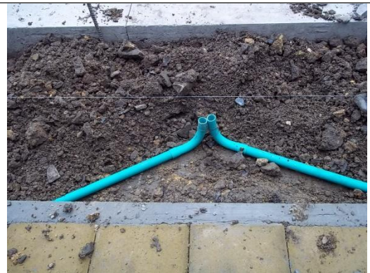
SALIDA PARA ALUMBRADO NORMAL
