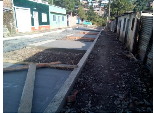
VACIADO DE CONCRETO HIDRÁULICO
