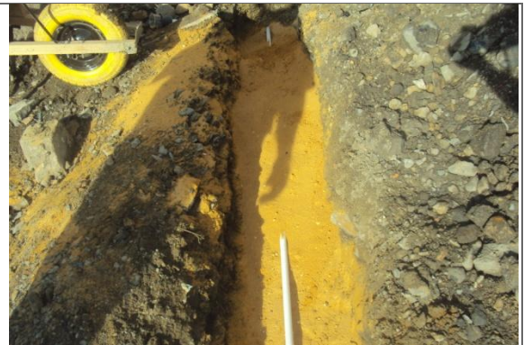
RELLENO PARA PROTECCION DE TUBERIA
