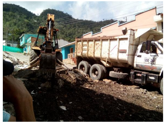
DEMOLICION DE SARDINEL, ANDENES EN CONCRETO Y ENCHAPE
