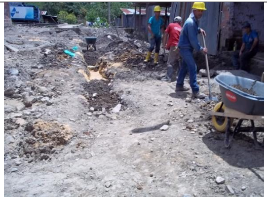
RELLENO EN MATERIAL COMUN
