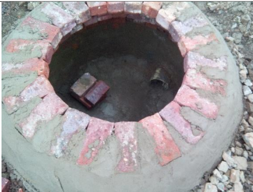
ADECUACIÓN DE POZO DE INSPECCIÓN INICIAL
