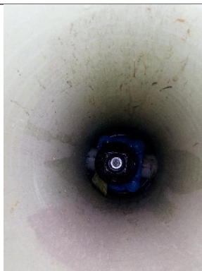
SUM/INST DE HIDRANTE
