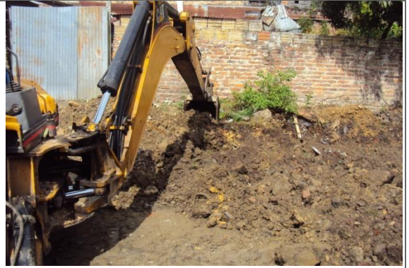
EXCAVACION Y RETIRO
