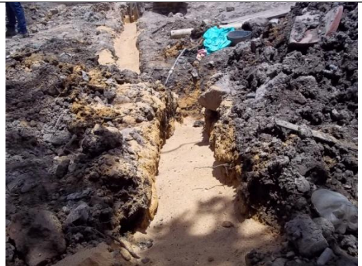
RELLENO PARA PROTECCION DE TUBERIA
