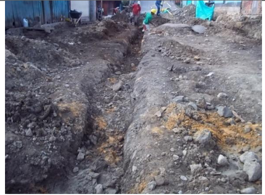
RELLENO EN MATERIAL COMUN
