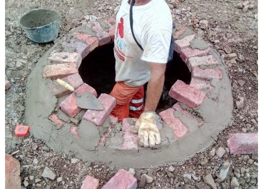
ADECUACIÓN DE POZO DE INSPECCIÓN INICIAL
