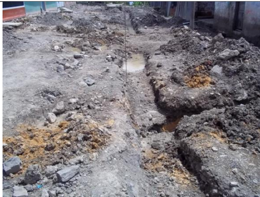
RELLENO EN MATERIAL COMUN
