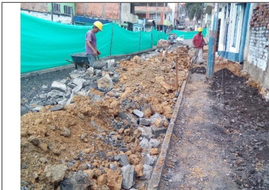
RELLENO MATERIAL SELECCIONADO
