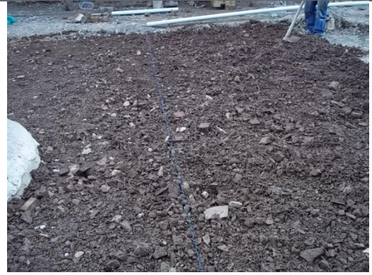
RELLENO EN MATERIAL SELECCIONADO
