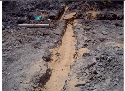
RELLENO PARA PROTECCION DE TUBERIA
