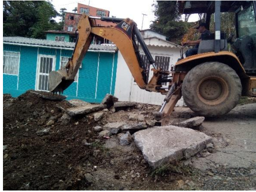
DEMOLICION DE PAVIMENTO
