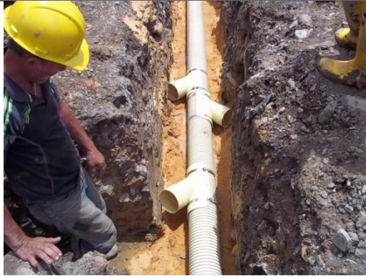
CAMA PARA TUBERIA E INSTALACION DE SILLAS Y
