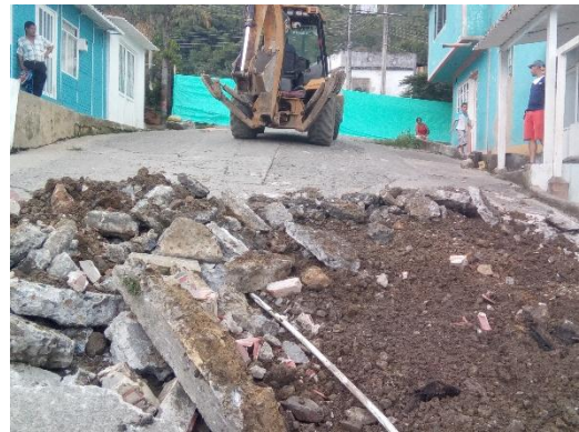
DEMOLICION DE PAVIMENTO
