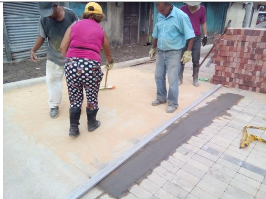
VIGA PARA PAVIMENTO
