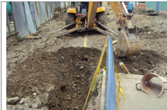
EXCAVACIONES PARA RED PRINCIPAL DE ACUEDUCTO
