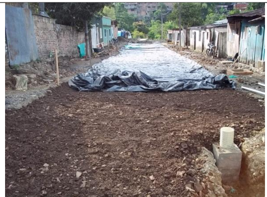
RELLENO EN MATERIAL SELECCIONADO
