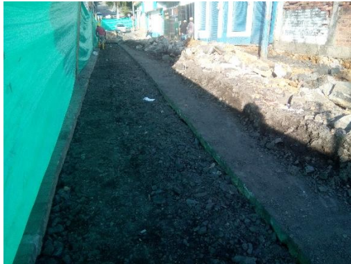
RELLENO MATERIAL SELECCIONADO
