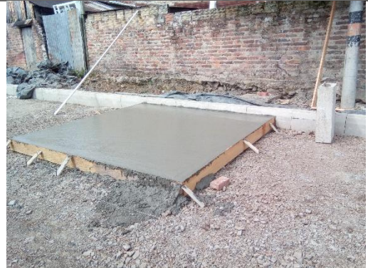
VACIADO DE CONCRETO HIDRÁULICO
