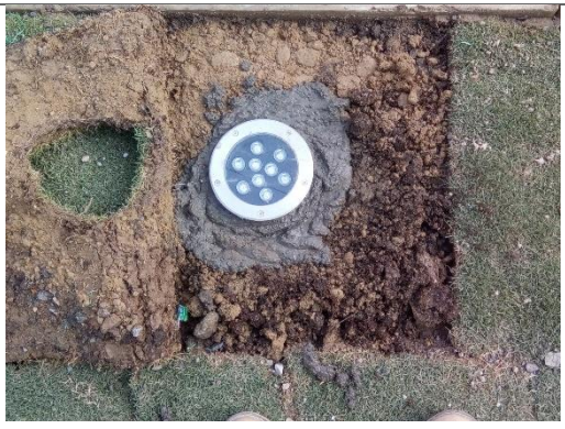
SUMINISTRO E INSTALACION DE BALAS DE PISOS DE 4" REFLECTORES
