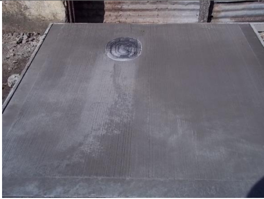
VACIADO DE CONCRETO
