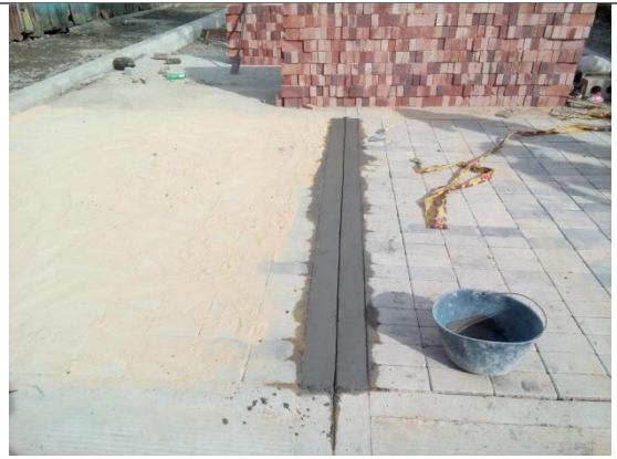
VIGA PARA PAVIMENTO
