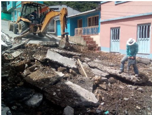
DEMOLICION DE PAVIMENTO
