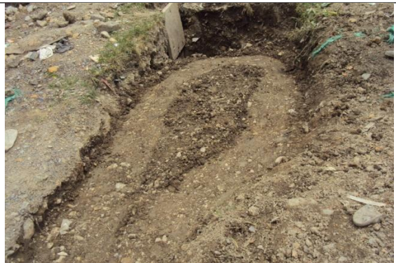
COMPACTACION DEL TERRENO PLANCHA TIPO RANA
