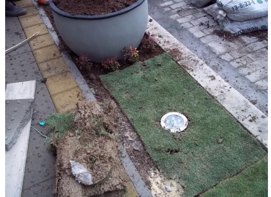
SUMINISTRO E INSTALACION DE CESPED
