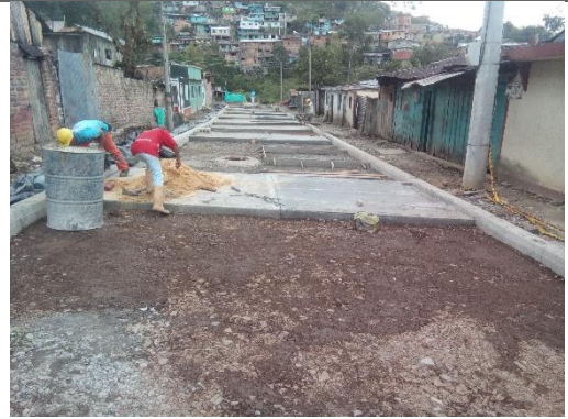
VACIADO DE CONCRETO HIDRÁULICO
