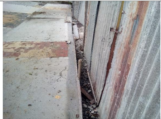
CONCRETO PARA CONTENCIÓN DE ANDÉN
