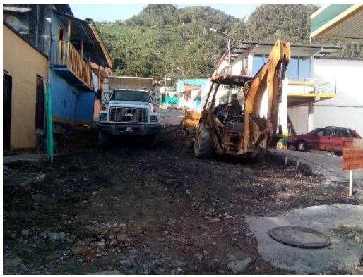
DEMOLICION DE PAVIMENTO
