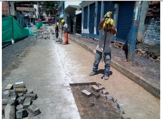
DEMOLICION PAVIMENTO EN ADOQUIN
