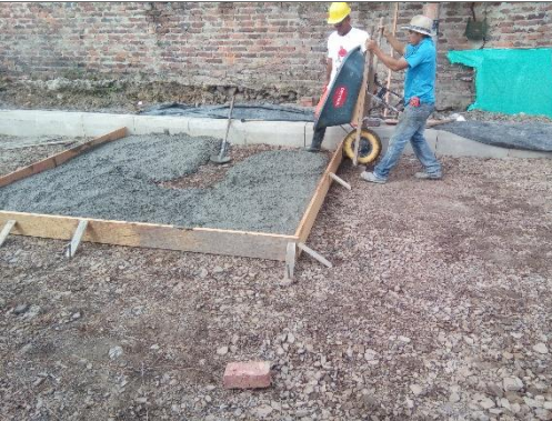
VACIADO DE CONCRETO HIDRÁULICO
