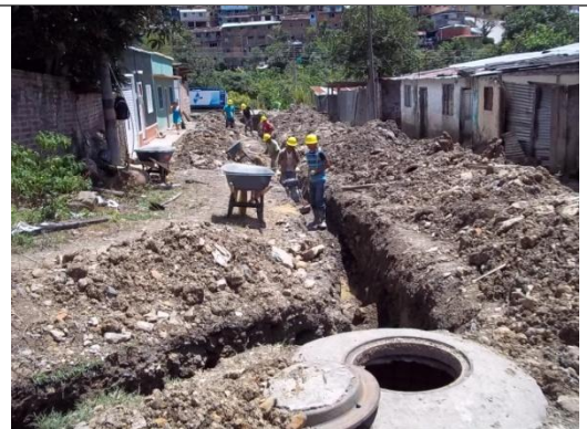
COMPACTACION DEL TERRENO PLANCHA TIPO RANA
