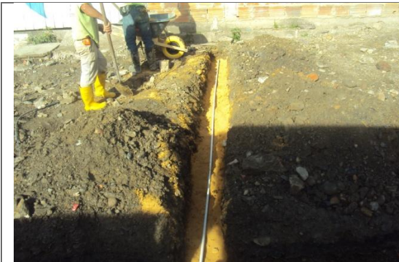
RELLENO PARA PROTECCION DE TUBERIA
