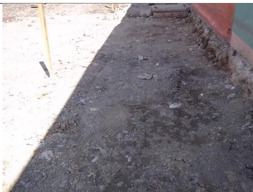
RELLENO Y COMPACTACION DEL TERRENO EN MATERIAL SELECCIONADO Y COMUN
