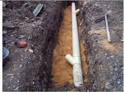
CAMA PARA TUBERIA – SILLAS YE
