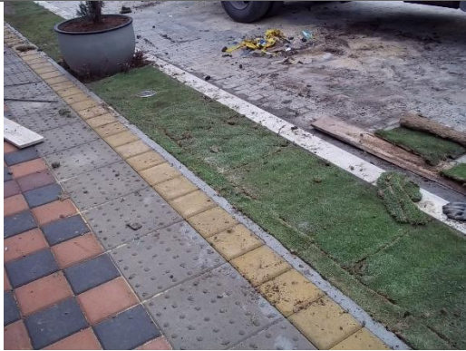
SUMINISTRO E INSTALACION DE CESPED
