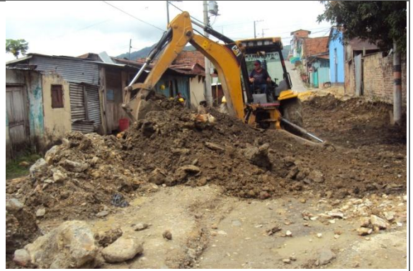
EXCAVACION Y RETIRO
