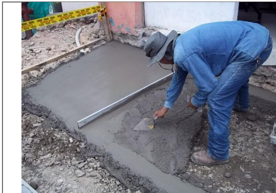
SUMINISTRO DE MORTERO DE NIVELACION PARA PISO DE ANDÉN
