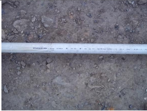
SUM/INST DE RED PVC RD21 2" SOBRE CAMA DE ARENA
