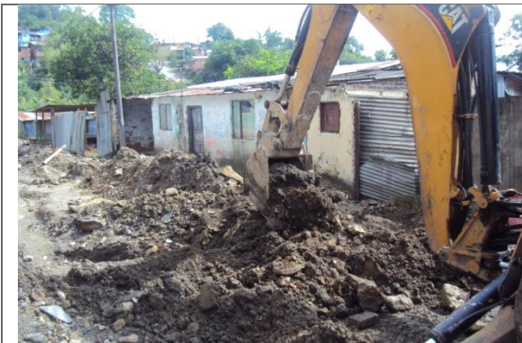
EXCAVACION Y RETIRO
