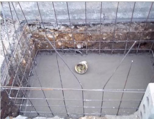
PARRILLA Y VACIADO DE CONCRETO
