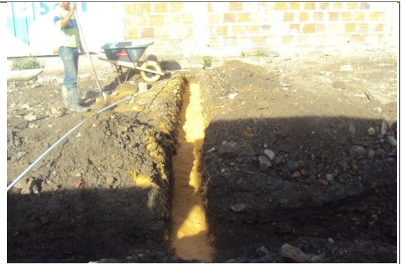
RELLENO PARA PROTECCION DE TUBERIA
