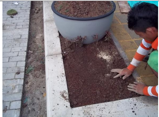
SUMINISTRO E INSTALACION DE CESPED
