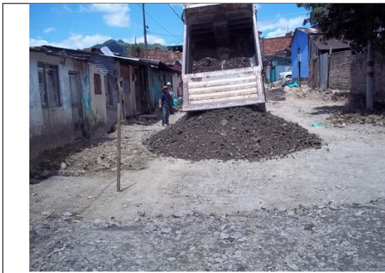
RELLENO EN MATERIAL SELECCIONADO
