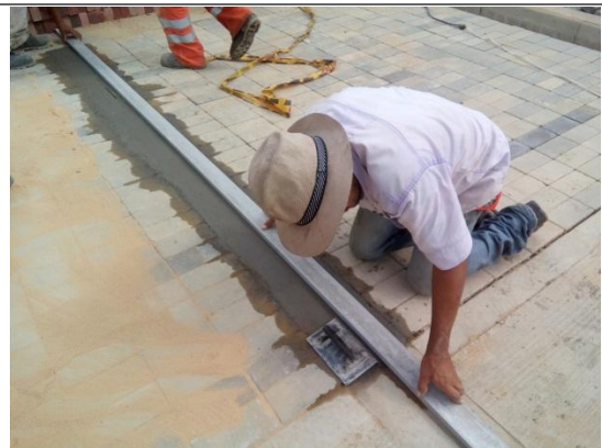
VIGA PARA PAVIMENTO
