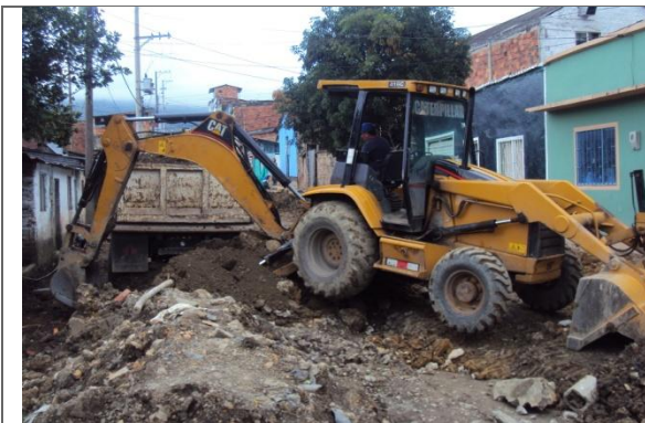
EXCAVACION Y RETIRO
