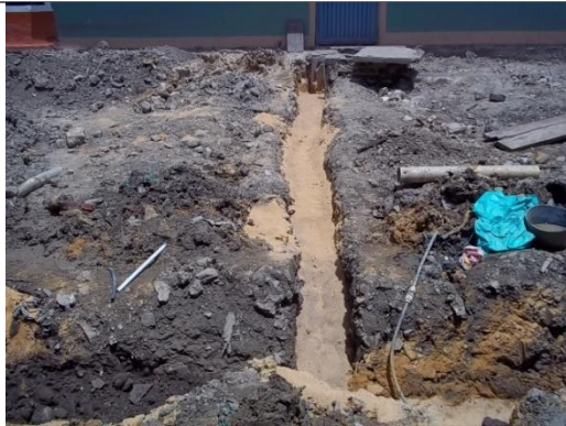
RELLENO PARA PROTECCION DE TUBERIA
