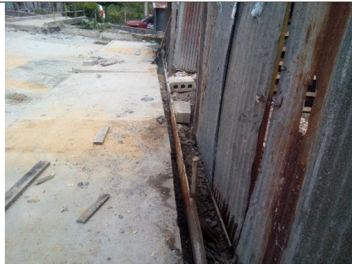
CONCRETO PARA CONTENCIÓN DE ANDEN
