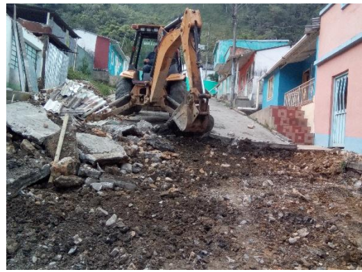
DEMOLICION DE PAVIMENTO
