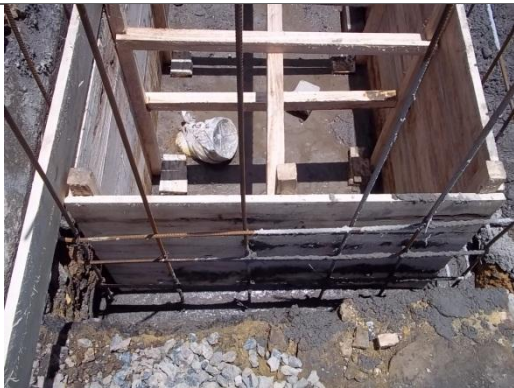
FORMALETA Y VACIADO DE CONCRETO
