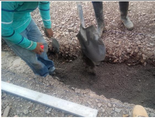
EXCAVACIÓN PARA SUM/INST DE SARDINEL
