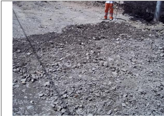
RELLENO EN MATERIAL SELECCIONADO
