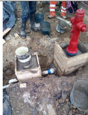
SUM/INST DE HIDRANTE
