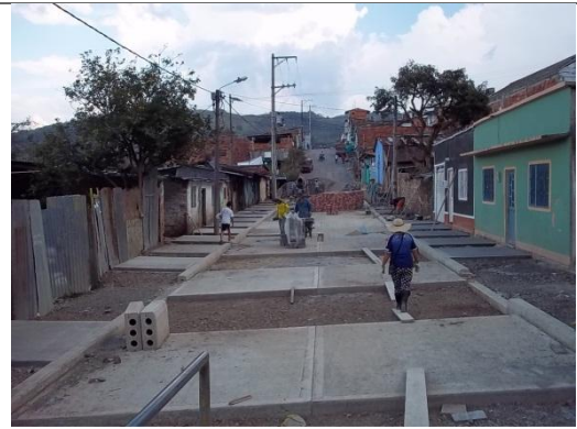
VACIADO DE CONCRETO
