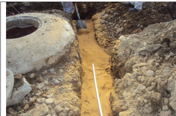
RELLENO PARA PROTECCION DE TUBERIA
