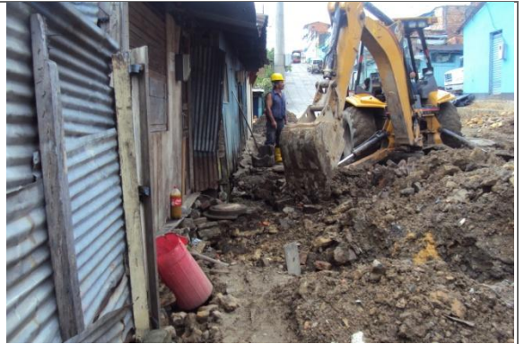
EXCAVACION Y RETIRO
