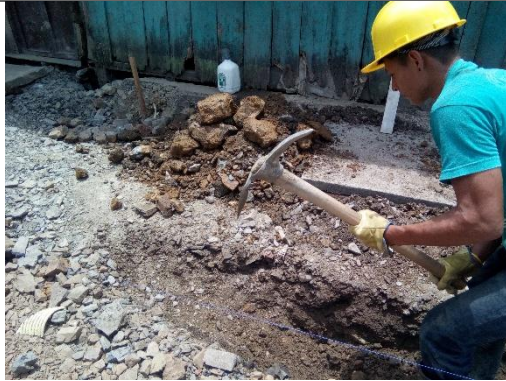
EXCAVACIÓN PARA SUM/INST DE SARDINEL
