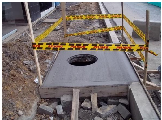
FORMALETA Y VACIADO DE CONCRETO
