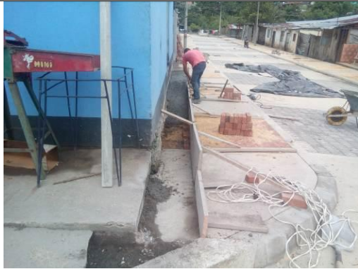
CONCRETO PARA CONTENCIÓN DE ANDEN
