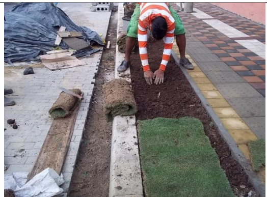
SUMINISTRO E INSTALACION DE CESPED
