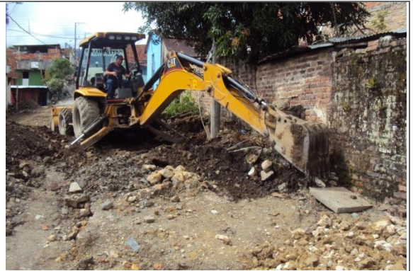
EXCAVACION Y RETIRO
