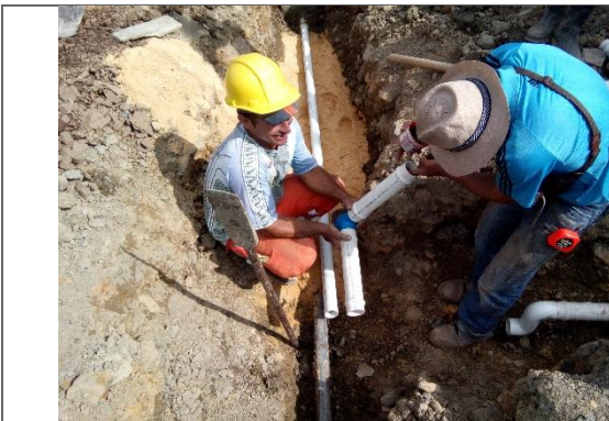
SUM/INST DE HIDRANTE
