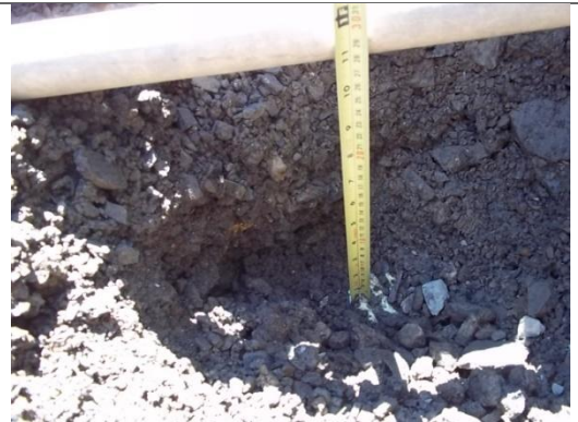
PROFUNDIDAD MATERIAL SELECCIONADO PARA PROTECCION DE TUBERIA
