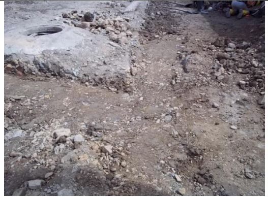
COMPACTACION DEL TERRENO
