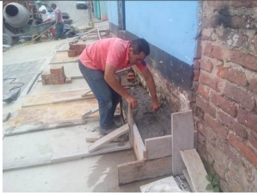
CONCRETO PARA CONTENCIÓN DE ANDEN
