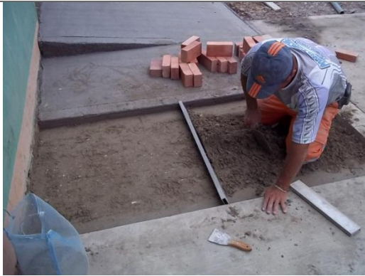
SUM/ INST DE MORTERO DE NIVELACIÓN DE PISO
