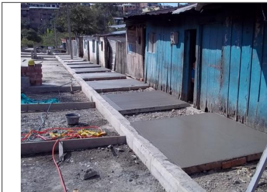
VACIADO DE CONCRETO
