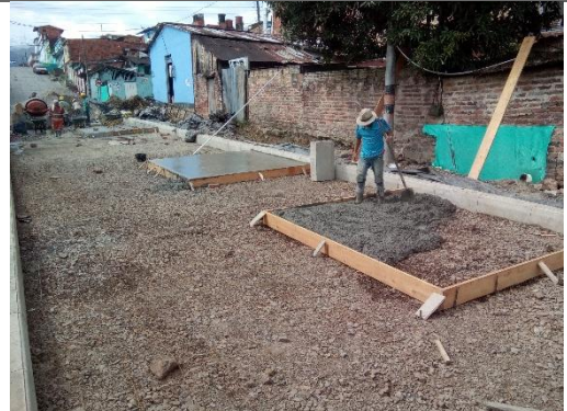
VACIADO DE CONCRETO HIDRÁULICO
