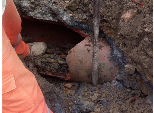
CAJA DE AGUAS LLUVIAS
