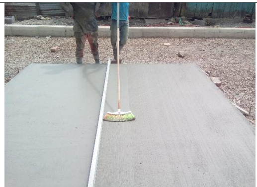
VACIADO DE CONCRETO HIDRÁULICO
