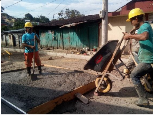
VACIADO DE CONCRETO HIDRÁULICO
