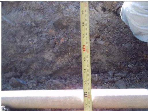
PROFUNDIDAD MATERIAL SELECCIONADO PARA PROTECCION DE TUBERIA
