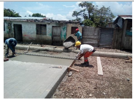
VACIADO DE CONCRETO HIDRÁULICO
