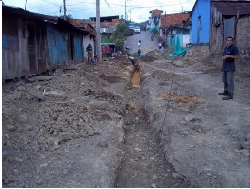
RELLENO EN MATERIAL COMUN
