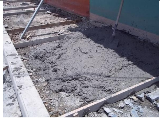
VACIADO DE CONCRETO
