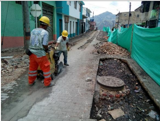
DEMOLICION PAVIMENTO EN ADOQUIN
