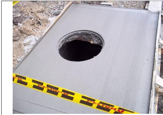
FORMALETA Y VACIADO DE CONCRETO
