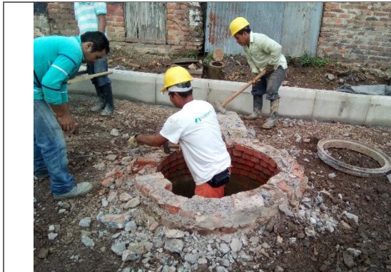
ADECUACIÓN DE POZO DE INSPECCIÓN INICIAL
