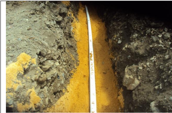
SUM/INST DE RED PVC RD21 2" SOBRE CAMA DE ARENA
