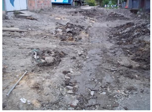
COMPACTACION DEL TERRENO
