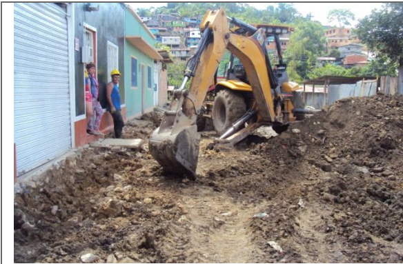
EXCAVACION Y RETIRO
