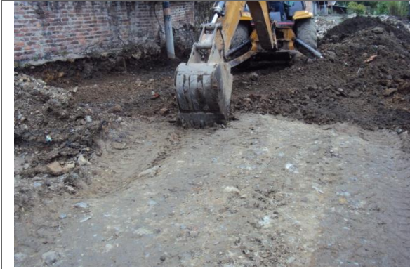
EXCAVACION Y RETIRO
