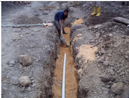
RELLENO PARA PROTECCION DE TUBERIA
