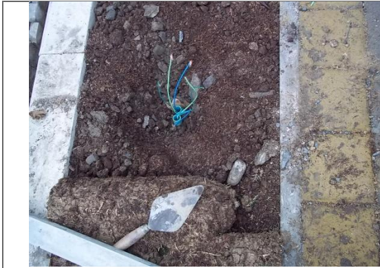
SALIDA PARA ALUMBRADO NORMAL
