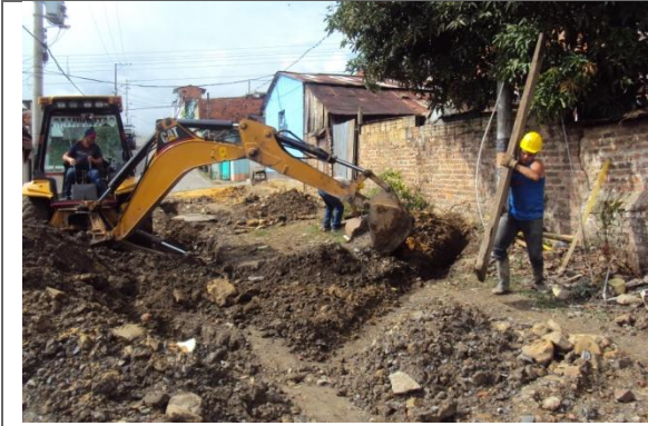
EXCAVACION Y RETIRO
