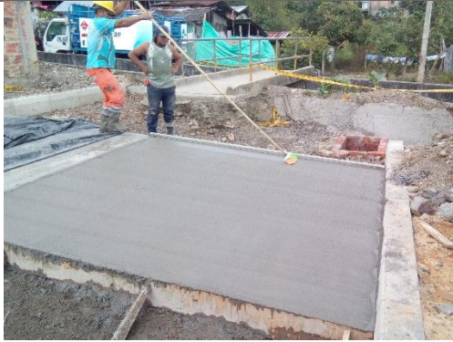
VACIADO DE CONCRETO HIDRÁULICO
