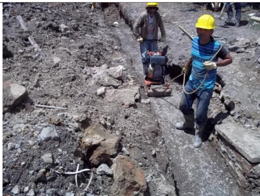
COMPACTACION DEL TERRENO PLANCHA TIPO RANA
