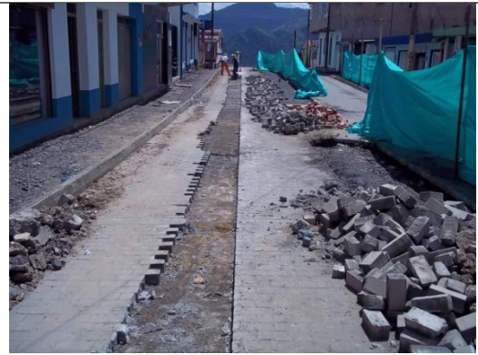
DEMOLICION PAVIMENTO EN ADOQUIN
