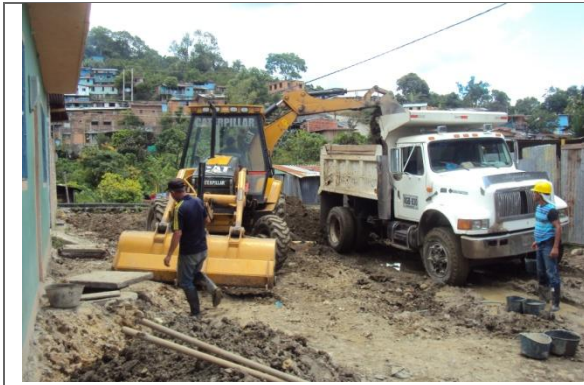
EXCAVACION Y RETIRO
