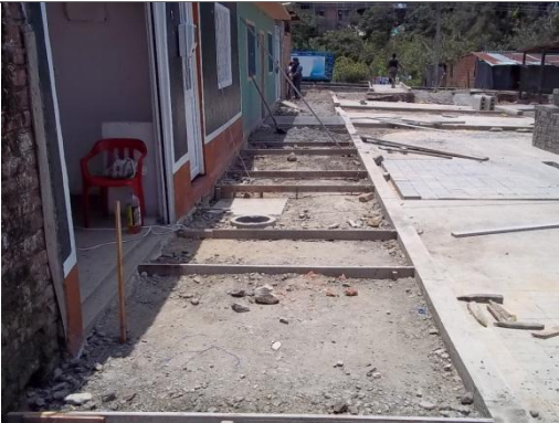
VACIADO DE CONCRETO
