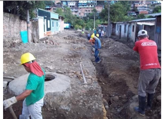
RELLENO EN MATERIAL COMUN
