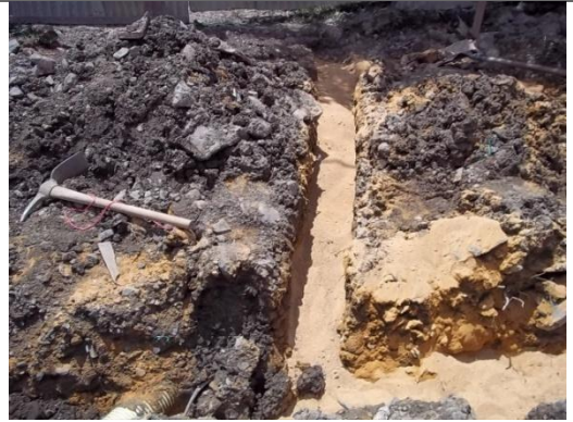
RELLENO PARA PROTECCION DE TUBERIA
