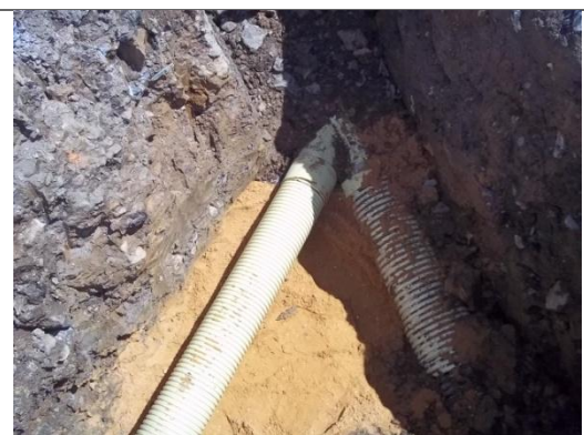
CAMA PARA TUBERIA CONEXIÓN A RED PRINCIPAL
