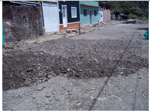
RELLENO EN MATERIAL SELECCIONADO
