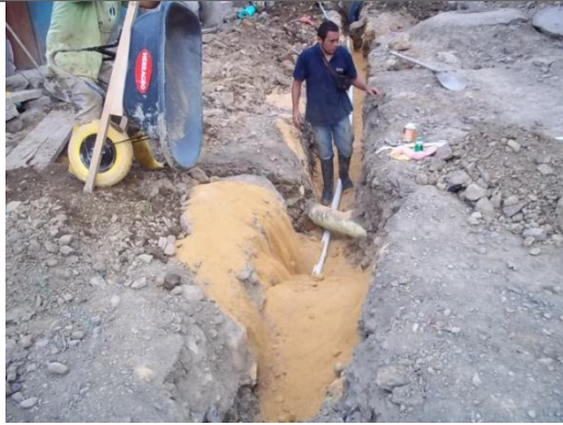
RELLENO PARA PROTECCION DE TUBERIA
