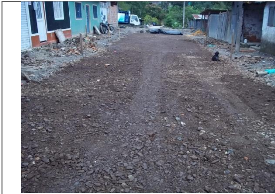
RELLENO EN MATERIAL SELECCIONADO
