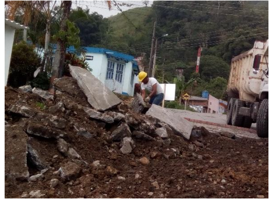
DEMOLICION DE PAVIMENTO
