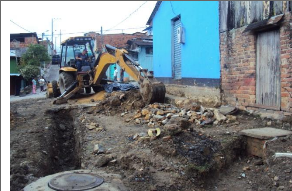
EXCAVACION Y RETIRO
