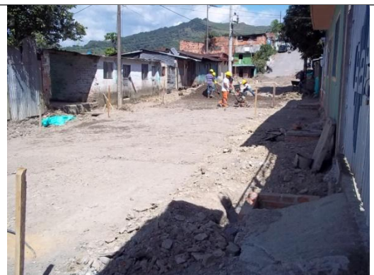
RELLENO Y COMPACTACION DEL TERRENO EN MATERIAL SELECCIONADO Y COMUN
