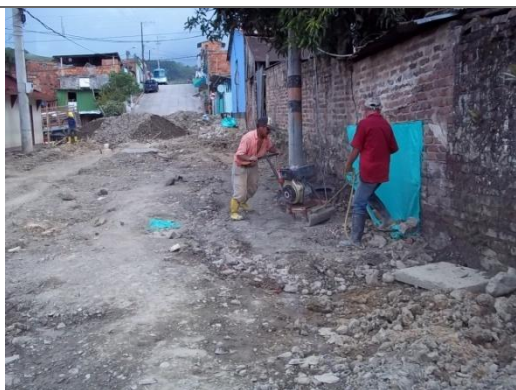
COMPACTACION DEL TERRENO
