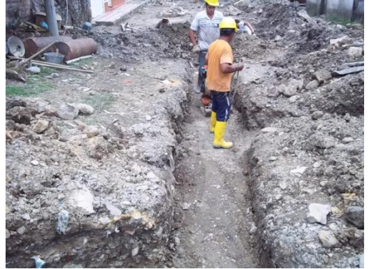
COMPACTACION DEL TERRENO PLANCHA TIPO RANA
