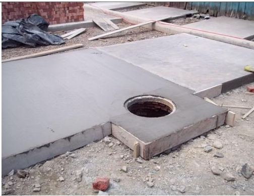
VACIADO DE CONCRETO HIDRÁULICO
