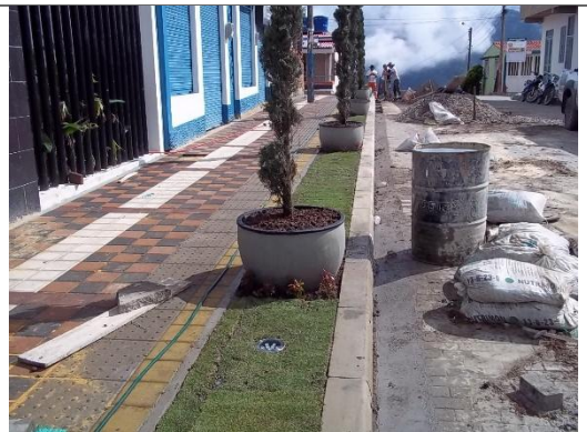
SUMINISTRO E INSTALACION DE CESPED
