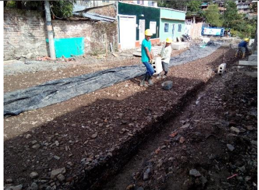
EXCAVACIÓN PARA SUM/INST DE SARDINEL
