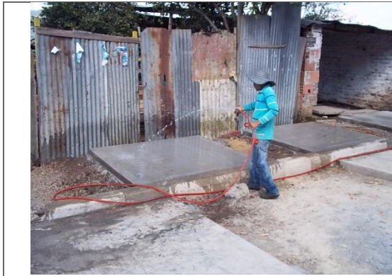
VACIADO DE CONCRETO
