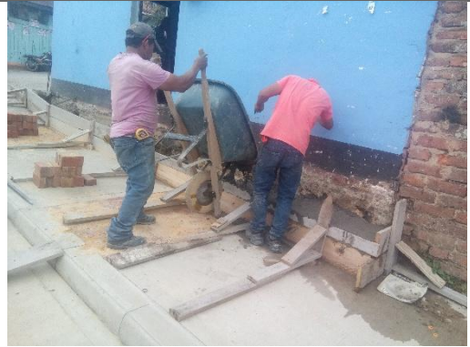
CONCRETO PARA CONTENCIÓN DE ANDEN
