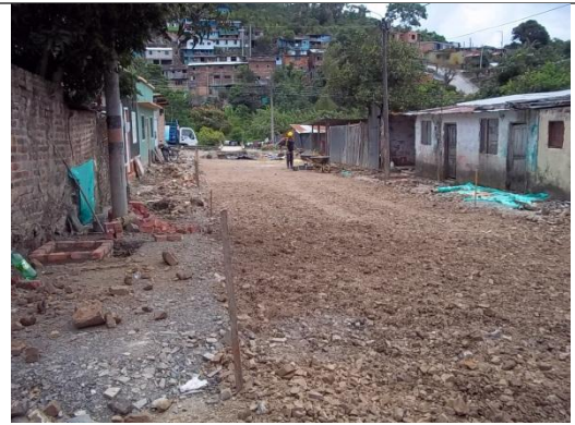
RELLENO EN MATERIAL SELECCIONADO
