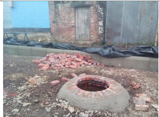
ADECUACIÓN DE POZO DE INSPECCIÓN INICIAL
