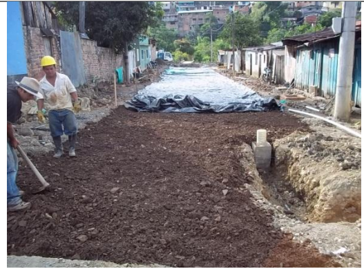
RELLENO EN MATERIAL SELECCIONADO
