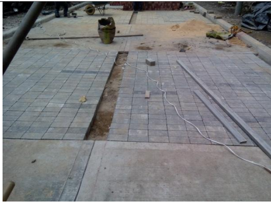
SUM/INST DE ADOQUIN PARA PAVIMENTO
