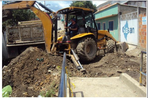
EXCAVACION Y RETIRO
