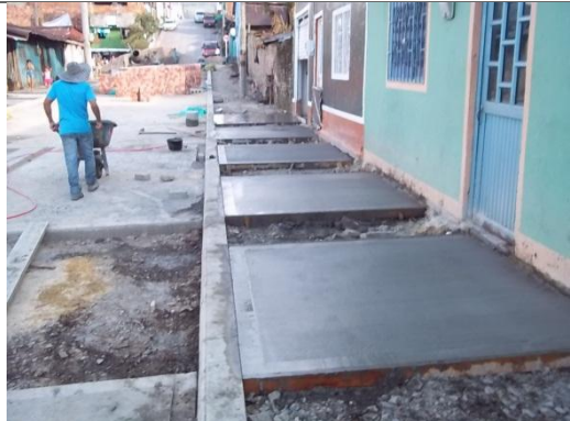
VACIADO DE CONCRETO
