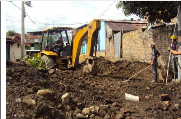
EXCAVACION Y RETIRO
