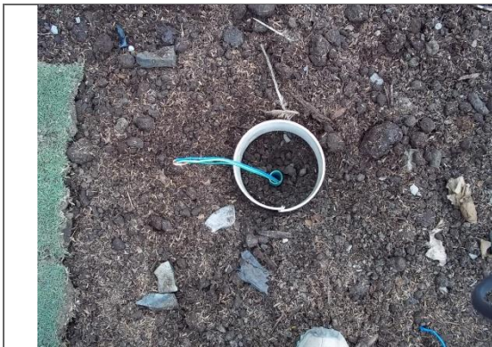
SUMINISTRO E INSTALACION DE BALAS DE PISOS DE 4" REFLECTORES
