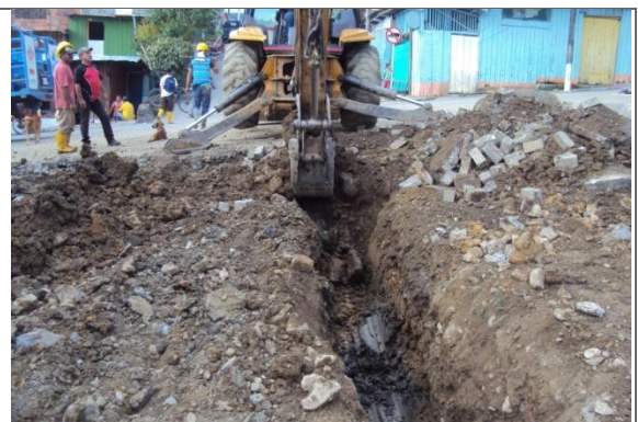
EXCAVACIONES PARA RED PRINCIPAL DE ACUEDUCTO
