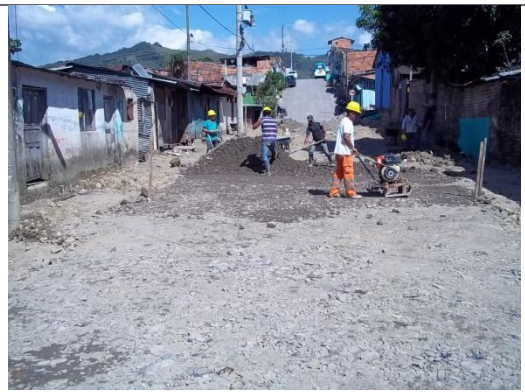
RELLENO EN MATERIAL SELECCIONADO
