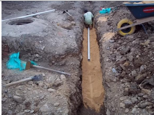
RELLENO PARA PROTECCION DE TUBERIA
