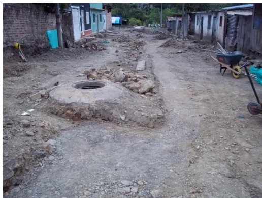
COMPACTACION DEL TERRENO
