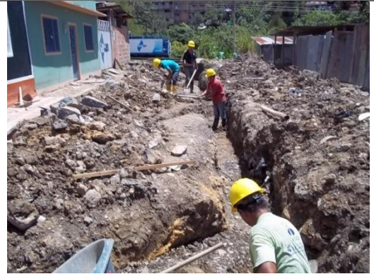
COMPACTACION DEL TERRENO PLANCHA TIPO RANA
