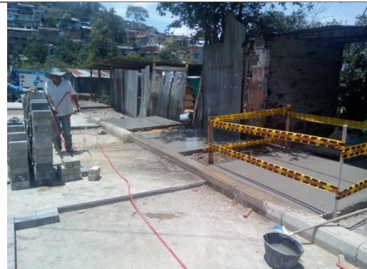
VACIADO DE CONCRETO
