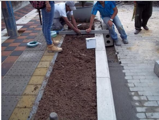
SUMINISTRO E INSTALACION DE CESPED
