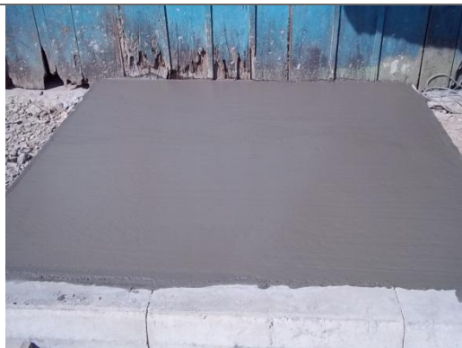
VACIADO DE CONCRETO
