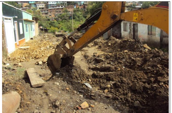
EXCAVACION Y RETIRO
