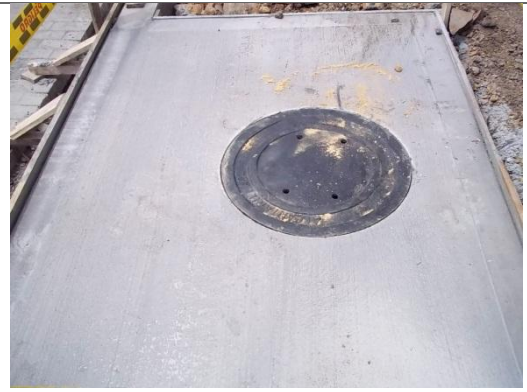
FORMALETA Y VACIADO DE CONCRETO
