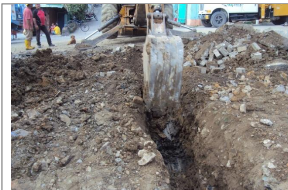
EXCAVACIONES PARA RED PRINCIPAL DE ACUEDUCTO
