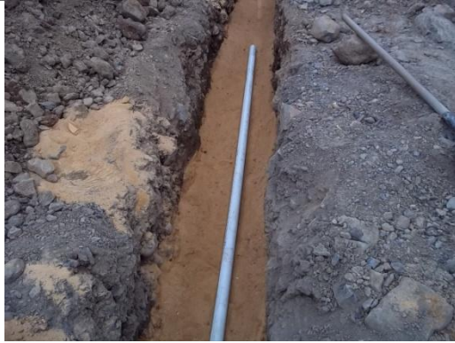
RELLENO PARA PROTECCION DE TUBERIA
