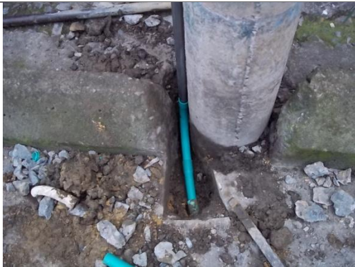
SALIDA PARA ALUMBRADO NORMAL
