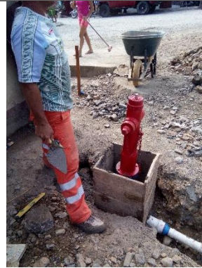
SUM/INST DE HIDRANTE
