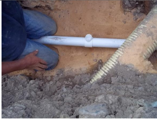
INSTALACION DE COLLARIN PARA DOMICILIARIA
