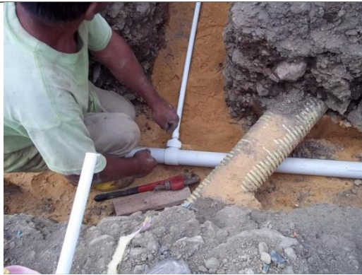
INSTALACION RED DOMICILIARIA EN TUBERIA PVC 1/2"
