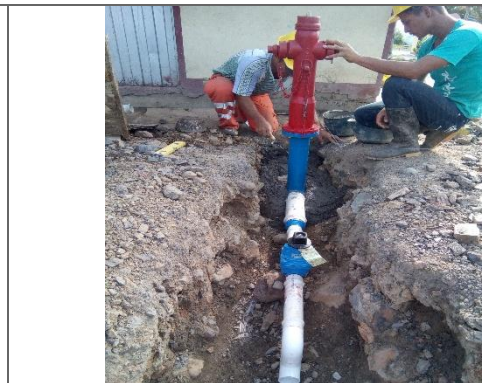
SUM/INST DE HIDRANTE
