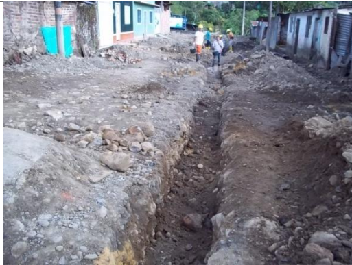
RELLENO EN MATERIAL COMUN
