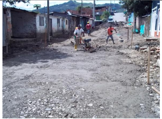
COMPACTACION DEL TERRENO
