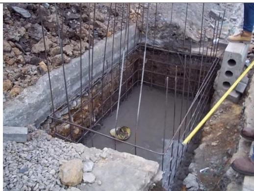
PARRILLA Y VACIADO DE CONCRETO
