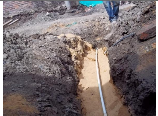
INSTALACION RED DOMICILIARIA EN TUBERIA PVC 1/2"
