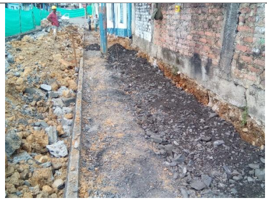
RELLENO MATERIAL SELECCIONADO
