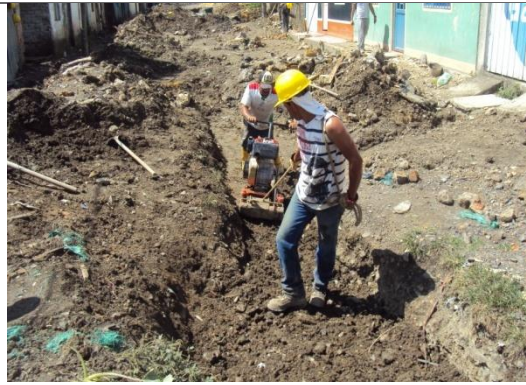
COMPACTACION DEL TERRENO PLANCHA TIPO RANA
