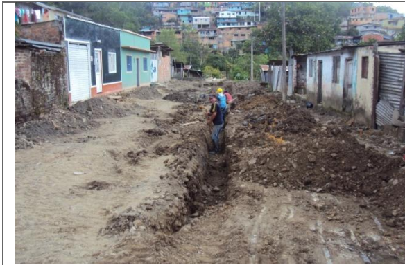
EXCAVACIONES PARA RED PRINCIPAL Y DOMICILIARIA DE ACUEDUCTO
