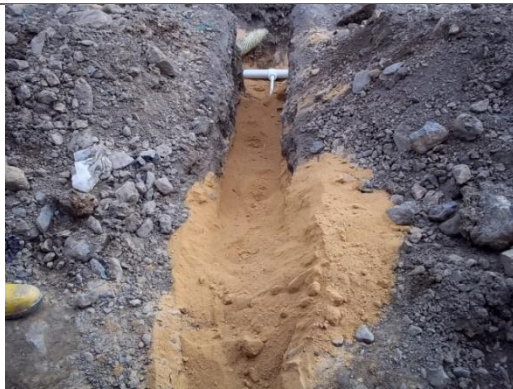
RELLENO PARA PROTECCION DE TUBERIA
