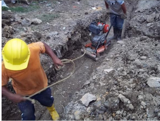
COMPACTACION DEL TERRENO PLANCHA TIPO RANA
