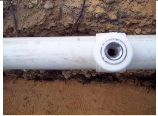
INSTALACION DE COLLARIN PARA DOMICILIARIA
