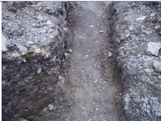
COMPACTACION DEL TERRENO PLANCHA TIPO RANA
