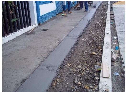
SUMINISTRO DE MORTERO DE NIVELACION PARA PISO DE ANDÉN
