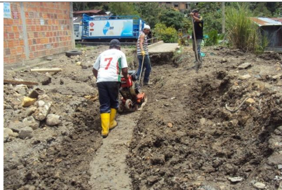
COMPACTACION DEL TERRENO PLANCHA TIPO RANA
