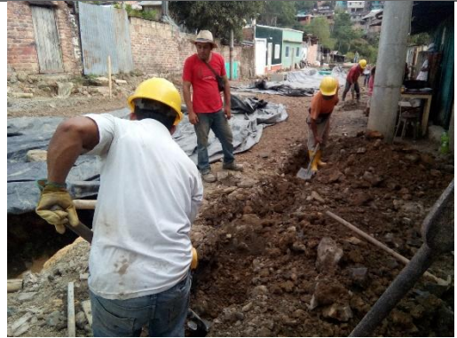
EXCAVACIÓN PARA SUM/INST DE SARDINEL
