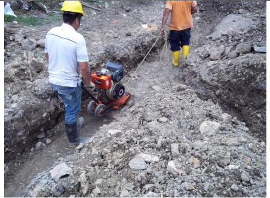
COMPACTACION DEL TERRENO PLANCHA TIPO RANA
