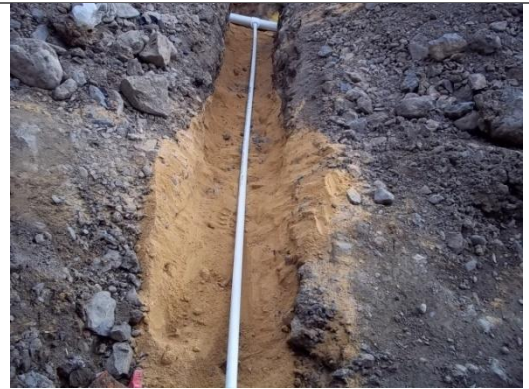
INSTALACION RED DOMICILIARIA EN TUBERIA PVC 1/2"
