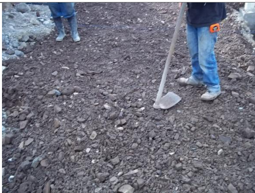
RELLENO EN MATERIAL SELECCIONADO
