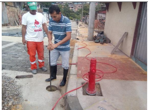
SUM/INST DE HIDRANTE
