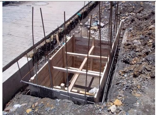
FORMALETA Y VACIADO DE CONCRETO
