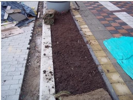
SUMINISTRO E INSTALACION DE CESPED
