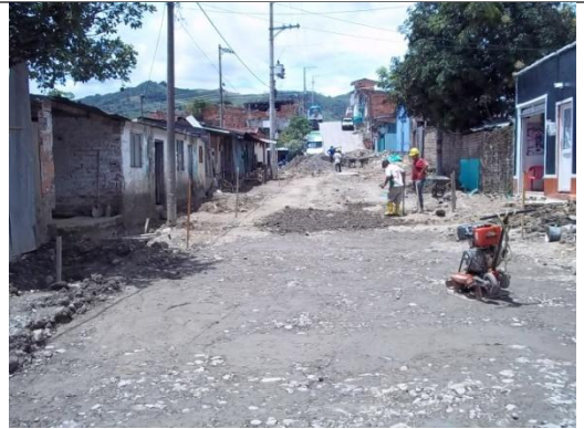
COMPACTACION DEL TERRENO
