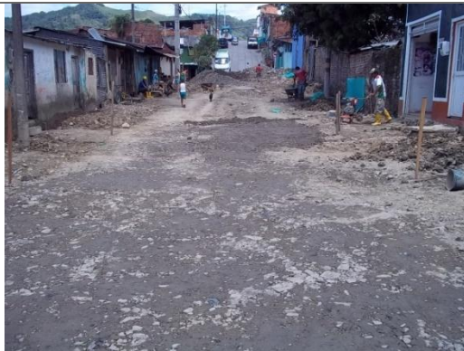
COMPACTACION DEL TERRENO
