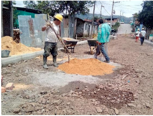
ADECUACIÓN DE POZO DE INSPECCIÓN INICIAL
