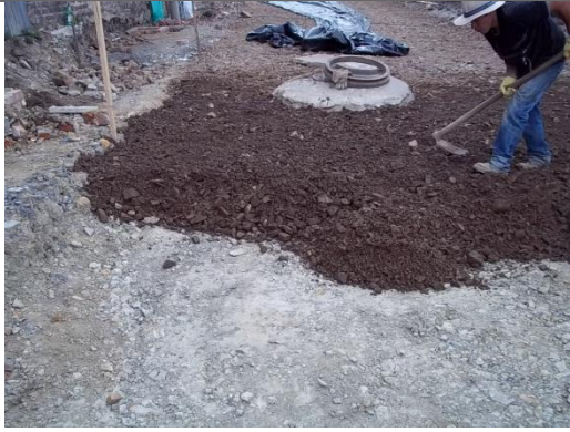
RELLENO EN MATERIAL SELECCIONADO
