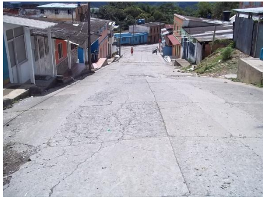
DEMOLICION DE PAVIMENTO
