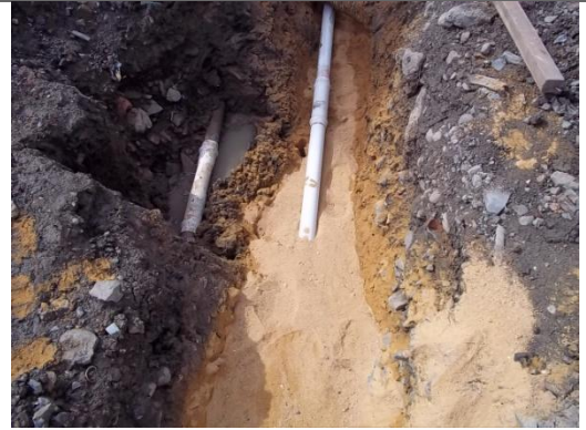
RELLENO PARA PROTECCION DE TUBERIA
