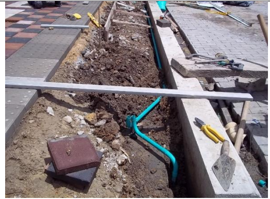
SALIDA PARA ALUMBRADO NORMAL
