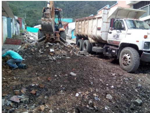
CARGUE Y TRANSPORTE MATERIAL DE DESECHO
