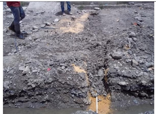
RELLENO EN MATERIAL COMUN
