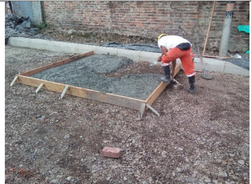
VACIADO DE CONCRETO HIDRÁULICO
