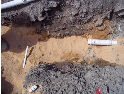
RELLENO PARA PROTECCION DE TUBERIA
