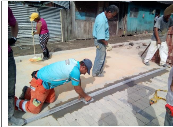
VIGA PARA PAVIMENTO
