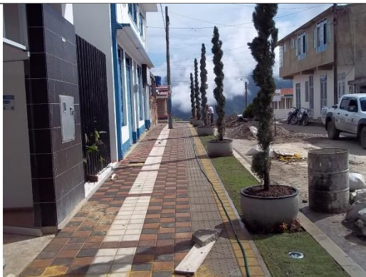
SUMINISTRO E INSTALACION DE CESPED
