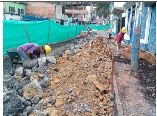
RELLENO MATERIAL SELECCIONADO
