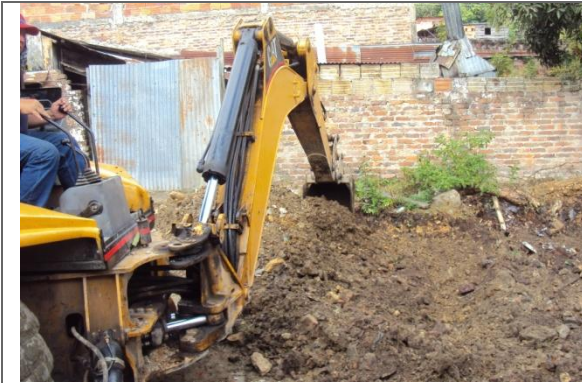
EXCAVACION Y RETIRO
