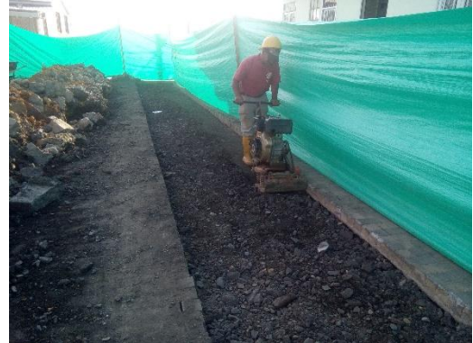
RELLENO MATERIAL SELECCIONADO
