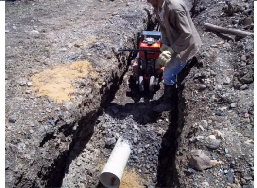
COMPACTACION DEL TERRENO PLANCHA TIPO RANA
