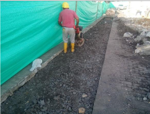
RELLENO MATERIAL SELECCIONADO
