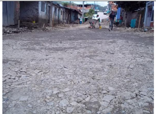
COMPACTACION DEL TERRENO
