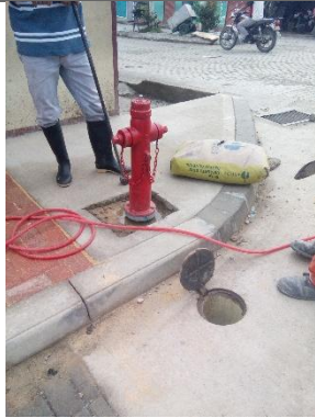
SUM/INST DE HIDRANTE
