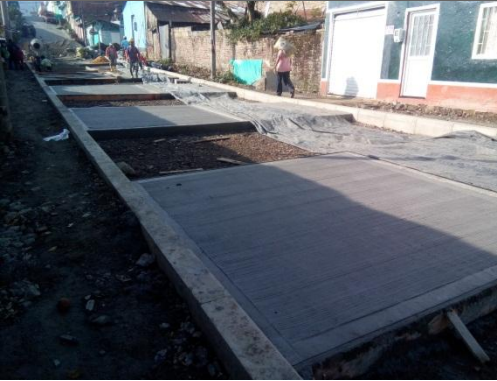
VACIADO DE CONCRETO HIDRÁULICO
