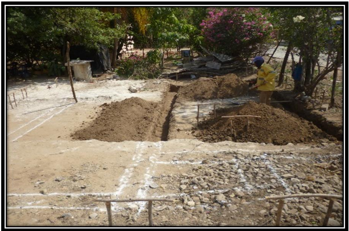
Imagen 7. Visita de obra verificación de medidas de excavación
