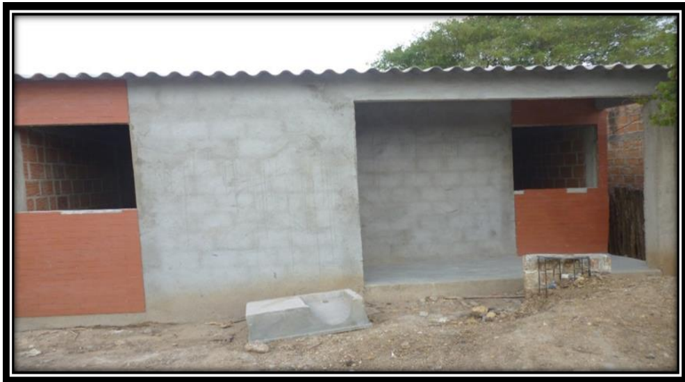
Imagen 34. Estado de viviendas de la 57-80
