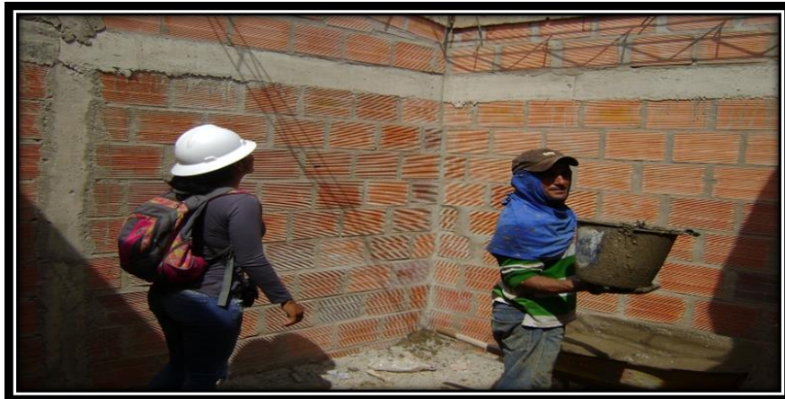
Imagen 29. Visita de obra.
