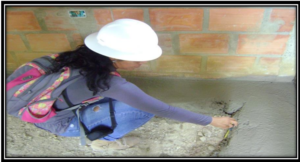
Imagen 18. Verificación de espesor de plantilla. (E=0.06 m)
