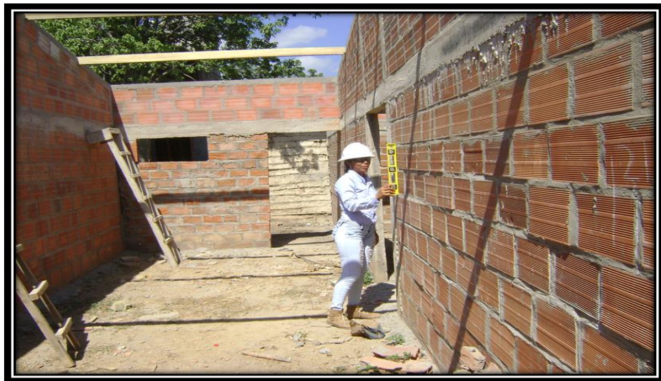
Imagen 11. Verificación de niveles en muros.
