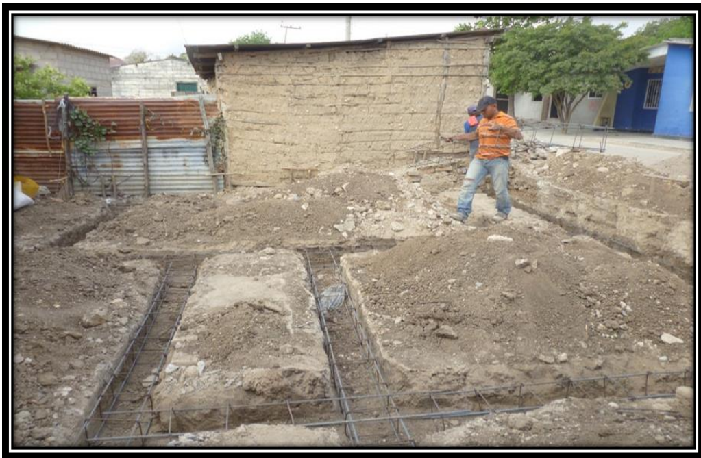
Imagen 8. Verificación de armado de hierro en vigas de cimentación.
