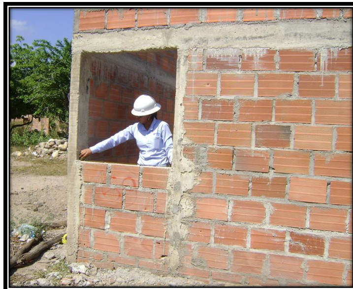
Imagen 25. Verificación de medidas para instalación de ventanas
