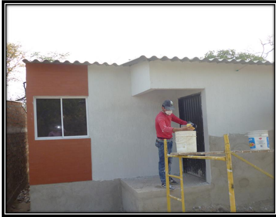
Imagen 27. Pintura en Graniplast.
