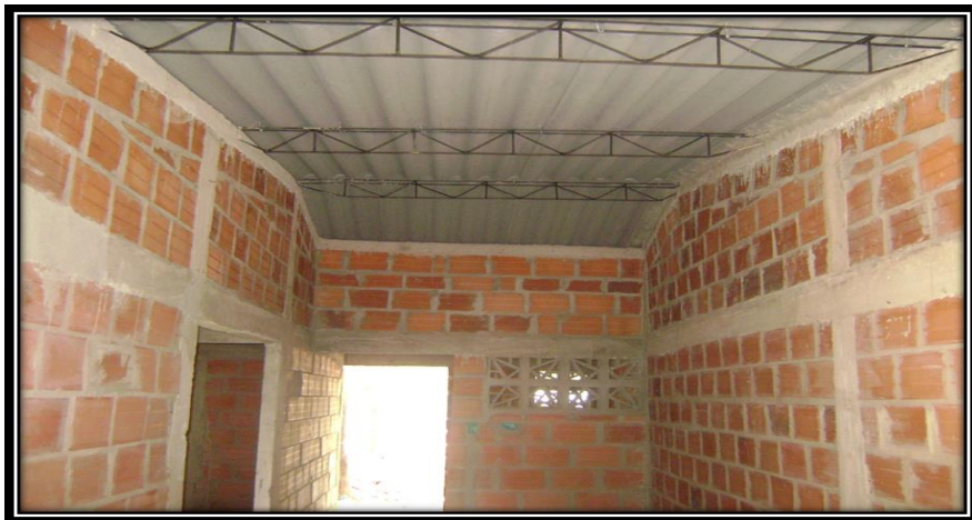
Imagen 17. Cubierta en asbesto cemento, verificación de amarres
