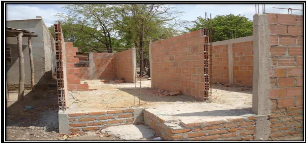
Imagen 10. Levante de muros
