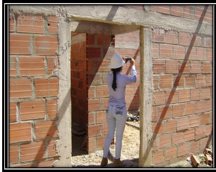
Imagen 24. Visita de obra, toma de detalles
