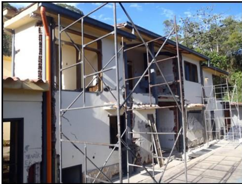
Ilustración 4: Adecuación Y Reforzamiento Fuente: (Viedifica, 2016)
