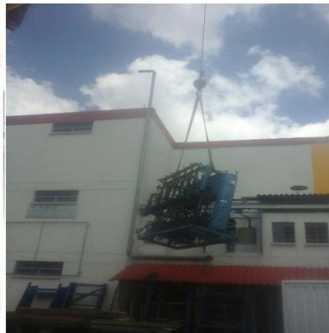
Ilustración 10 Rack de 4 compresores, Tomado de: [3]
