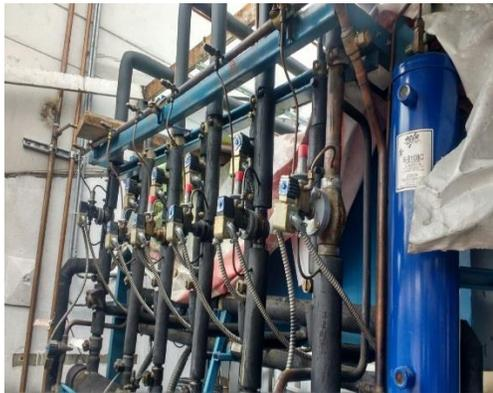
*Ilustración 25. Válvulas Sporlan Fuente: Autor*
