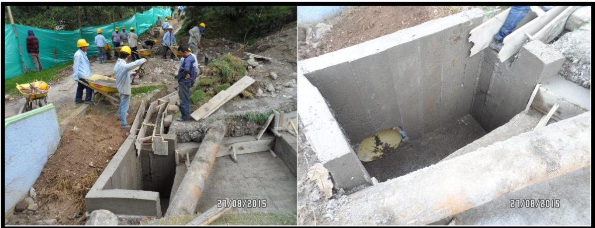
Imagen 47. Fundida caja colectora
