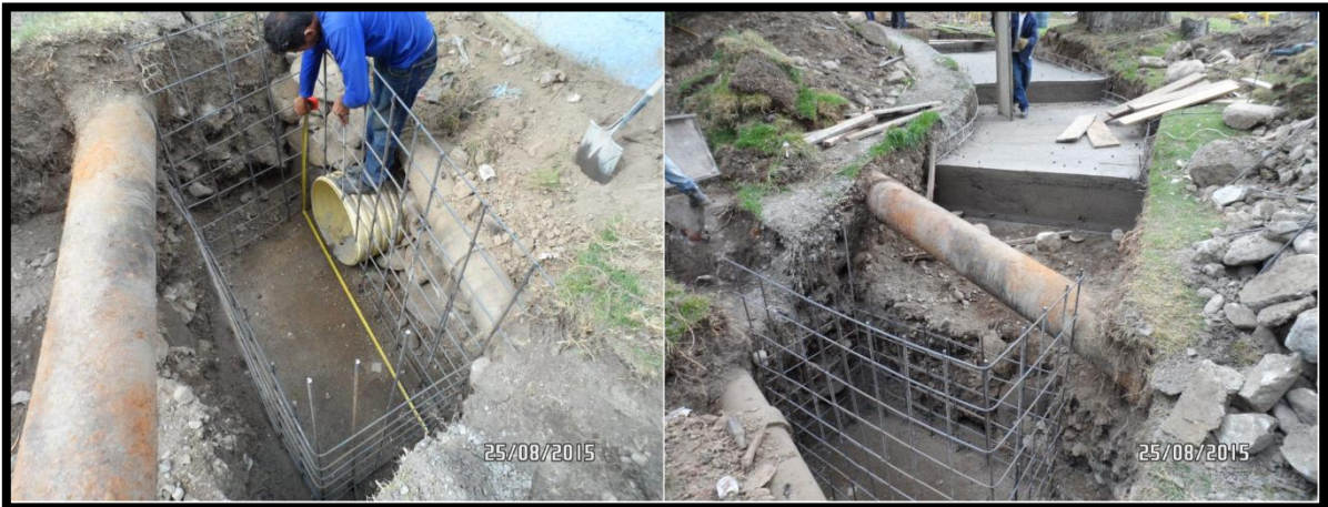
Imagen 46. Refuerzo caja colectora
