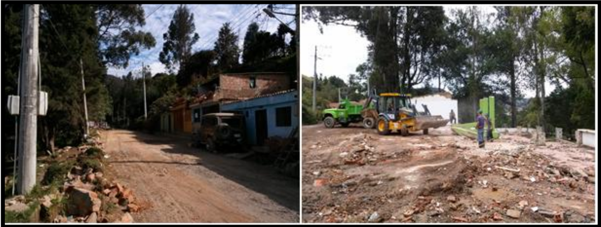
Imagen 2. Demolición cerramiento y caseta existente
