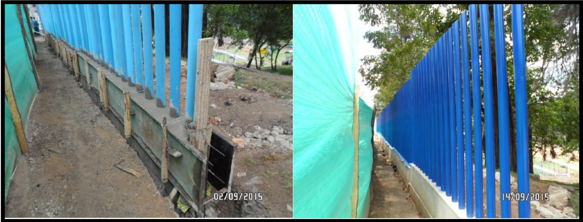
Imagen 61. Fundida muro de elevación y pintada tubería cerramiento principal
