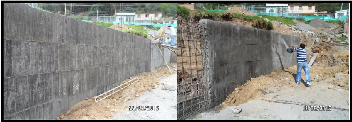
Imagen 27. Estado final y Curado del muro de contención.
