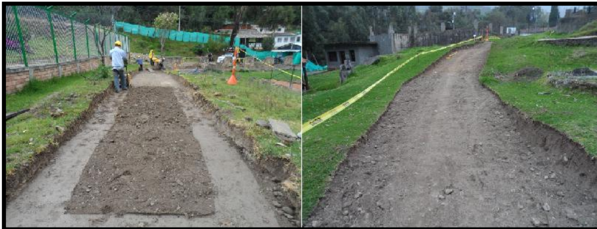
Imagen 14. Relleno y compactación senderos peatonales
