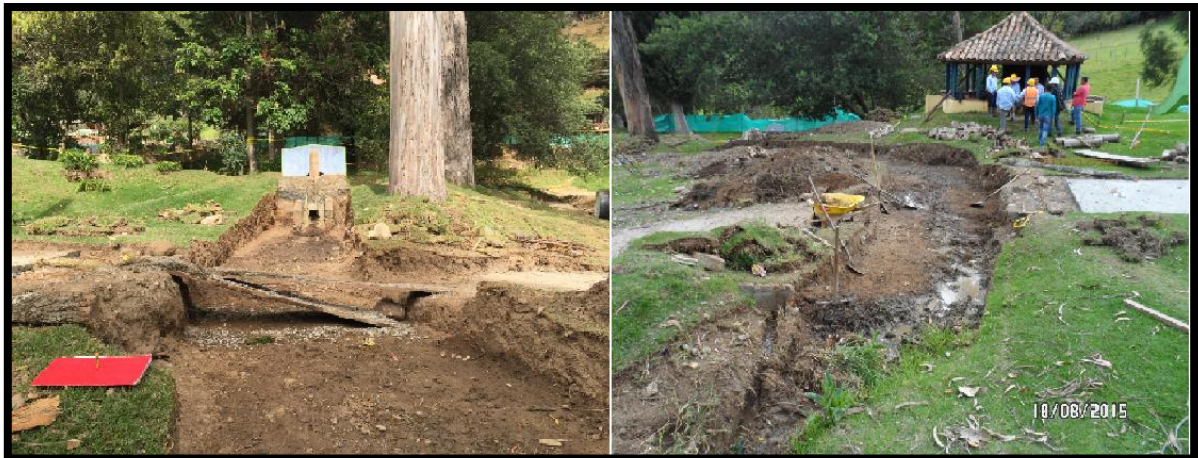
Imagen 37. Descapote y excavación sendero de aguas abajo
