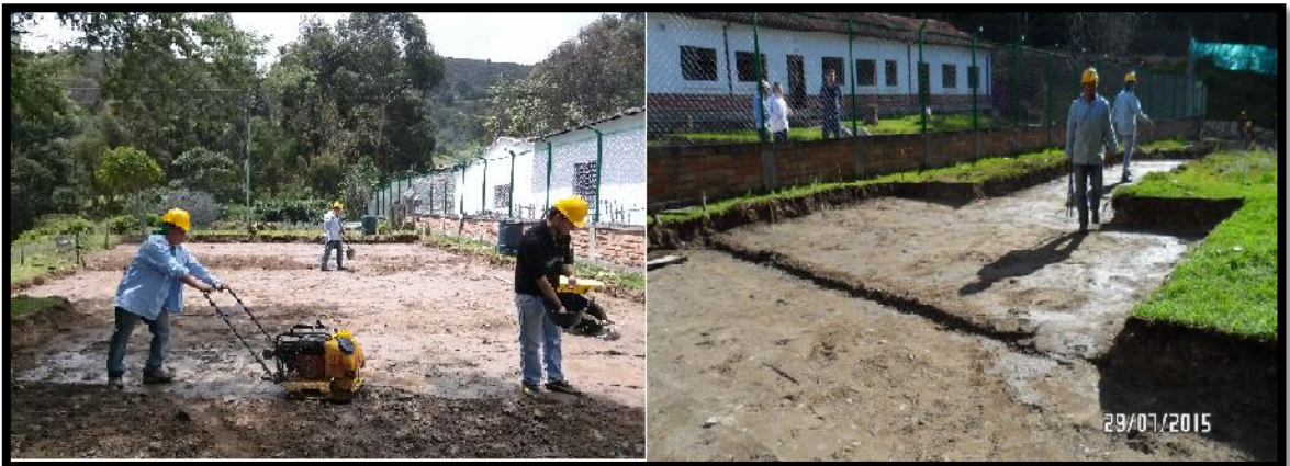
Imagen 8. Relleno y compactación zona de juegos bio saludables.
