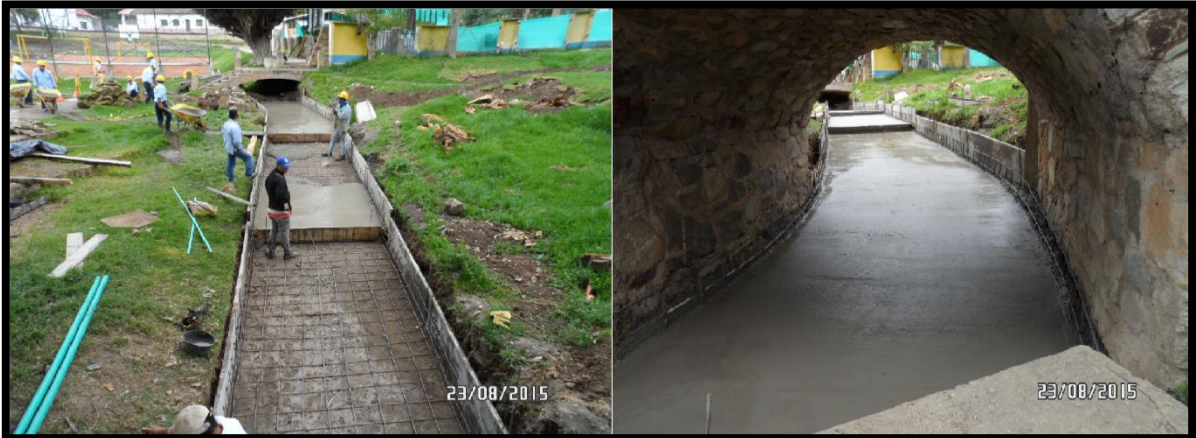
Imagen 40. Refuerzo y fundida sendero de aguas arriba
