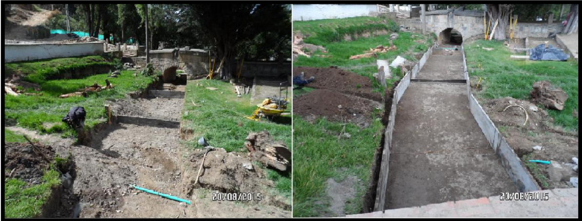
Imagen 38. Excavación, relleno y compactación sendero de aguas arriba
