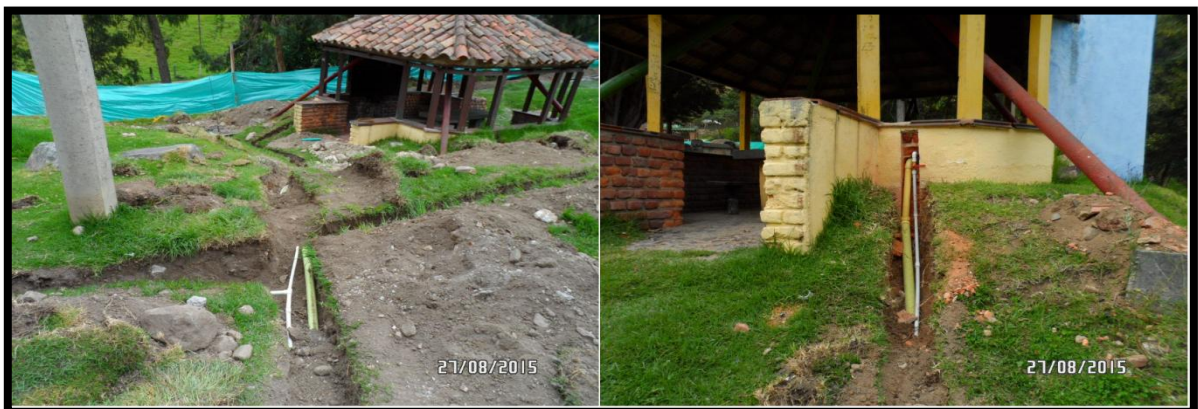
Imagen 72. Excavación e instalación tubería de aguas frías (con válvula de registro) y desagües
