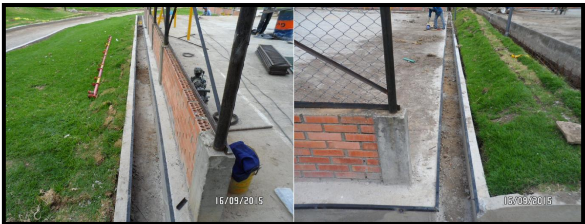
Imagen 55. Instalación ángulos para rejilla.
