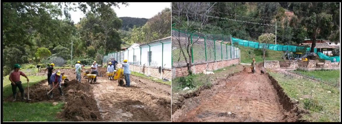
Imagen 7. Excavaciones zona de juegos bio saludables y su ruta de acceso
