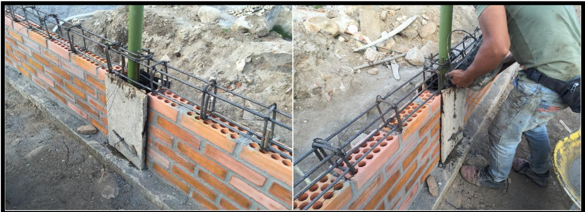
Imagen 32. Viga corona y columneta
