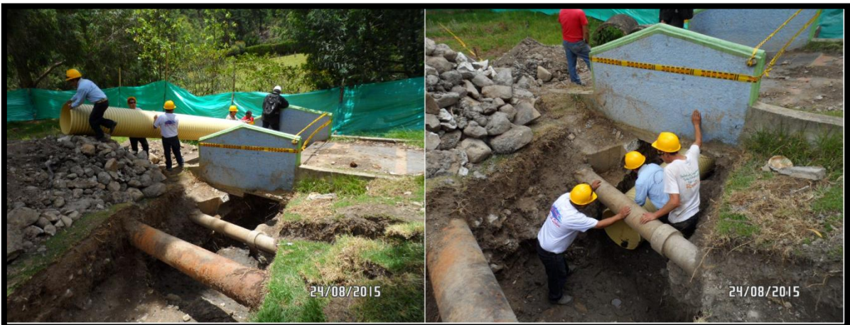
Imagen 45. Instalación tubería caja colectora
