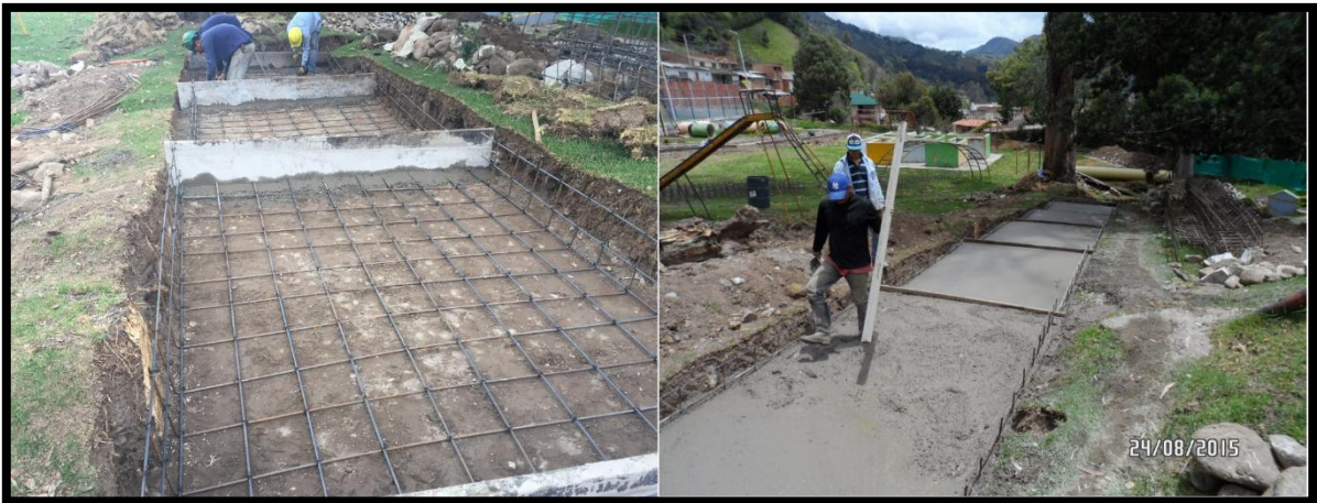
Imagen 41. Refuerzo y fundida sendero de aguas abajo
