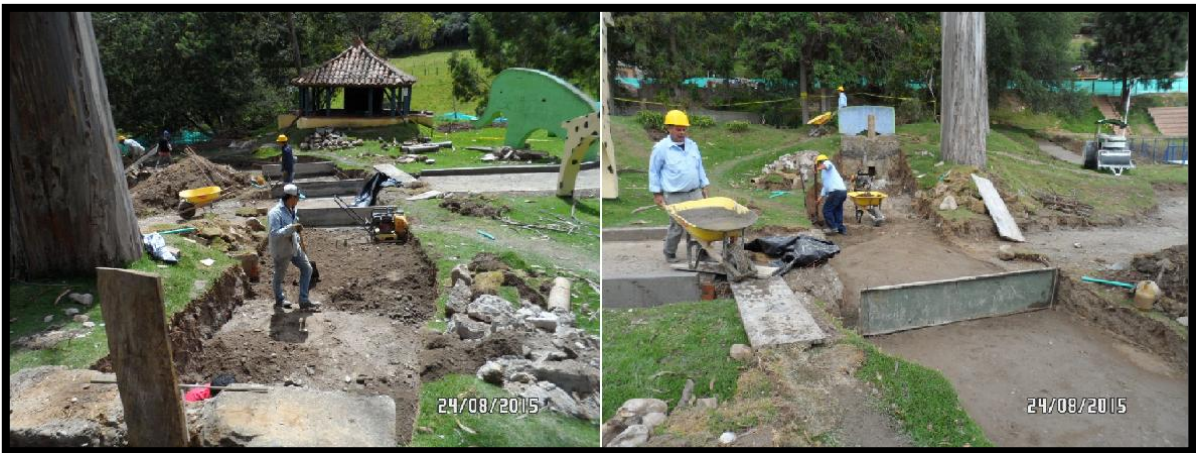
Imagen 39. Excavación, relleno y compactación sendero aguas abajo
