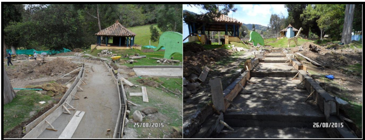
Imagen 43. Instalación Formaleta sardinel sendero de aguas abajo
