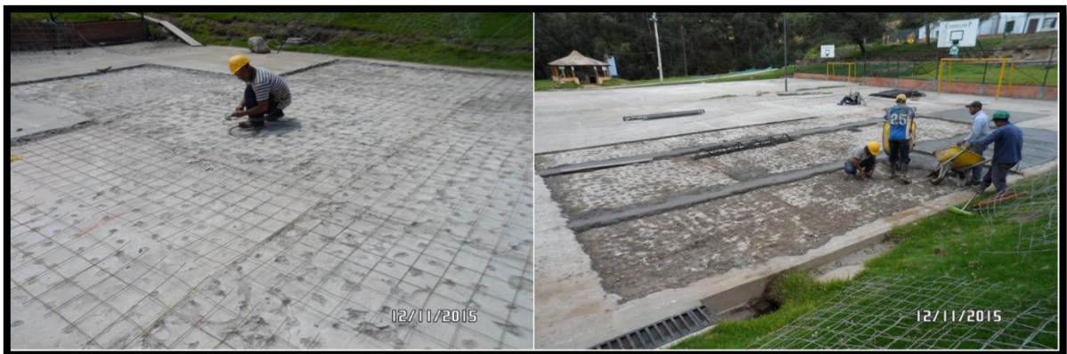
Imagen 71. Instalación malla electro soldada y fundida losas canchas multifuncionales
