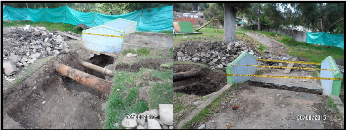
Imagen 44. Excavación Caja colectora
