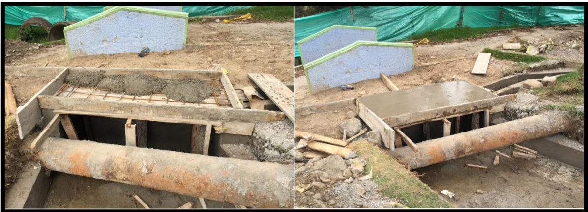
Imagen 48. Fundida tapa caja colectora
