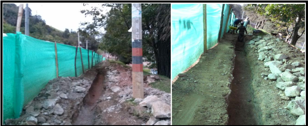
Imagen 57. Excavación muro cerramiento
