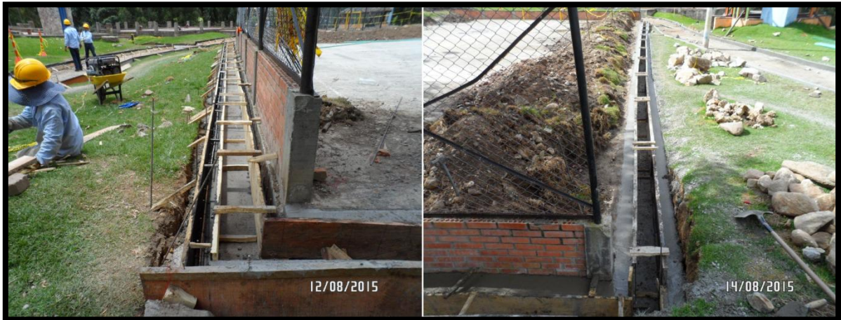
Imagen 54. Instalación de formaleta aletas canal rectangular
