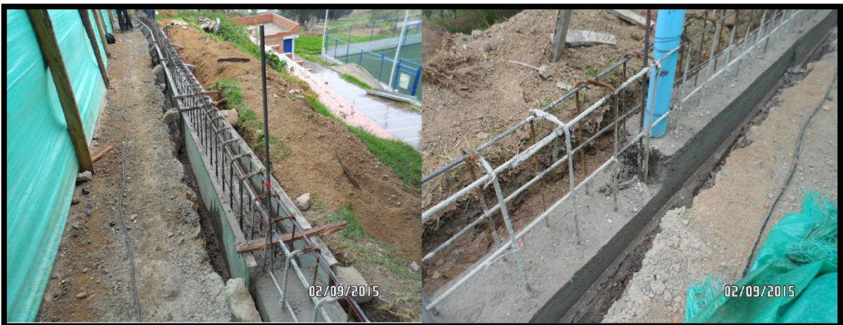
Imagen 60. Instalación formaleta y tubería muro elevación cerramiento principal
