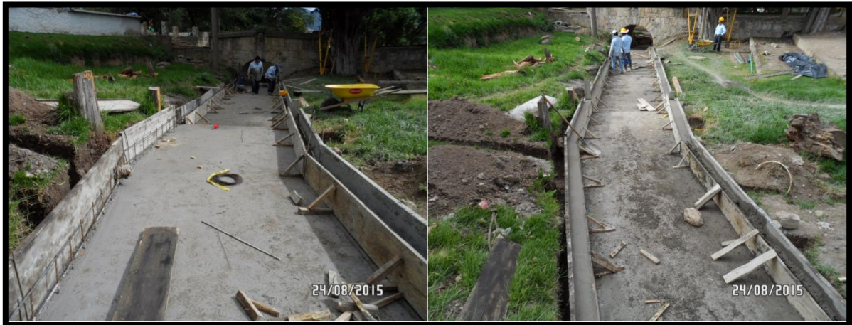
Imagen 42. Instalación Formaleta Sardinel sendero de aguas arriba
