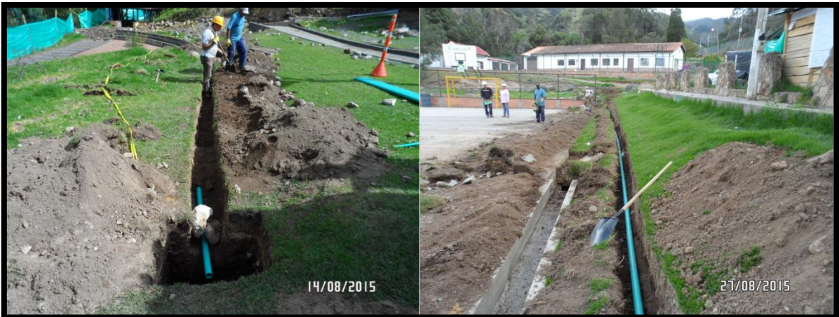
Imagen 62. Canalización tubería red eléctrica
