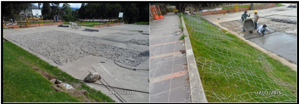
Imagen 70. Demoliciones losas deterioradas canchas multifuncionales
