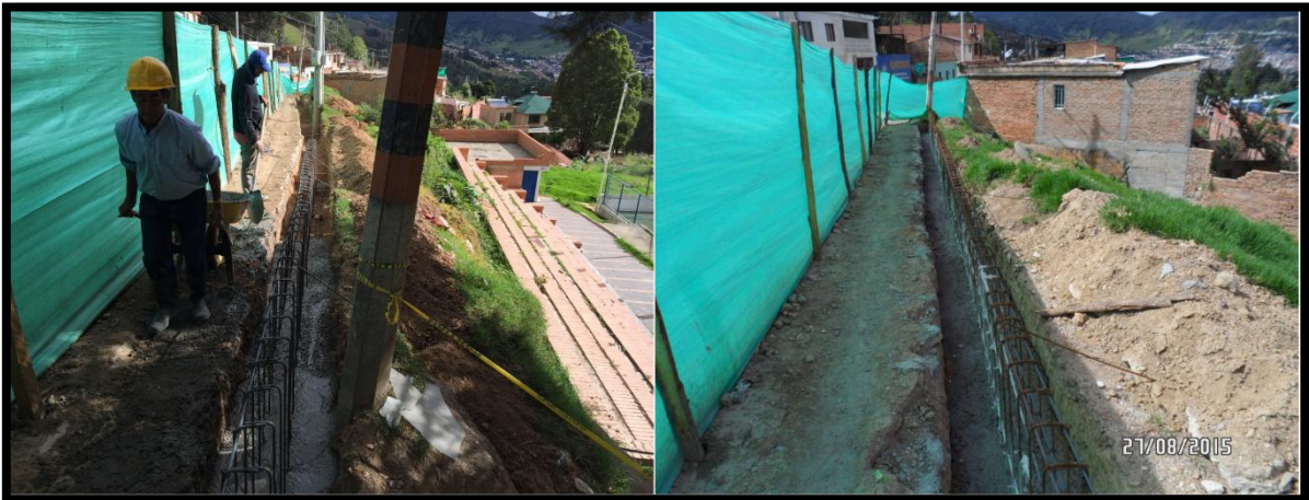
Imagen 59. Fundida zapata muro cerramiento principal
