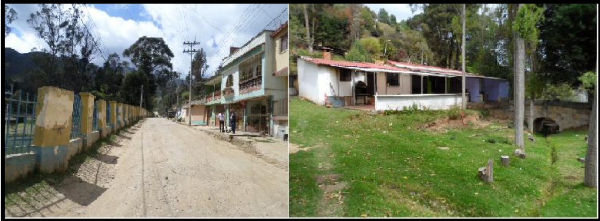
Imagen 1: Vista Preliminar cerramiento y caseta existente
