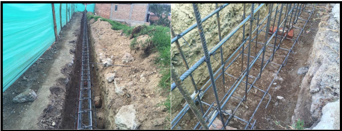
Imagen 58. Refuerzo zapata y muro de elevación cerramiento principal
