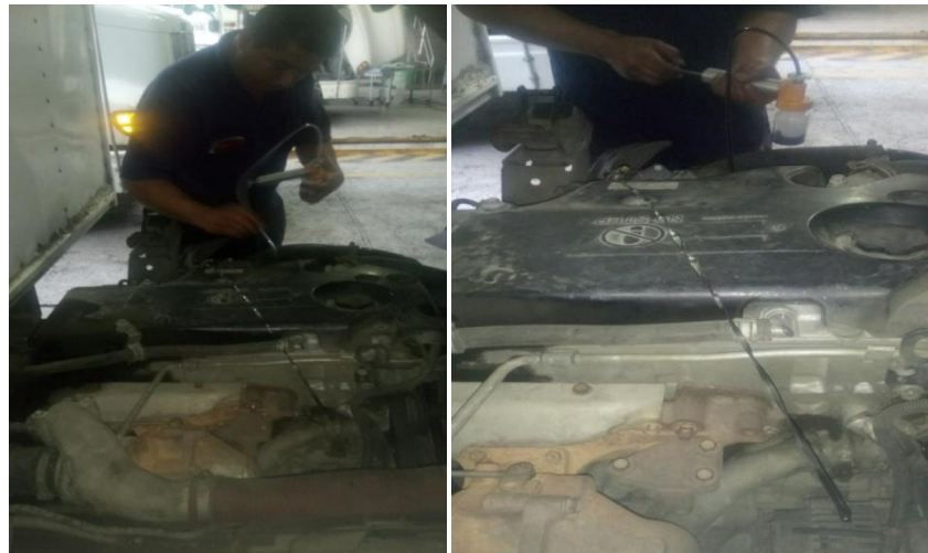
Figura 30. Toma de muestra de aceite, Móvil 2283.
