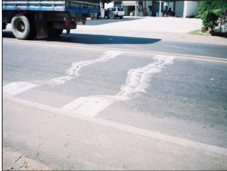
Figura 17. Ahuellamiento (AHU, Unidad de medida: m 2 )
