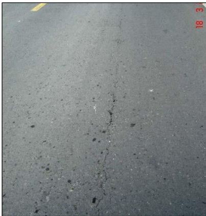
Figura 4 Fisura transversal (FT, Unidad de medida: m)
