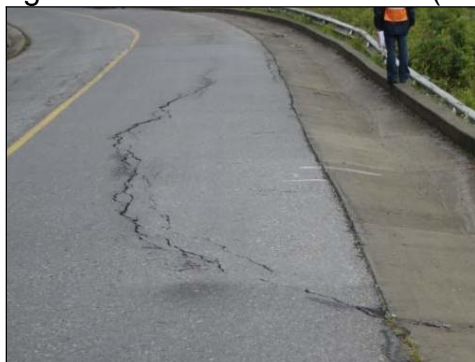
Figura 8. Fisura en medialuna (FML, Unidad de medida: m 2 )
