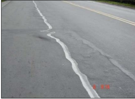
Figura 14. Ondulación (OND, Unidad de medida: m 2 )
