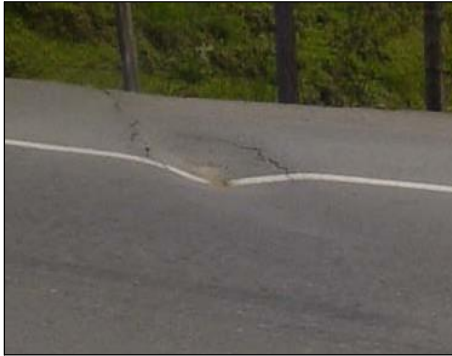
Figura 16. Hundimiento (HUN, Unidad de medida: m2)
