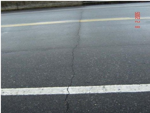
Figura 4 Fisura transversal (FT, Unidad de medida: m)
