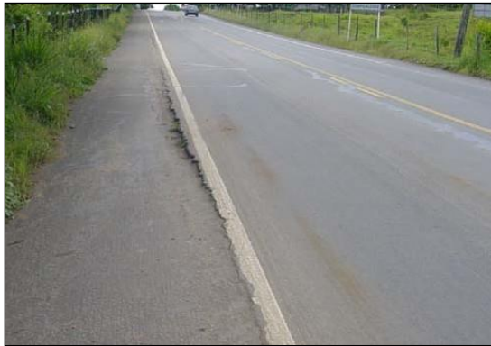
Figura 27. Corrimiento vertical de la berma (CV, Unidad de medida: m)
