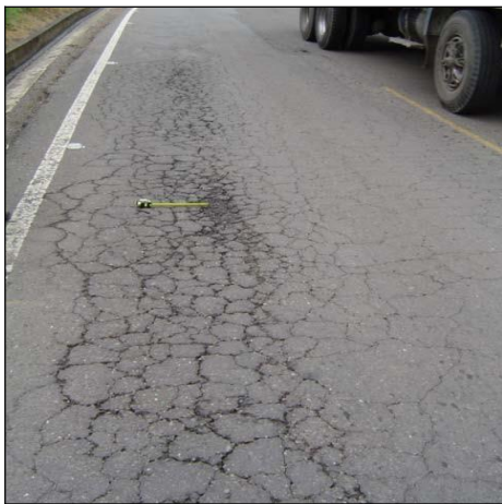
Figura 11. Piel de cocodrilo (PC, Unidad de medida: m 2 )
