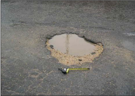
Figura 19. Bache (BCH, Unidad de medida: m 2 )
