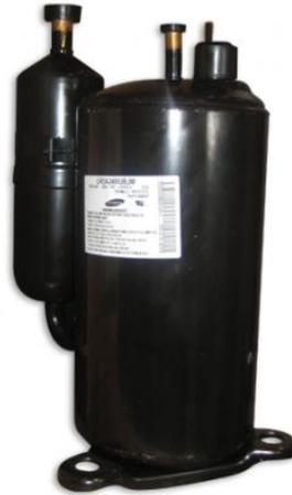
**Figura 2-22:** Cuerpo del compresor. Tomada de [39].
