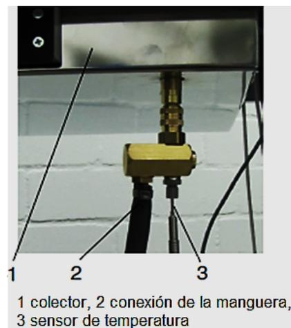
**Figura 3-8:** Sensores de temperatura avance y retorno de colector. Tomado de [1].
