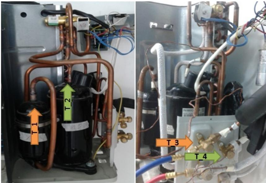
**Figura 4-1:** Esquema de entradas y salidas del refrigerante al compresor y al colector solar de la unidad de aire acondicionado. Fuente: Autor
