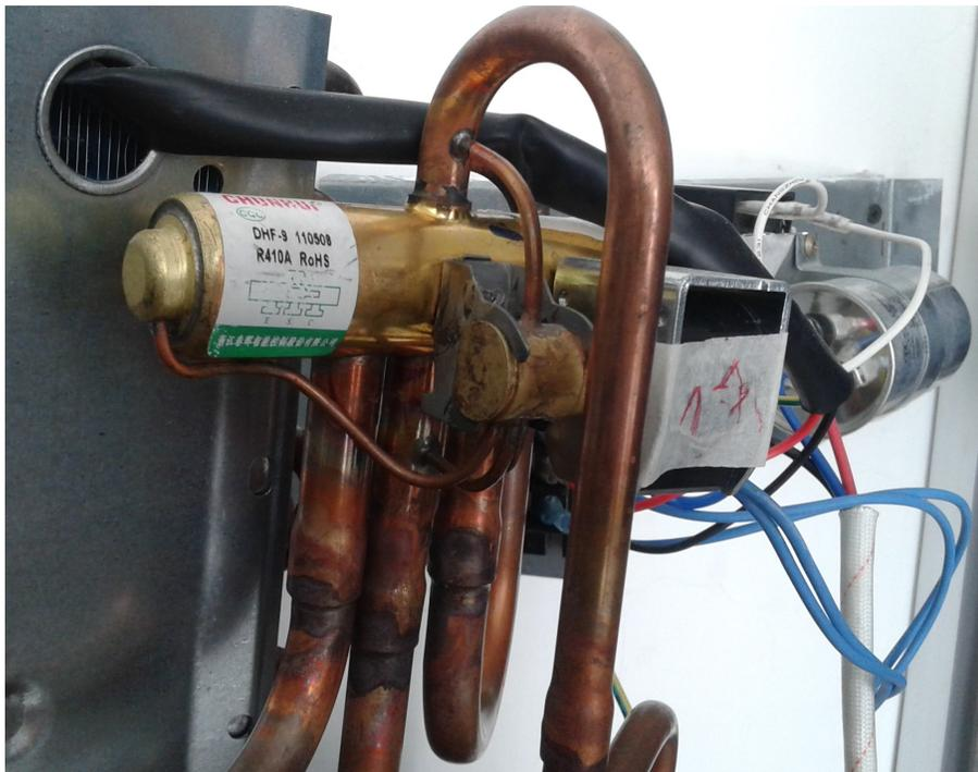
**Figura 2-30:** Válvula de cuatro vías del aire acondicionado híbrido térmico solar. Fuente: Autor.
