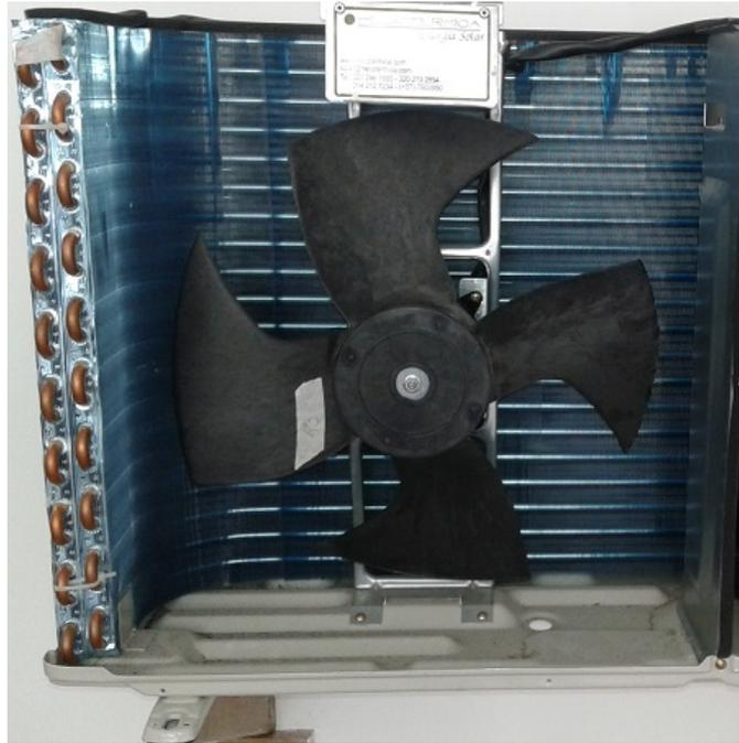
**Figura 2-24:** Condensador. Fuente Autor.
