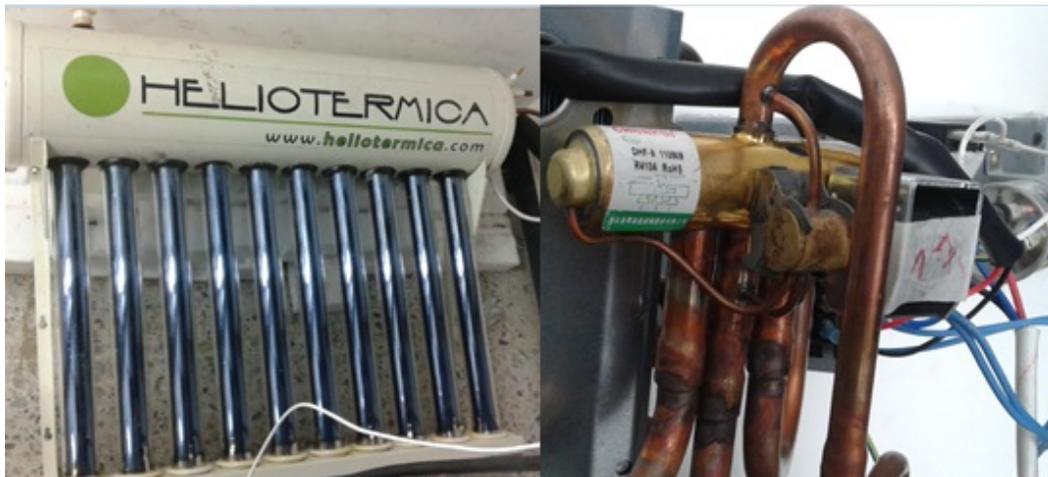
**Figura 3-2:** Colector Solar, Válvula 4 vías, Fuente: Autor.
