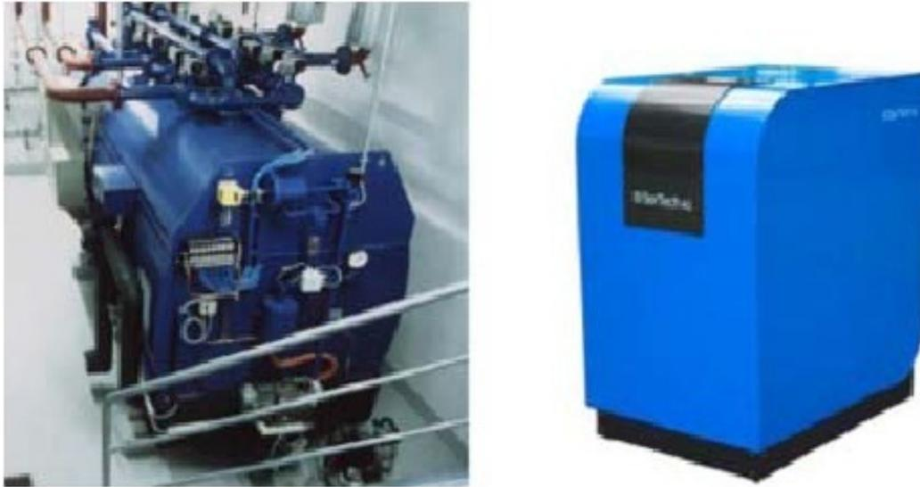
**Figura 2-13:** Ejemplos de enfriadoras de adsorción. Tomado de [27]
