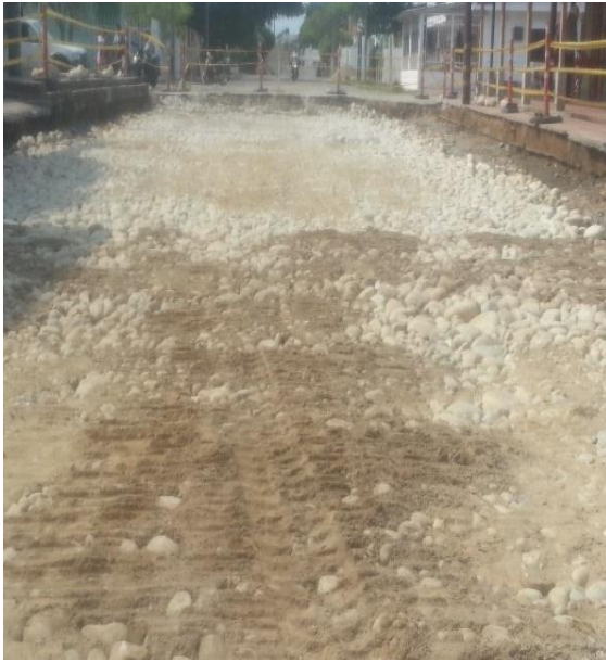
Imagen 21: compactacion del material
