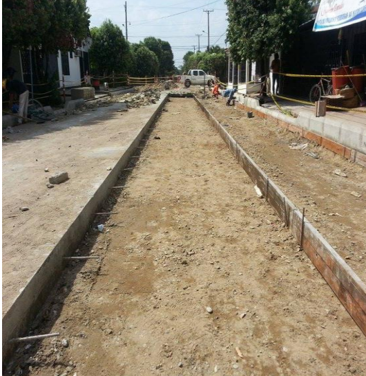
Imagen 28: seriado y compactado de la base
