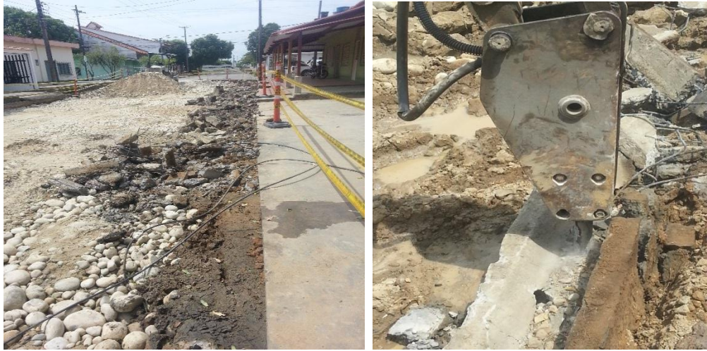
Imagen 24: demolición de cunetas
