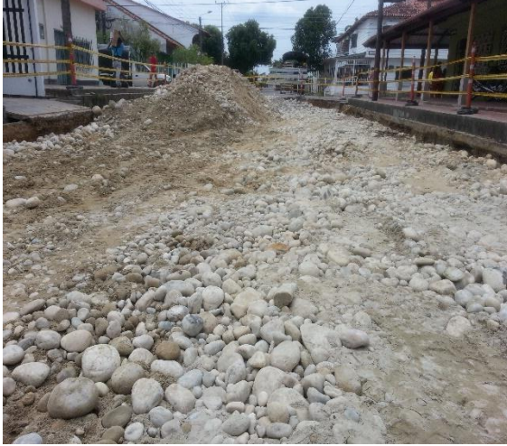
Imagen 20: mejoramiento del suelo
