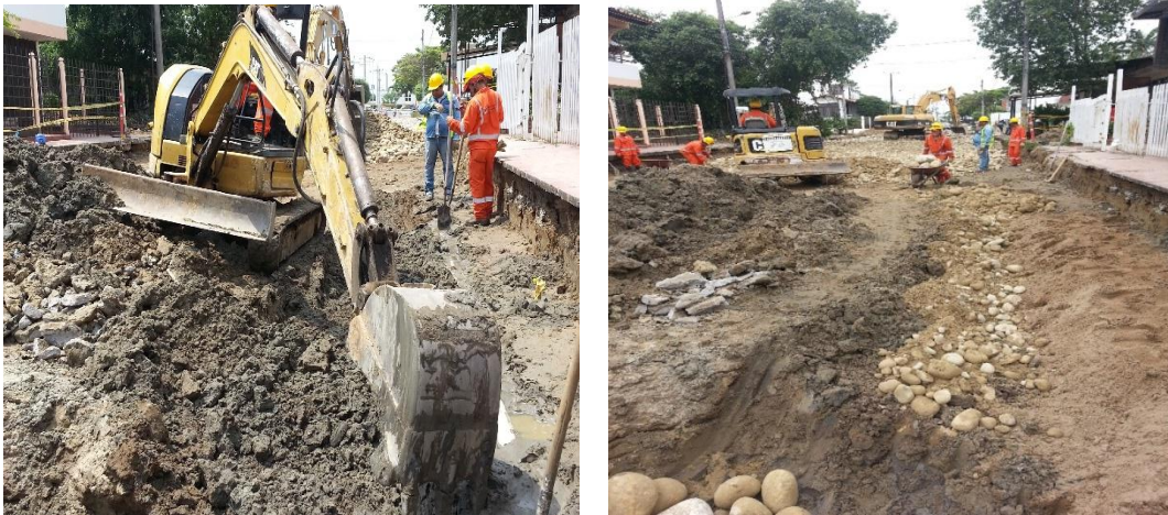
Imagen 35: excavación e instalación de acometidas
