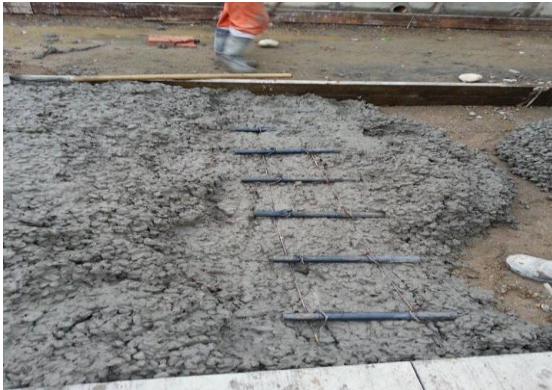
Imagen 31: colocación del acero
