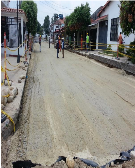
Imagen 23: extendido del material base
