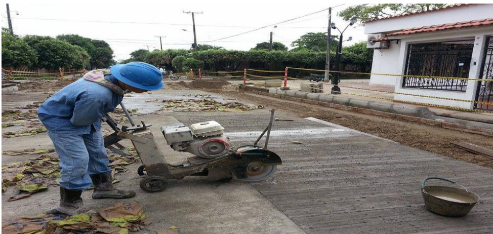
Imagen 33: corte y dilatación de la losa
