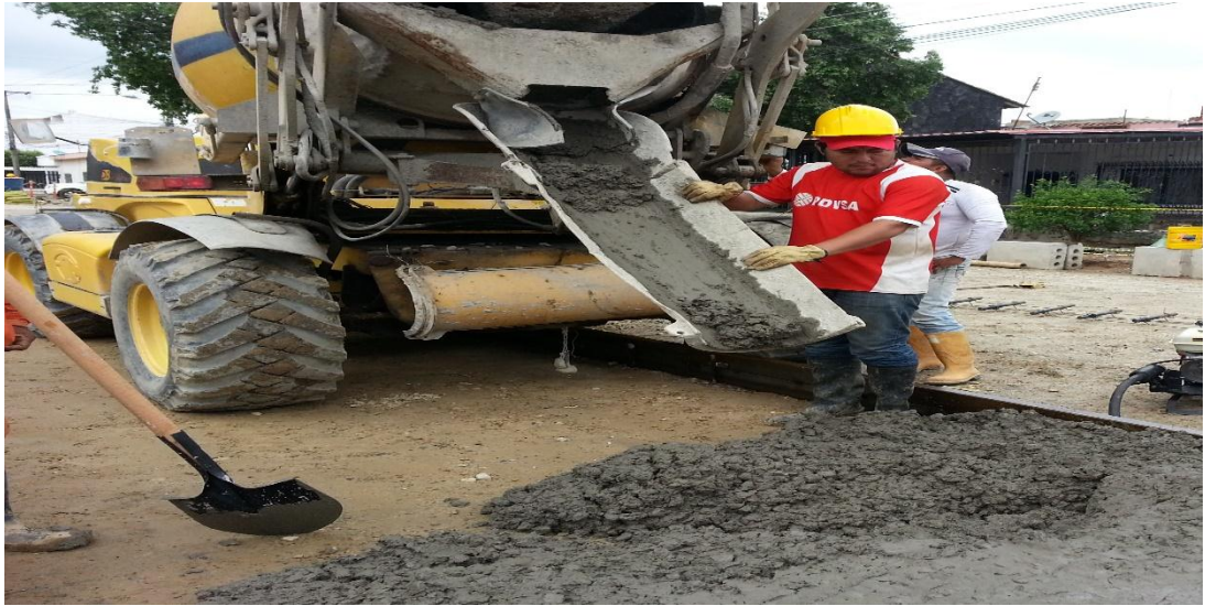
Imagen 17: auto hormigonera (carmix)
