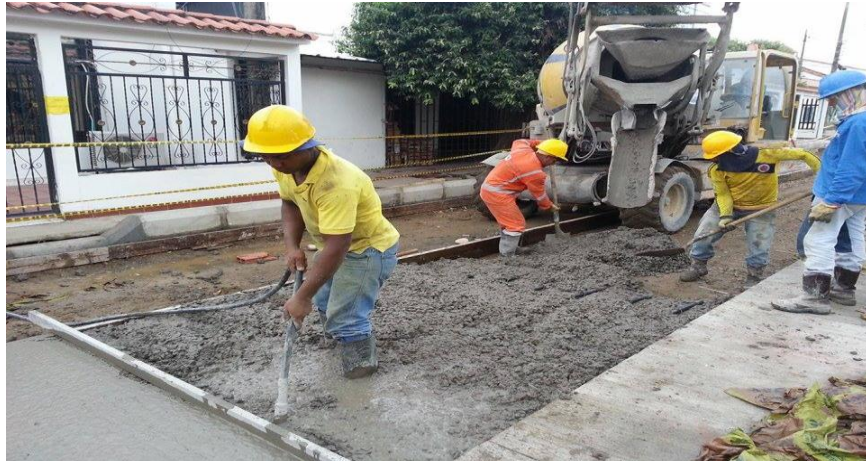
Imagen 30: vibrado de concreto
