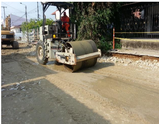
Imagen 36: nivelación del terreno
