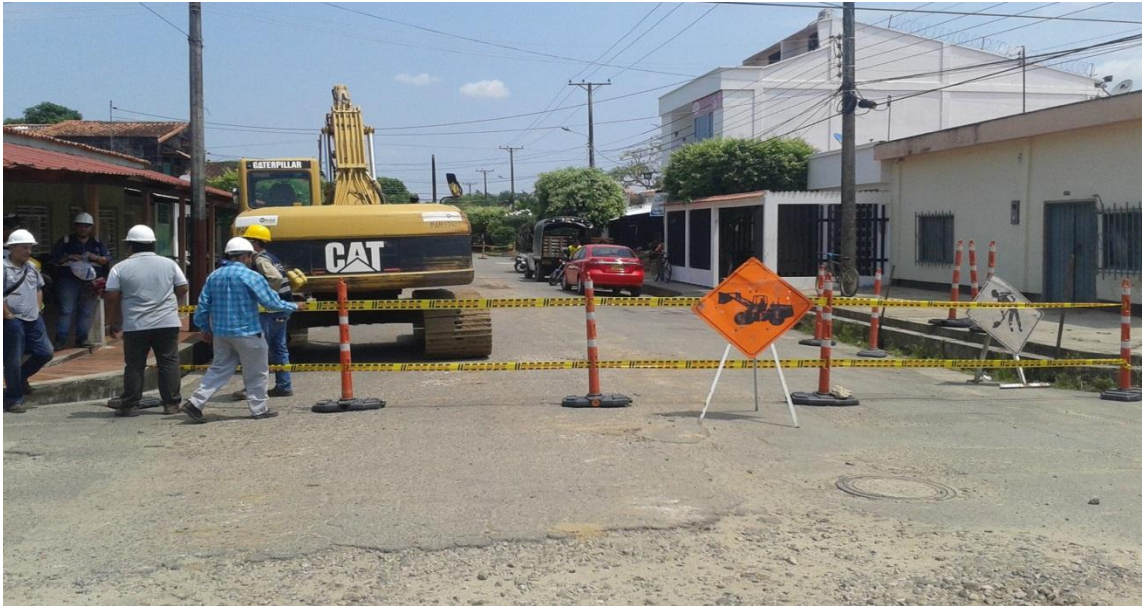
Imagen 12: señalización de zona de trabajo
