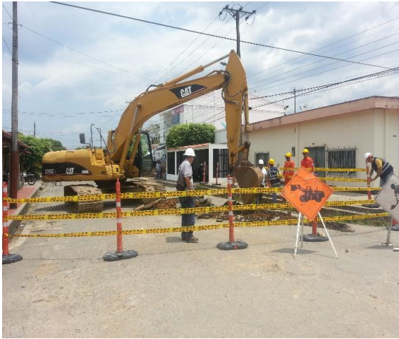
Imagen 18: excavación con retroexcavadora
