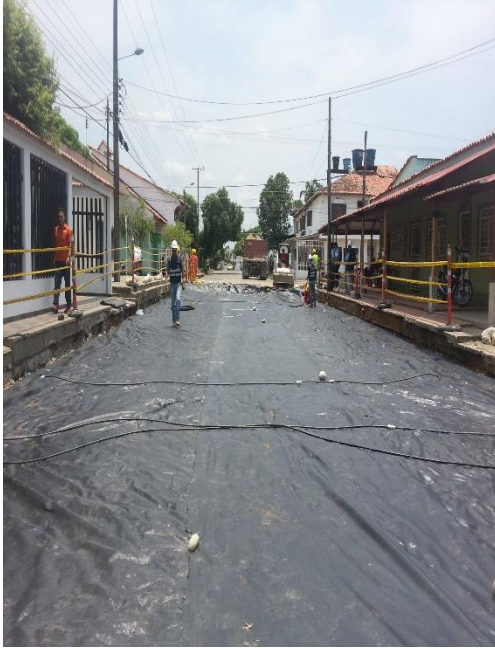
Imagen 22: extendido del geotextil
