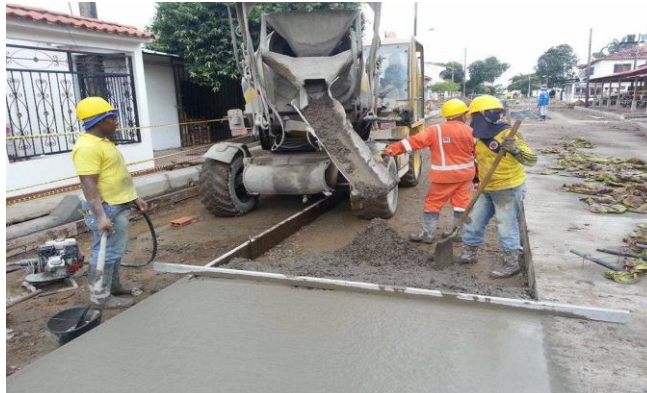
Imagen 29: fundición del concreto
