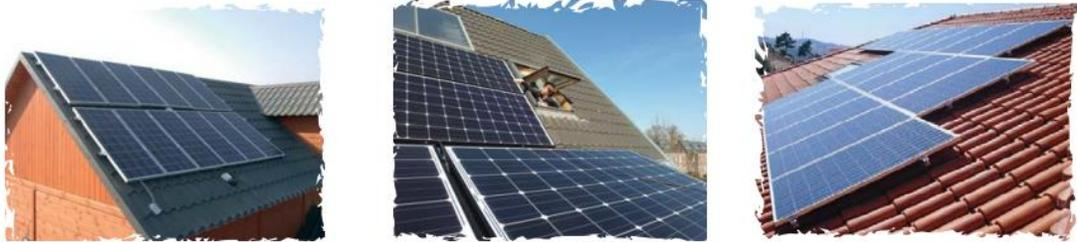
*Ilustración 57 ejemplo de estructura coplanares*
