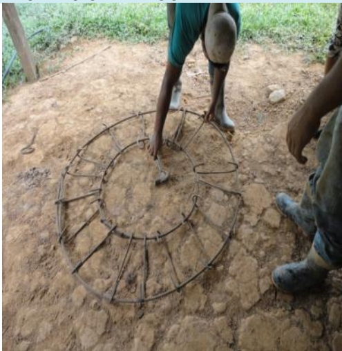
FIGURADO DE ACERO PARA POZOS
