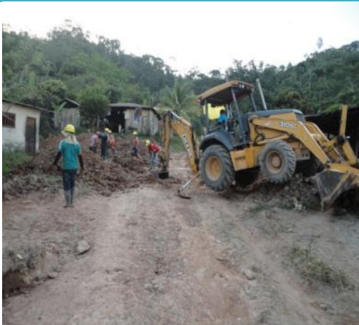
EXCAVACIONES EN MATERIAL COMUN
