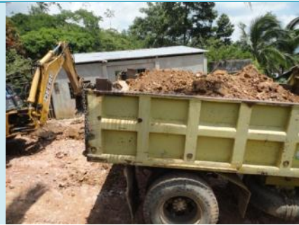
Cargue de material de excavación
