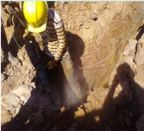
EXCAVACION EN ROCA
