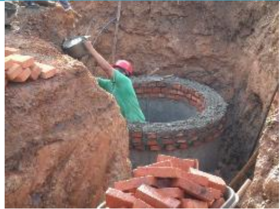
CONSTRUCCION DE POZO P11
