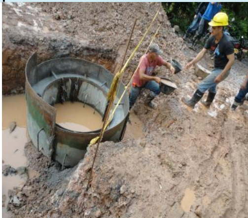
Lluvias vuelven los suelos blandos y con posibilidades de derrumbes
