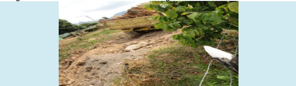
Descargue de material de excavación
