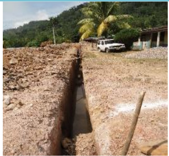
EXCAVACION EN MATERIAL COMUN
