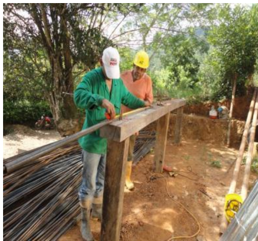
Figuración del acero para la PTAR
