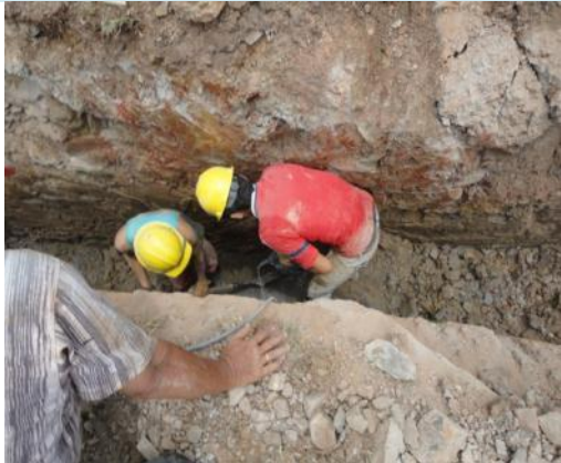
EXCAVACIONES EN ROCA
