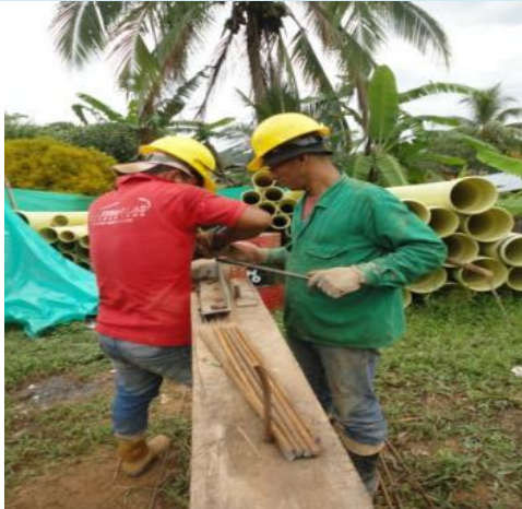
FIGURADO DE ACERO PARA POZOS
