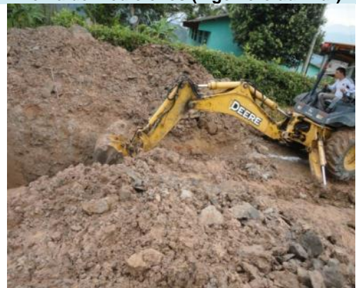
EXCAVACIONES EN MATERIAL COMUN
