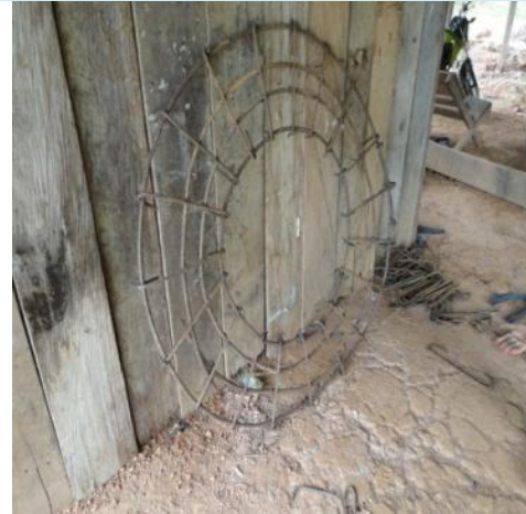
FIGURADO DE ACERO PARA POZOS
