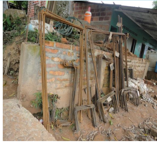
Acero figurado PTAR
