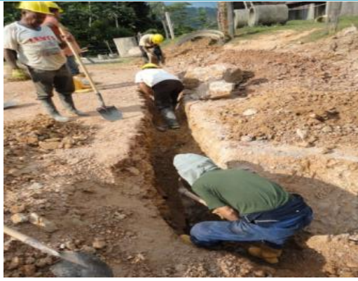
EXCAVACIONES EN MATERIAL COMUN
