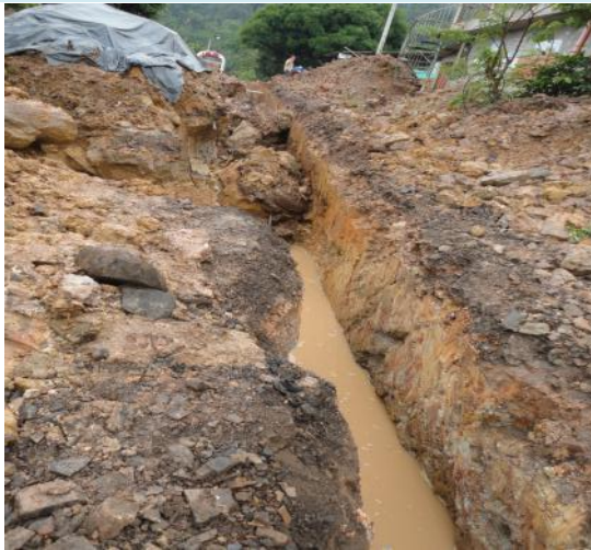
Excavación en roca
