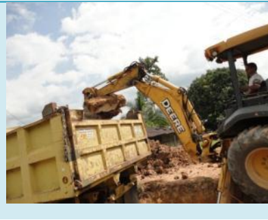
Cargue de material de excavación
