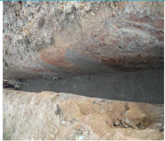
Replanteo material seleccionado (arena)
