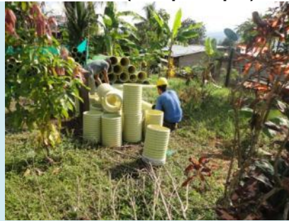
Elevadores de la caja de inspección
