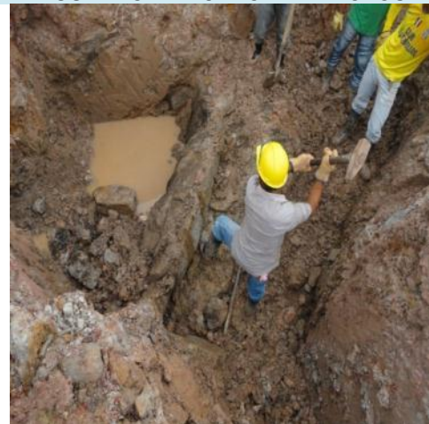
EXCAVACION EN ROCA
