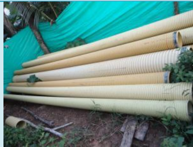
Tubería Novafort de 8" y de 6"
