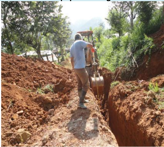
Supervisión a la excavación realizada por el retrocargador de la red principal
