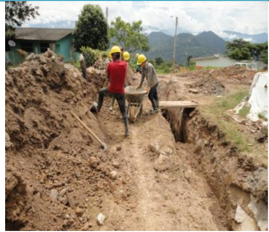
RELLENOS CON MATERIAL DE EXCAVACION
