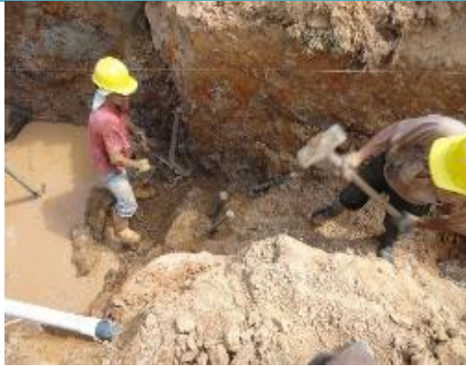
EXCAVACION EN ROCA
