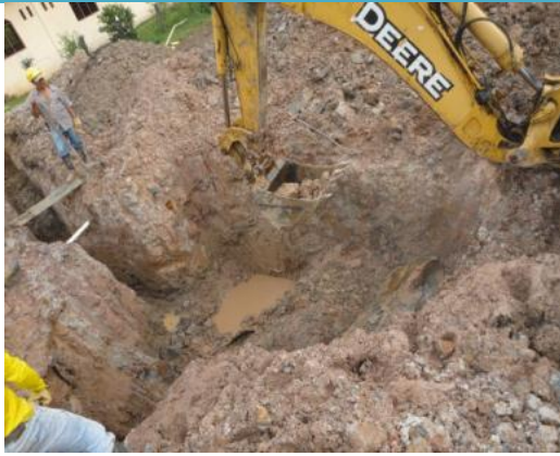
EXCAVACION PARA POZO
