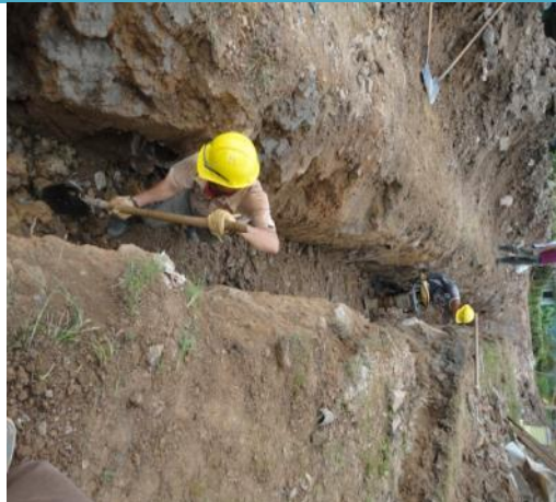
EXCAVACIONES EN MATERIAL COMUN
