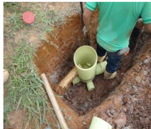
RELLENOS CON MATERIAL DE EXCAVACION
