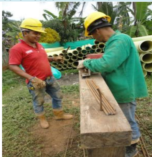
FIGURADO DE ACERO PARA POZOS
