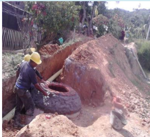
CONSTRUCCION DE POZO PL8
