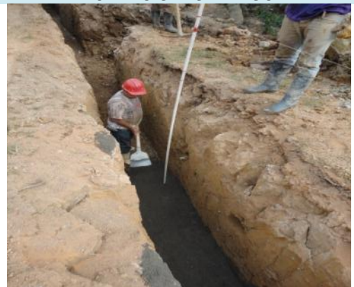
RELLENOS CON MATERIAL SELECCIONADO
