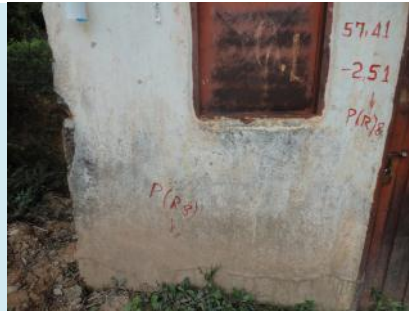
Demarcación de pozo
