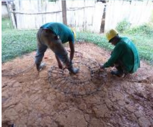
FIGURADO DE ACERO PARA POZOS
