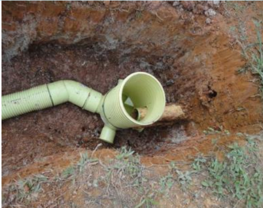
INSTALACION CAJAS DOMICILIARIAS
