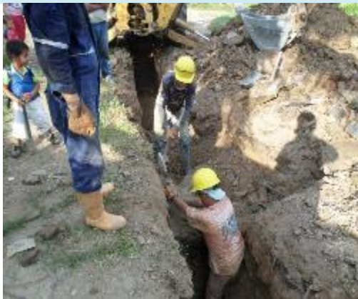
EXCAVACION EN ROCA
