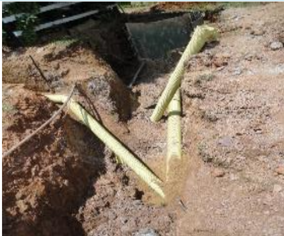
INSTALACION DE TUBERÍA DE 6" Y 8"
