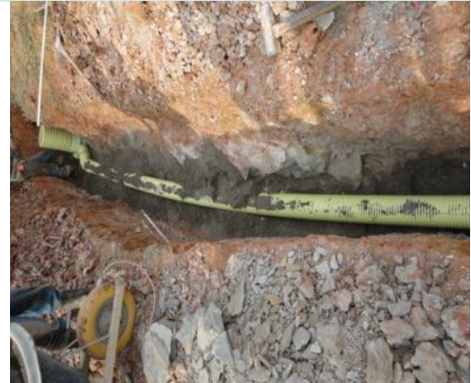
INSTALACION TUBERÍA DE 6" CON SU REPECTIVA CAPA DE ARENA
