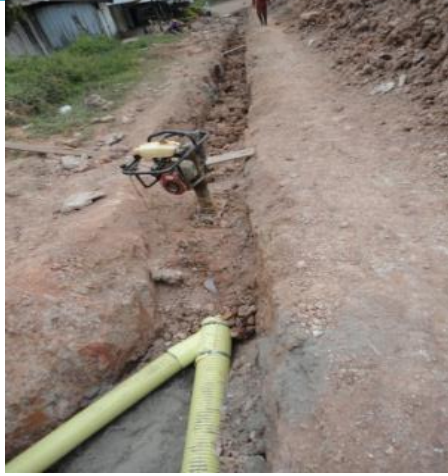
INSTALACION DE TUBERÍA DE 6" Y 8"
