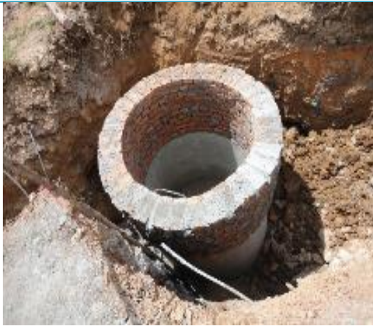
CONSTRUCCION POZO P13
