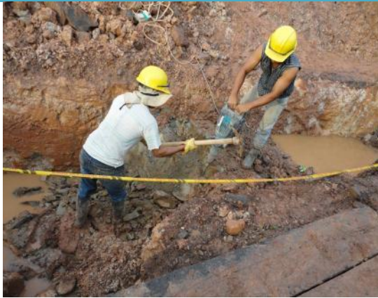
Excavación en roca
