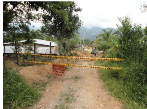
SEÑALIZACION DE OBRA
