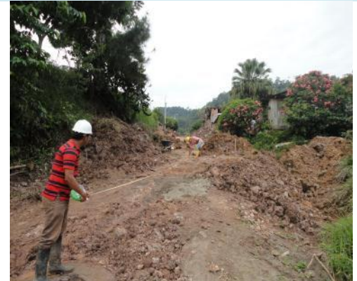
EXCAVACIONES EN MATERIAL COMUN
