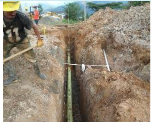
INSTALACION DE BASE PARA TUBERÍA Y TUBERÍA DE 8"
