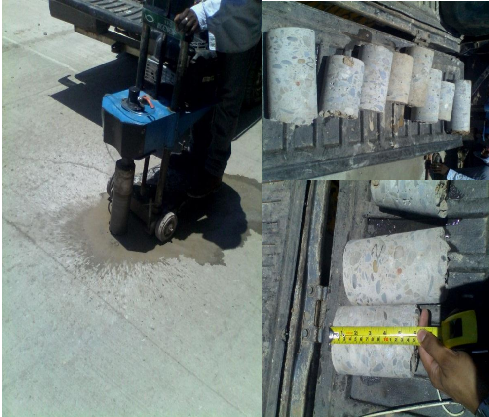
Ilustración 32 Toma de muestras para ensayos de concreto y espesores. Fuente: Autor
