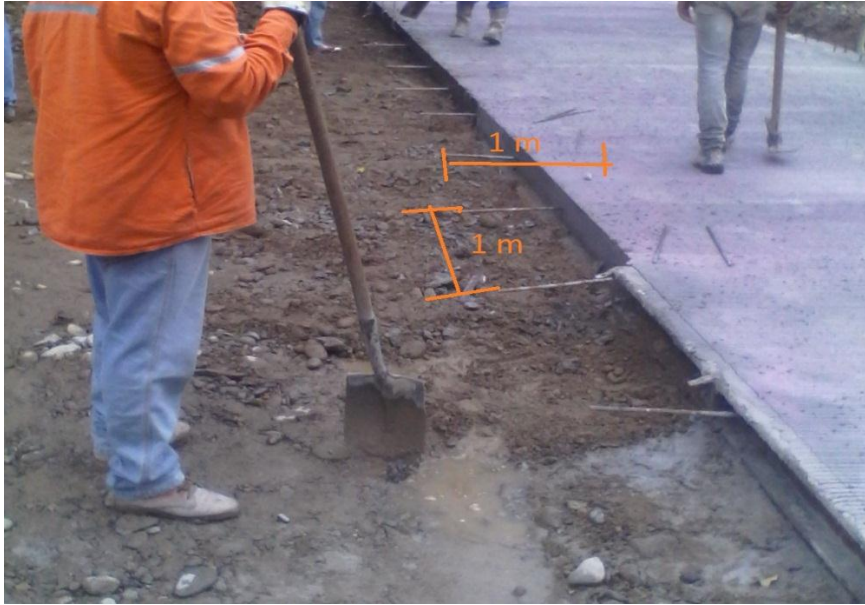
Ilustración 5 Aceros de anclajes Fuente: Autor.
