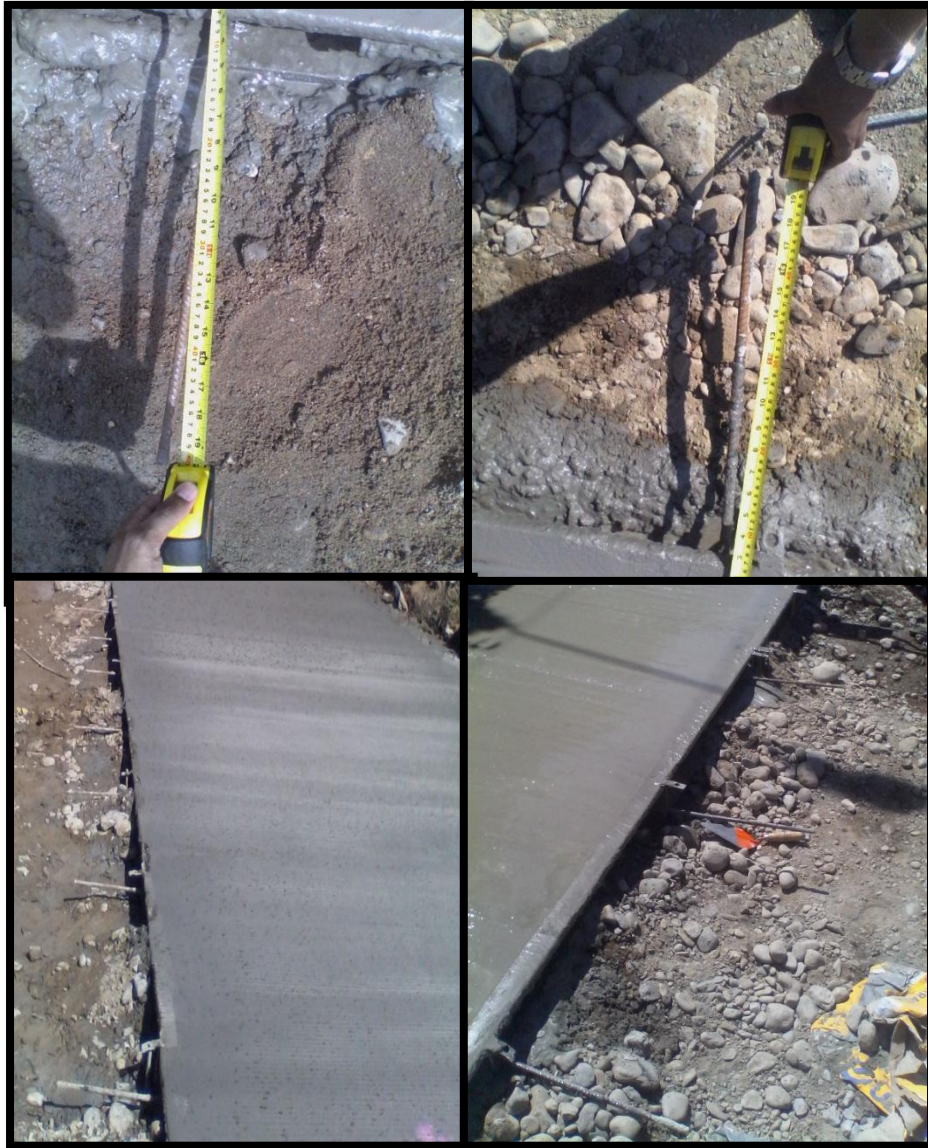
Ilustración 22 Ubicación y Control a Barras de Anclajes
