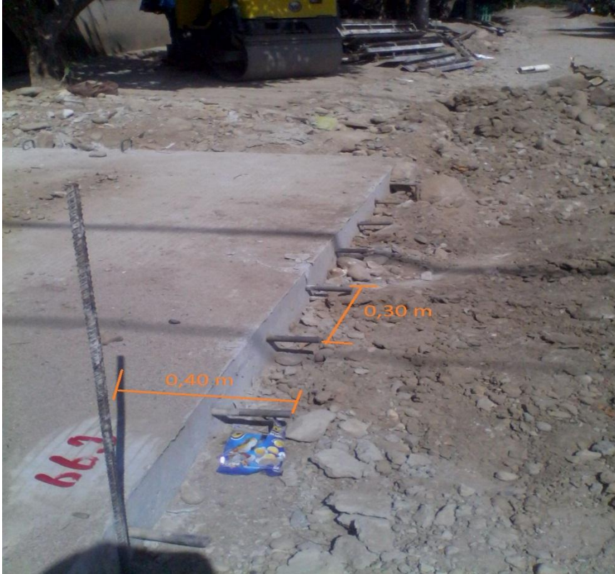
Ilustración 4 Aceros de transferencias de cargas Fuente: Autor.
