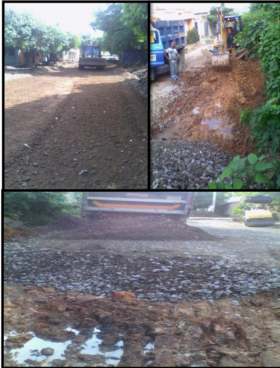
Ilustración 13 Suministro y extendido de material para subbase
