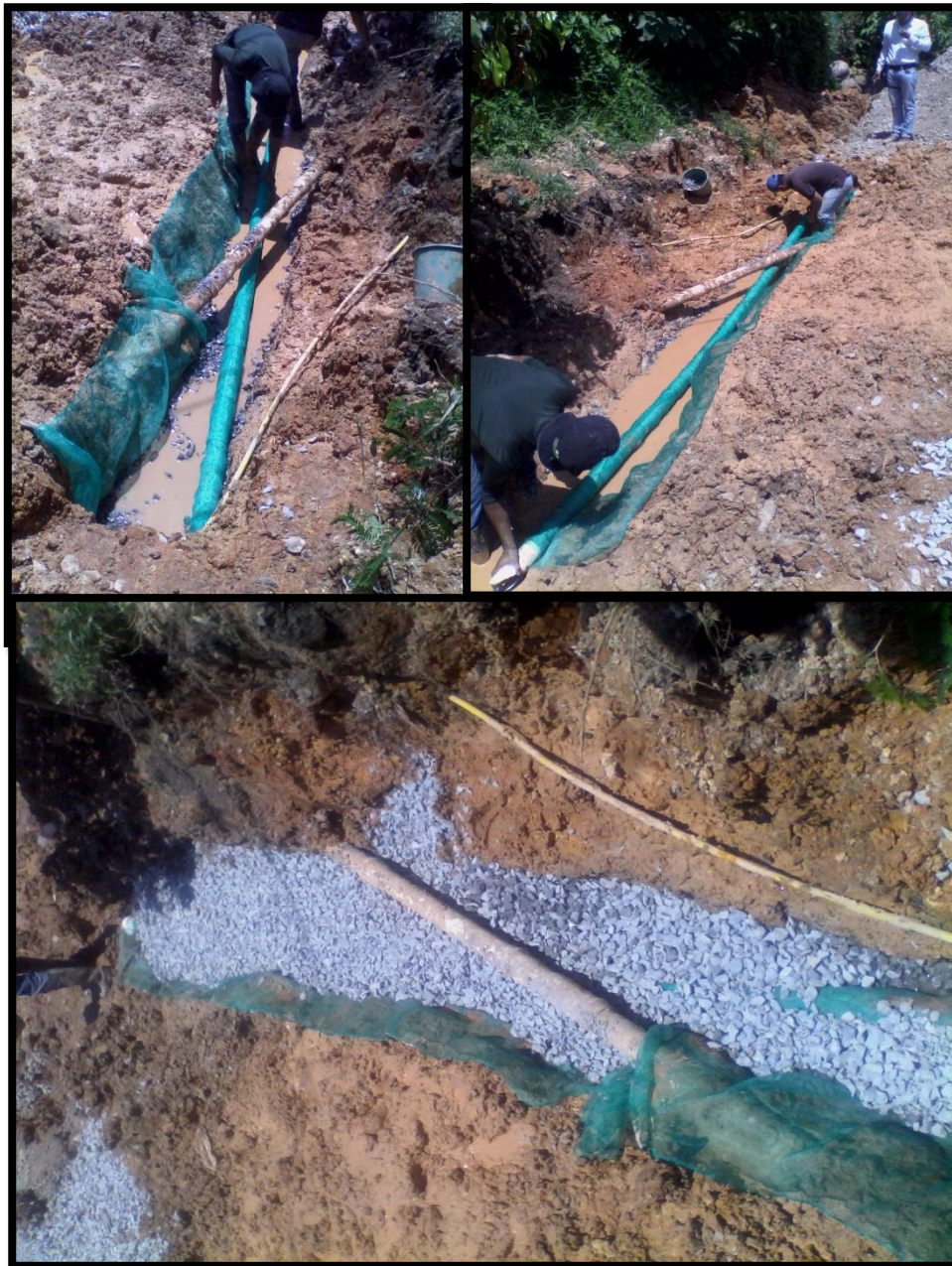
Ilustración 31 Construcción de Filtro
