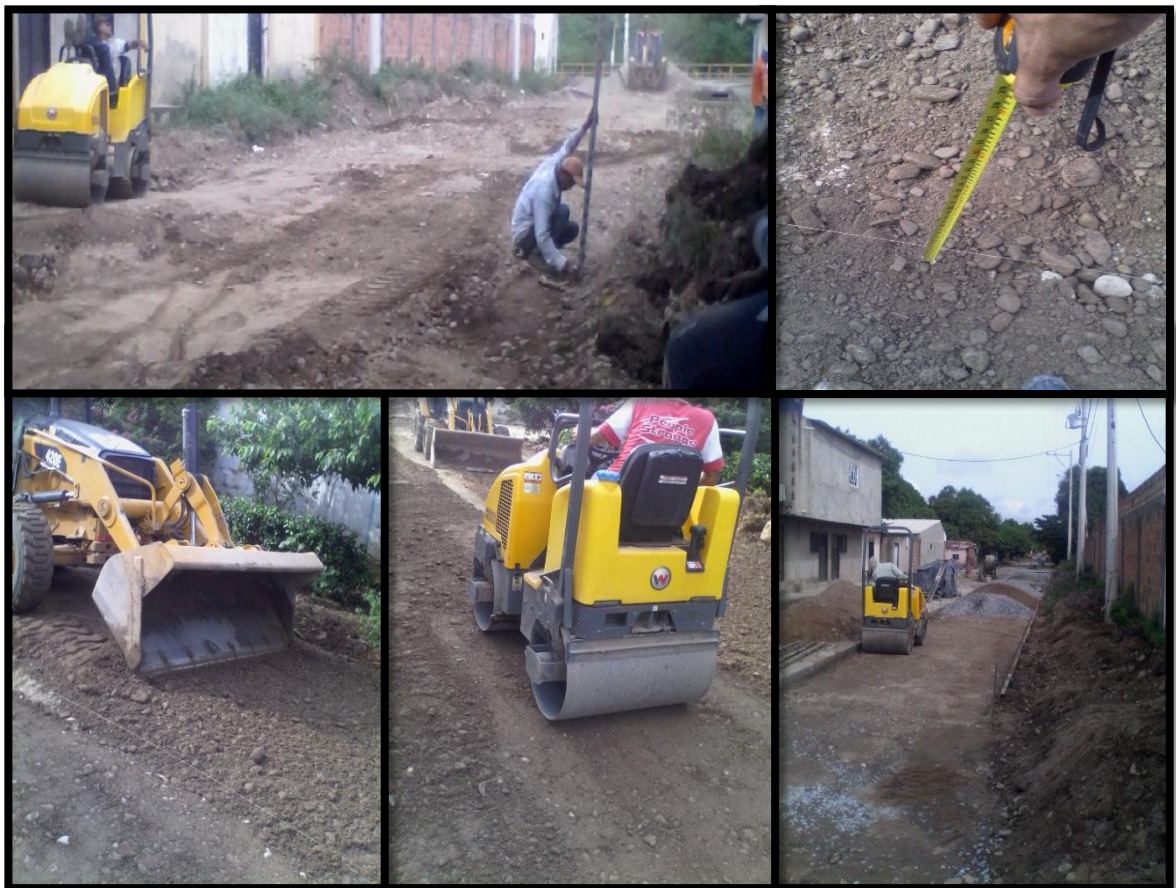
Ilustración 17 Nivelación, compactación y recompactación de la subbase
