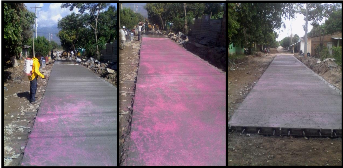
Ilustración 24 Aplicación de curado con Antisol. Fuente: Autor
