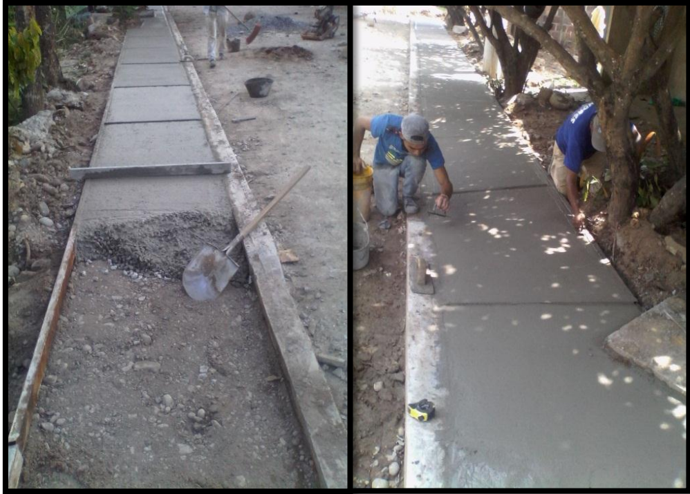
Ilustración 30 Colocación del concreto y acabado de andenes. Fuente: Autor
