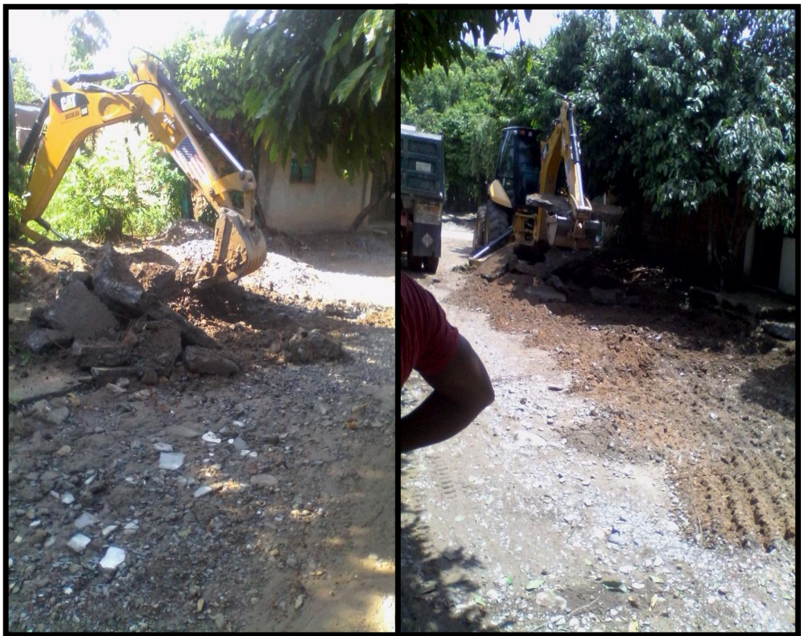
Ilustración 14 Demolición de la estructura del pavimento existente
