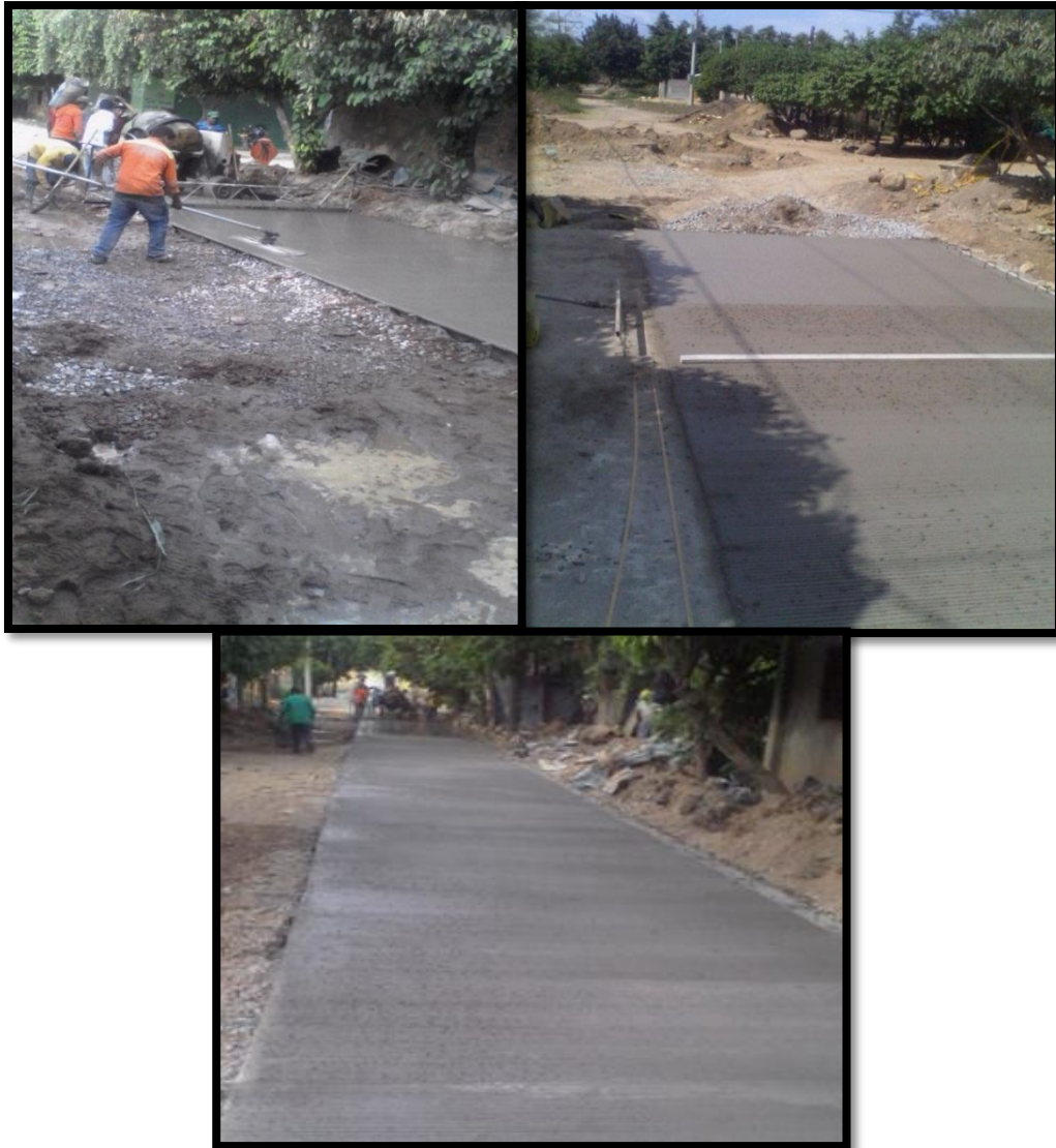
Ilustración 23 Alisado y acabado del pavimento Fuente: Autor
