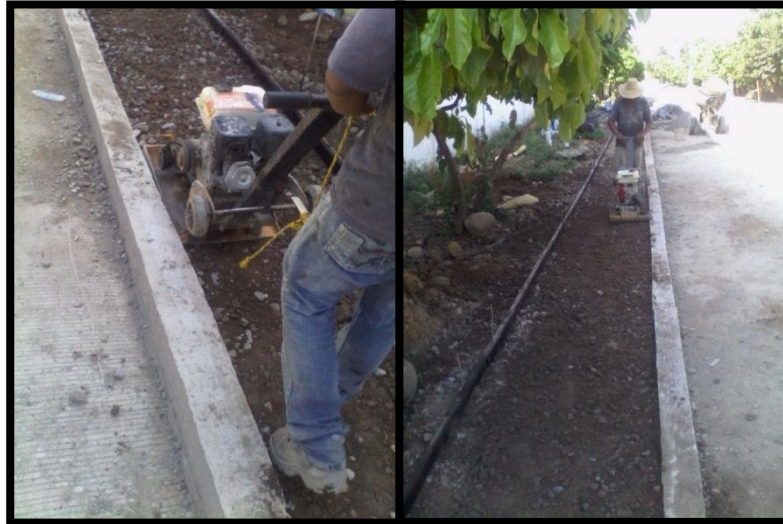
Ilustración 28 Proceso de compactación. Fuente: Autor
