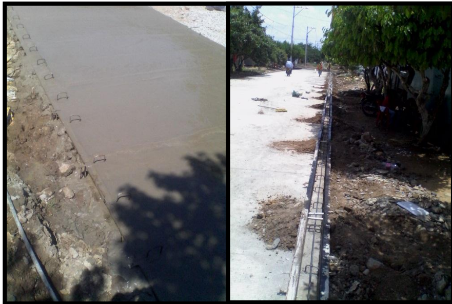
Ilustración 26 Refuerzos y encofrado del bordillo.
