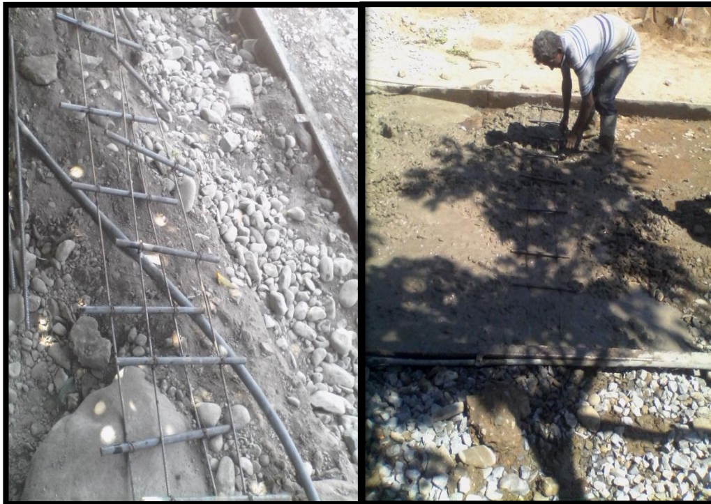
Ilustración 20 Colocación de pasadores por parrillas Fuente: Autor
