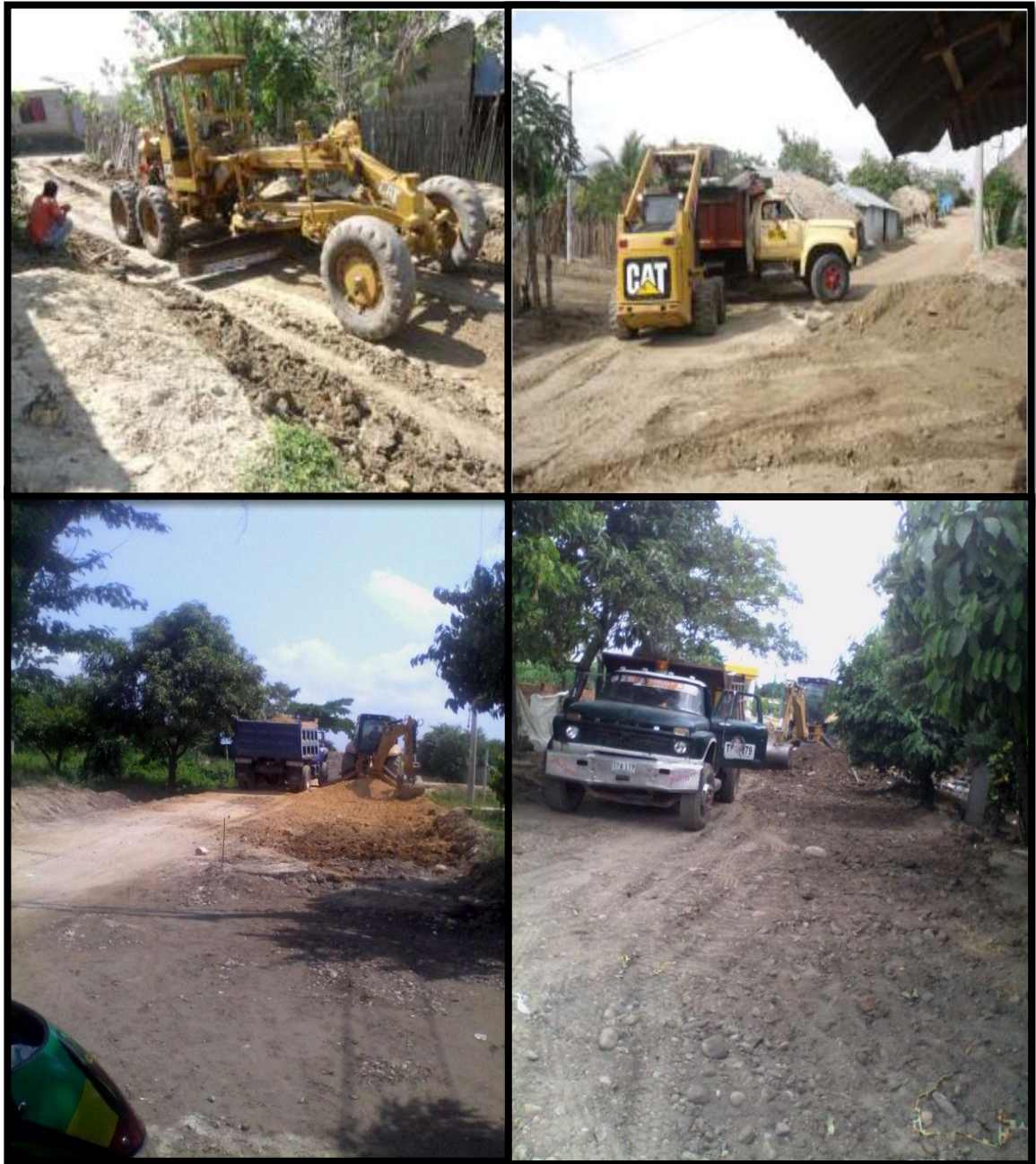
Ilustración 12. Excavaciones y cargue de material.
