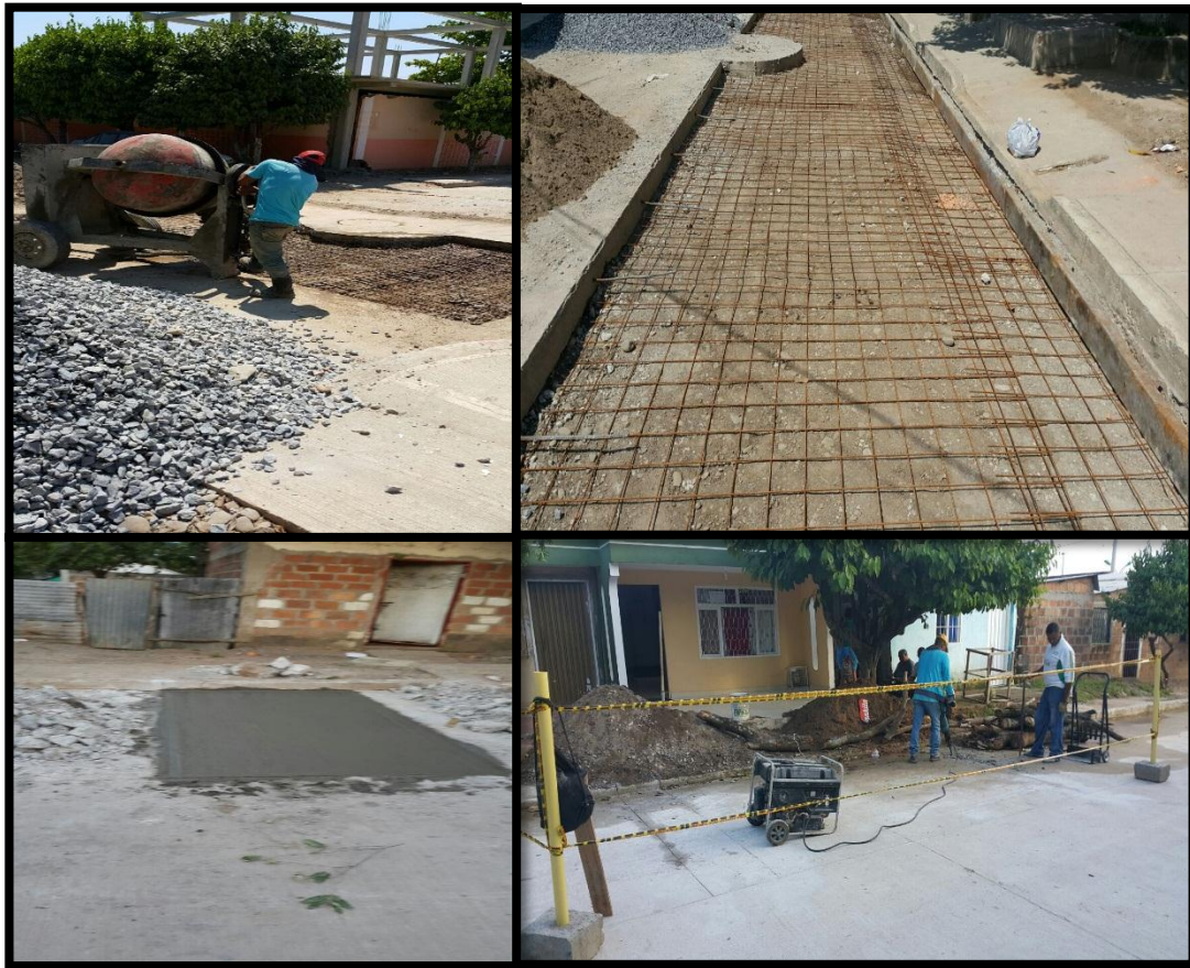
Ilustración 11 Reparaciones de losas fracturadas
