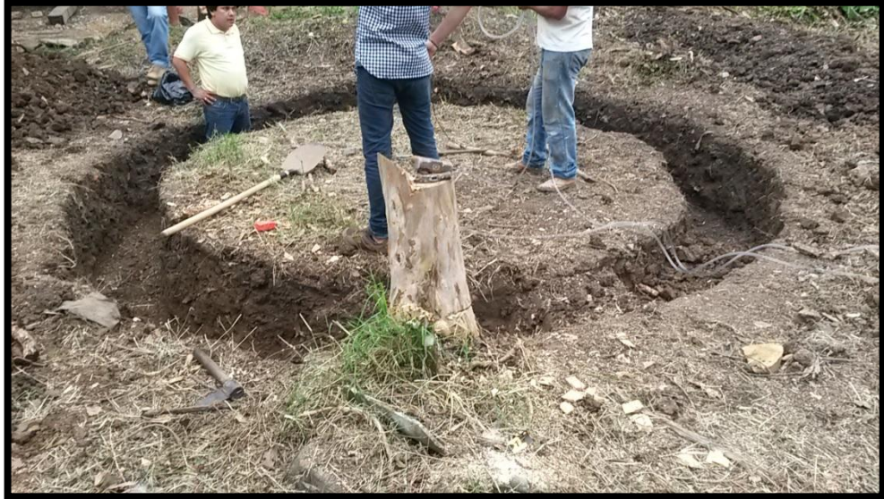
Ilustración 45. : Excavaciones PTAR Centro Poblado de Portugal
