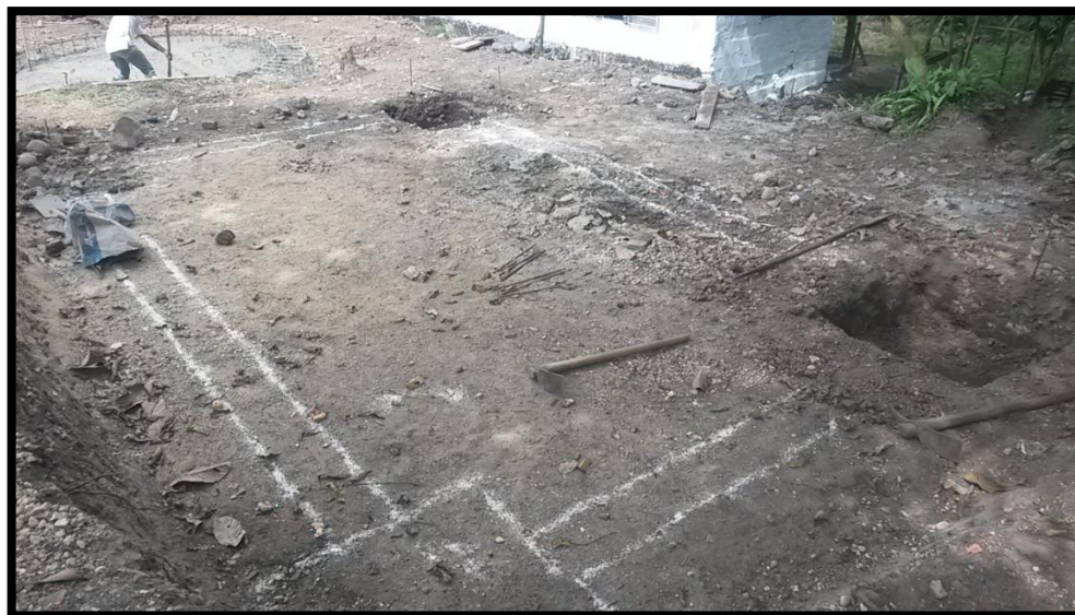
Ilustración 43: Replanteo PTAR centro poblado de Portugal
