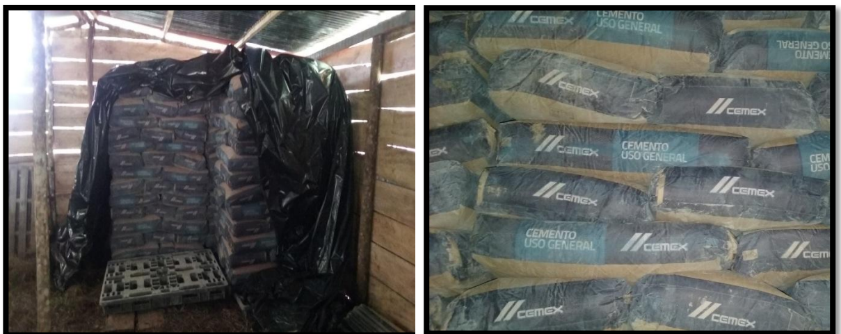
Ilustración 29: Almacenamiento del Cemento
