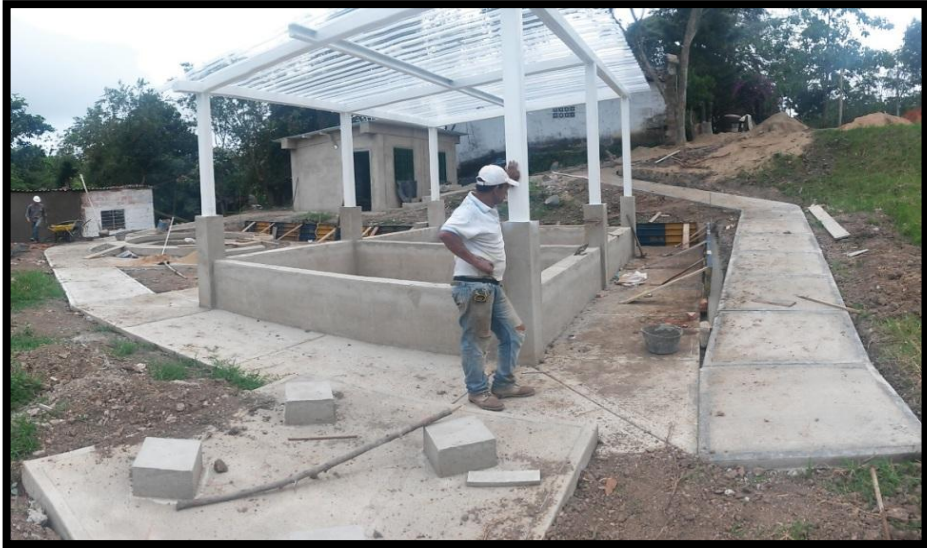
Ilustración 51: Cubierta en Teja Ajover
