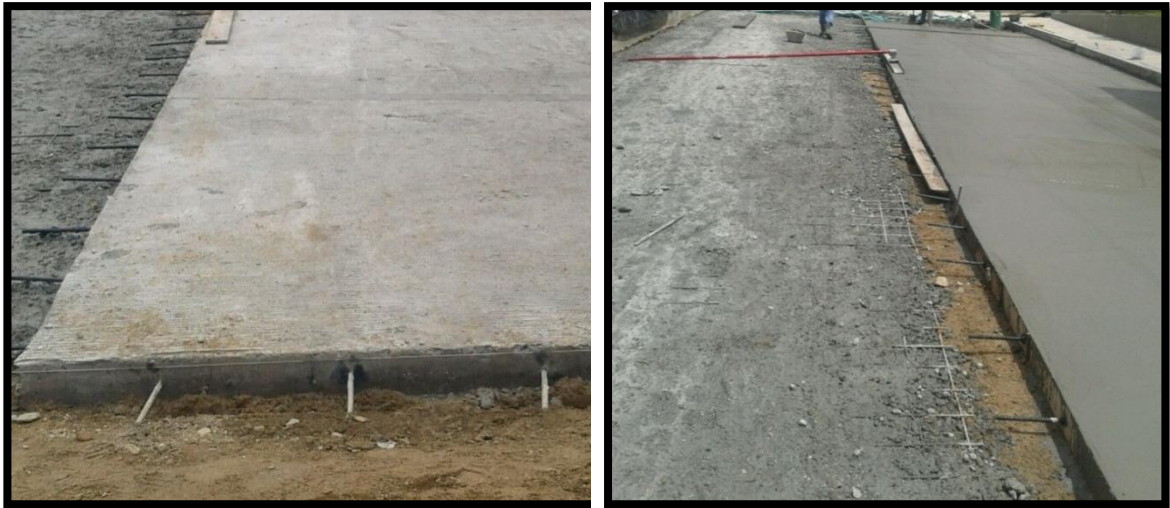
Ilustración 26: Acero de Refuerzo para vía
