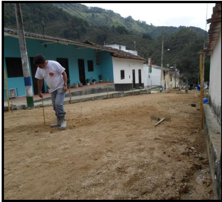
Ilustración 24: Localización y Replanteo para vía
