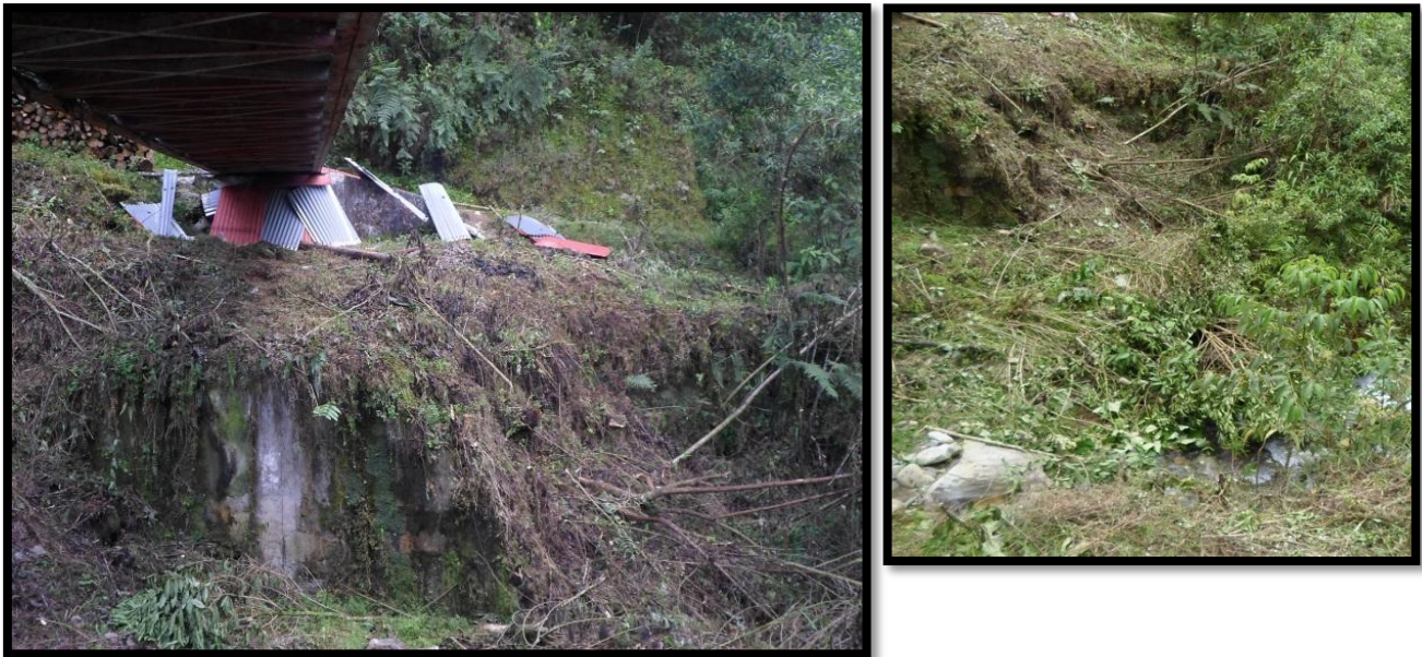
Ilustración 12: Descapote y Limpieza en Zonas no Boscosas
