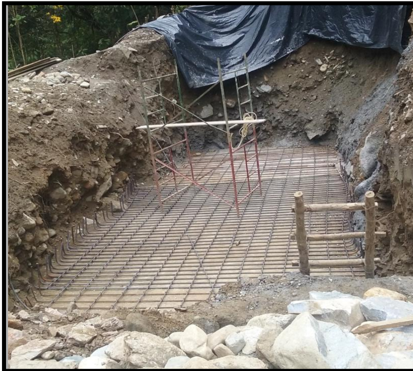
Ilustración 22: Amarre de Hierro para Refuerzo
