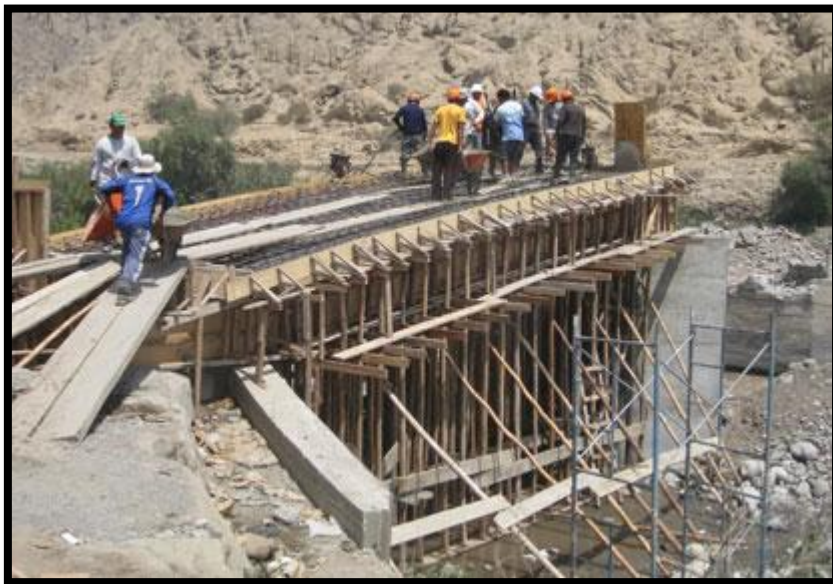
Ilustración 2: Construcción de Punto
