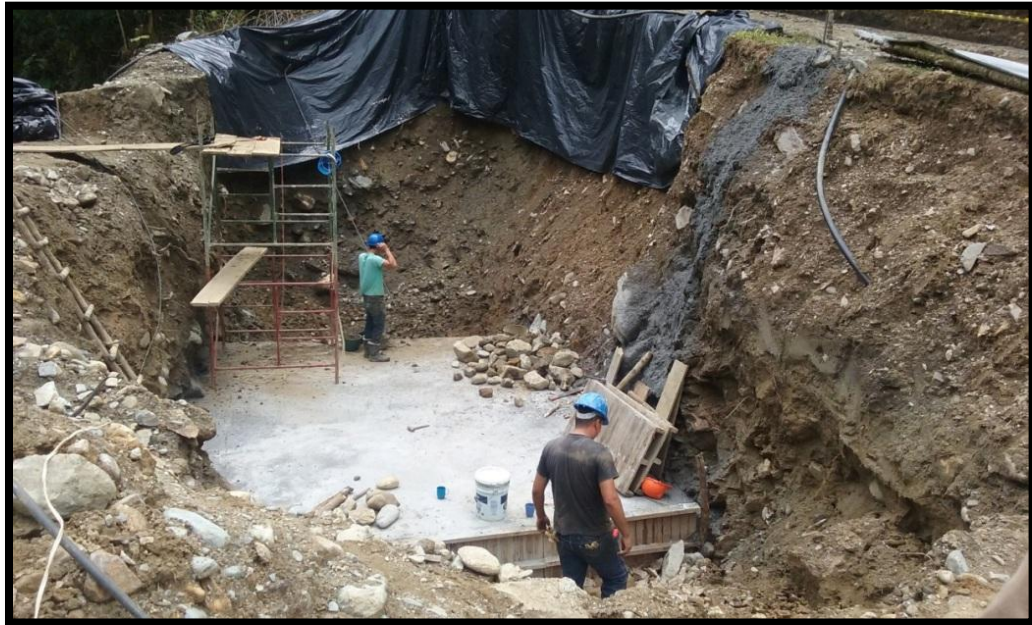
Ilustración 18: Concreto Ciclópeo
