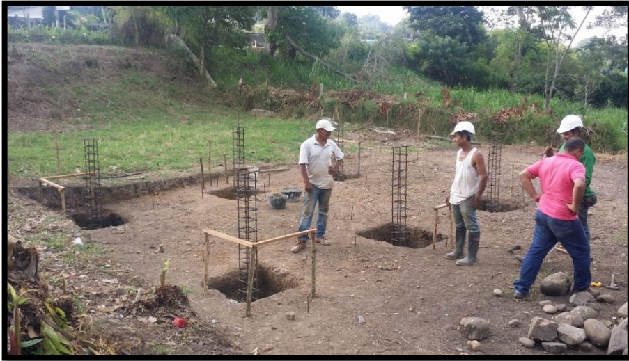
Ilustración 50: Acero de Refuerzo PTAR Centro Poblado de Portugal
