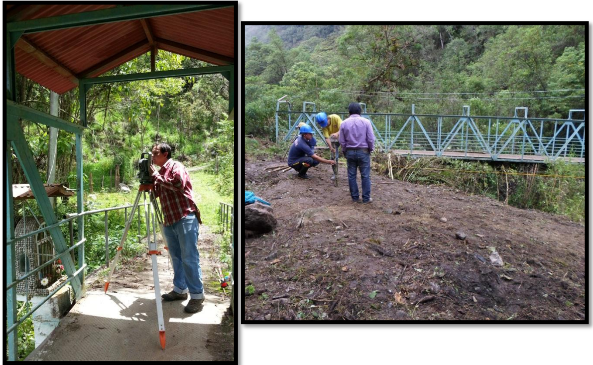
Ilustración 14: Localización y Replanteo para puente
