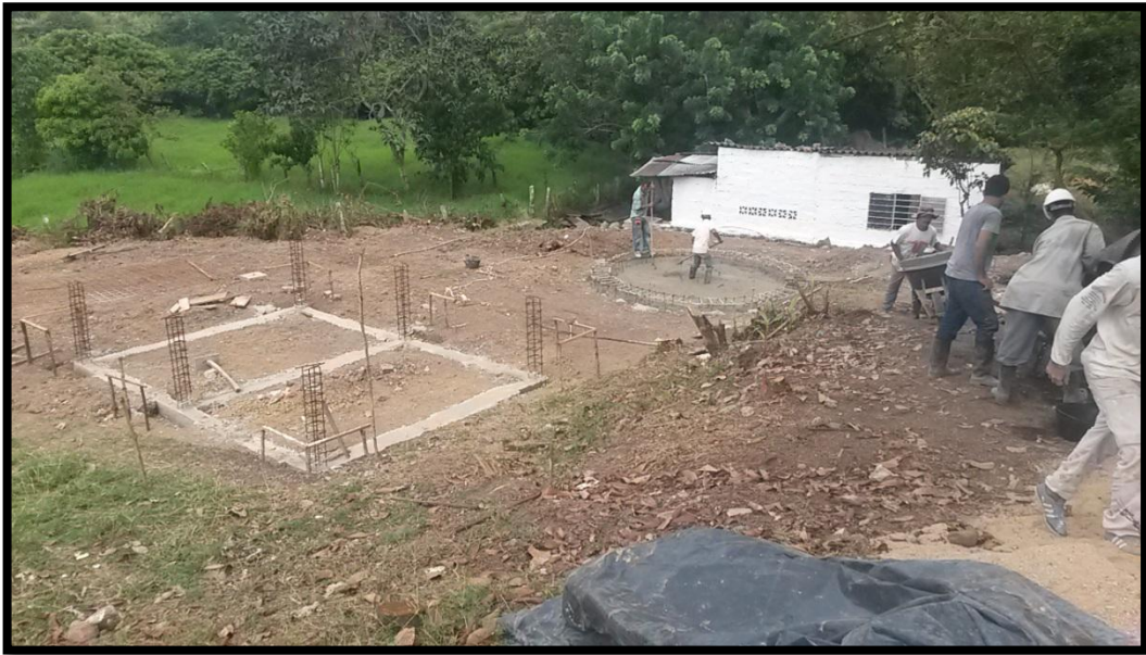
Ilustración 47: Vigas de Amarre y corona
