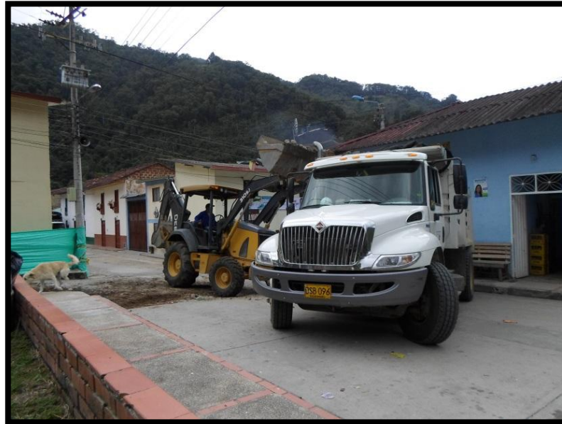
Ilustración 32: Recolección de escombros
