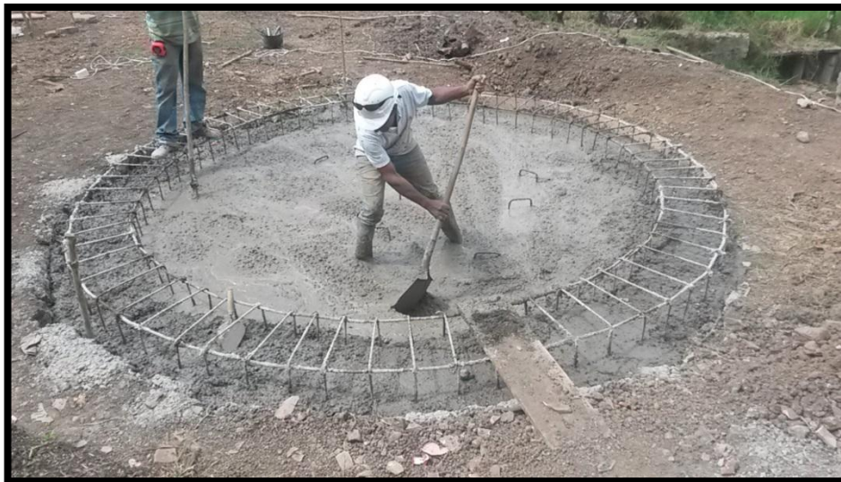
Ilustración 46: Concreto de placa PTAR Centro poblado de Portugal
