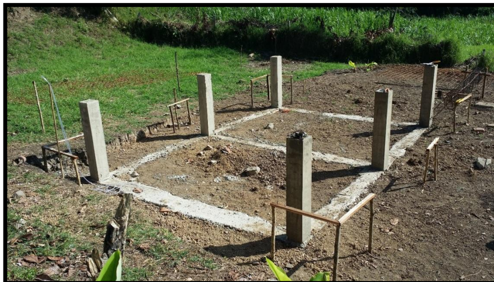
Ilustración 48: Concreto para columnas
