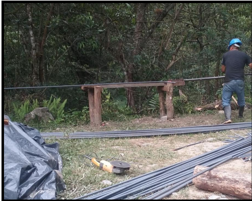
Ilustración 21: Doblamiento de Varillas
