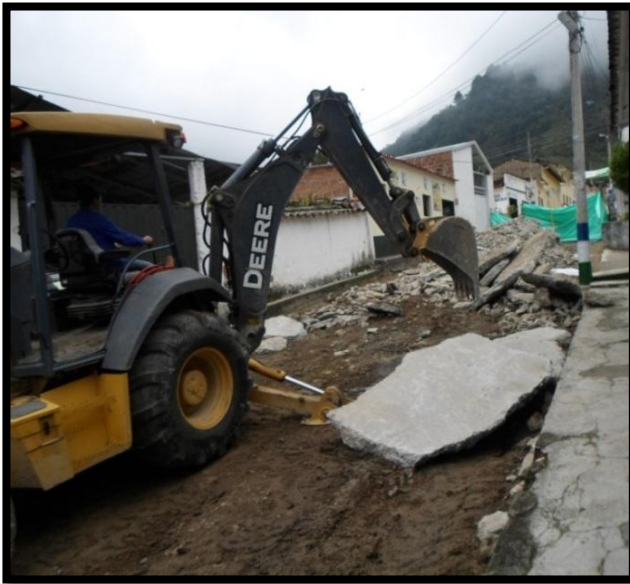
Ilustración 23: Demolición de Pavimento
