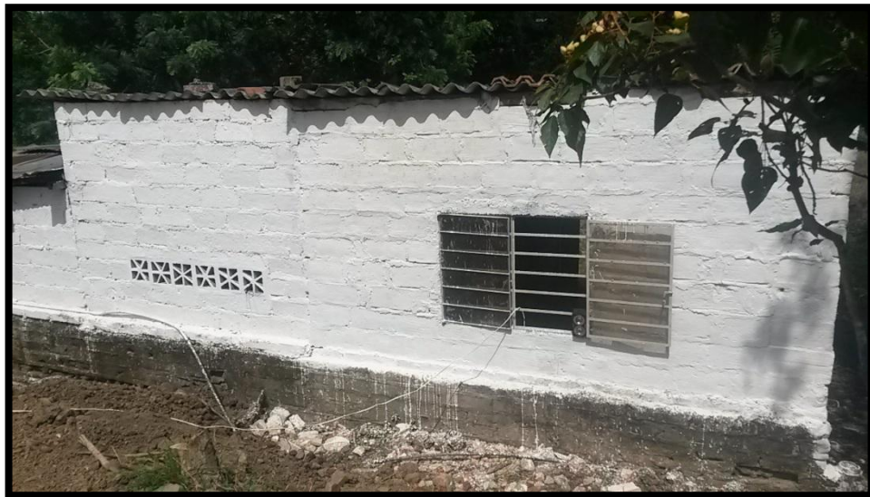
Ilustración 42: Campamento de obra Centro Poblado de Portugal
