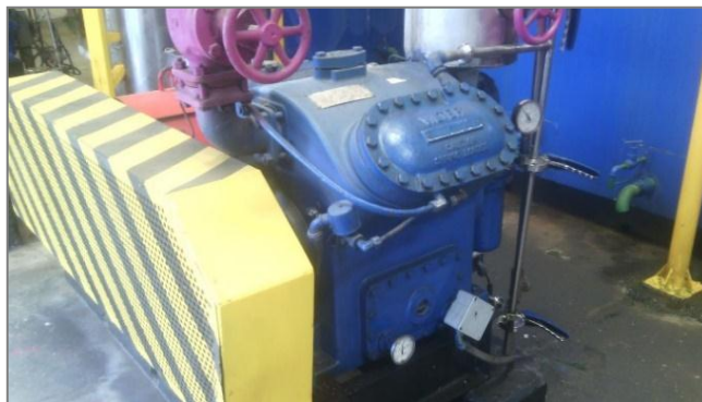
Figura 4.26 Compresor de pistón Vilter A 12K 454 XLF
