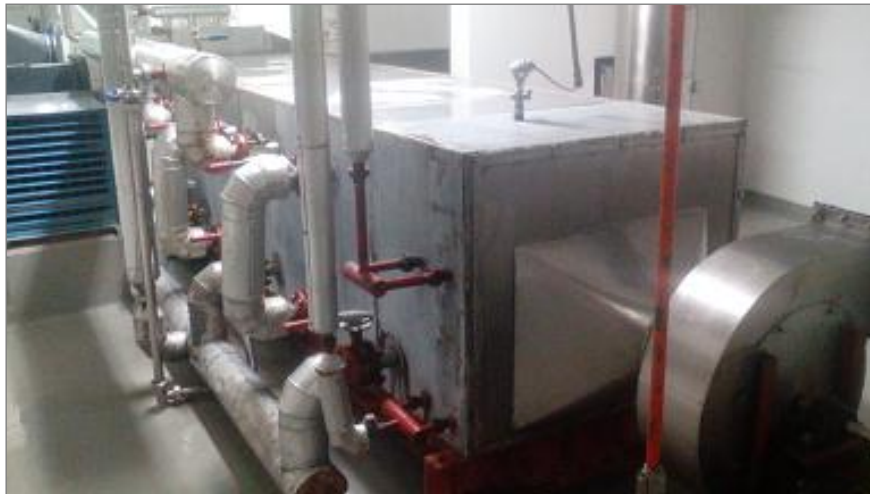
Figura 4.68 Deshumidificador de aire A. FACCINI & CIA AH 2011
