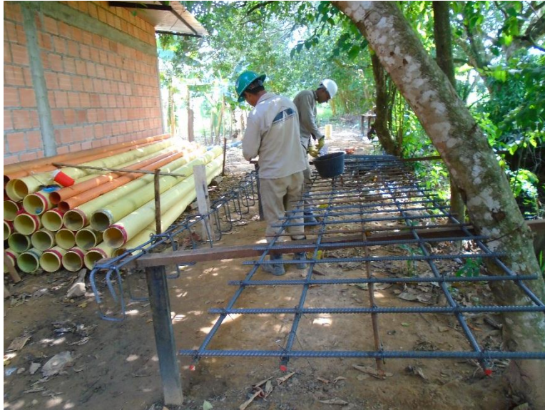
Fotografía 14: Figurado De Acero
