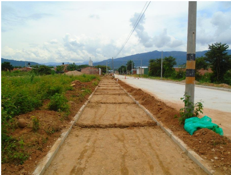
Fotografía 16: Instalación De Base Y Modulación Para Instalación De Loseta
