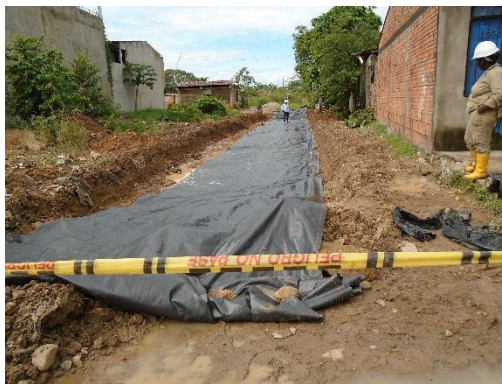
Fotografía 5: Instalación De Geo-textil
