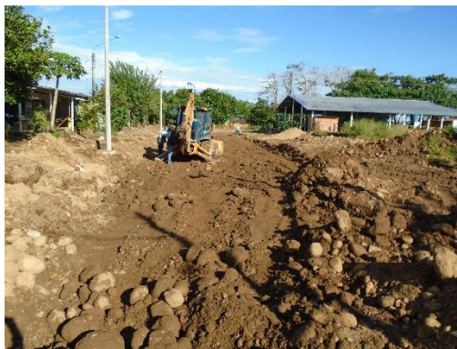
Fotografía 6: Instalación De Sub-base
