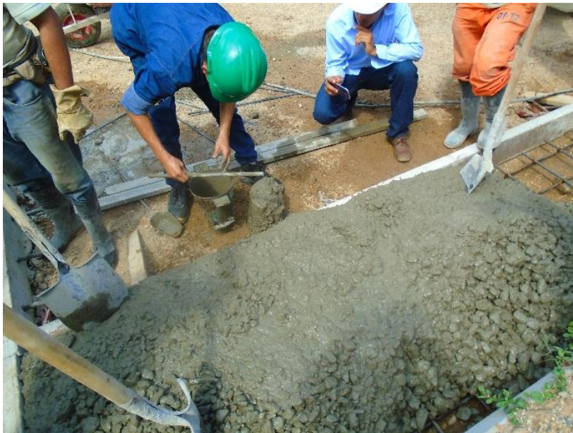
Fotografía 12: Laboratorio Del Slump
