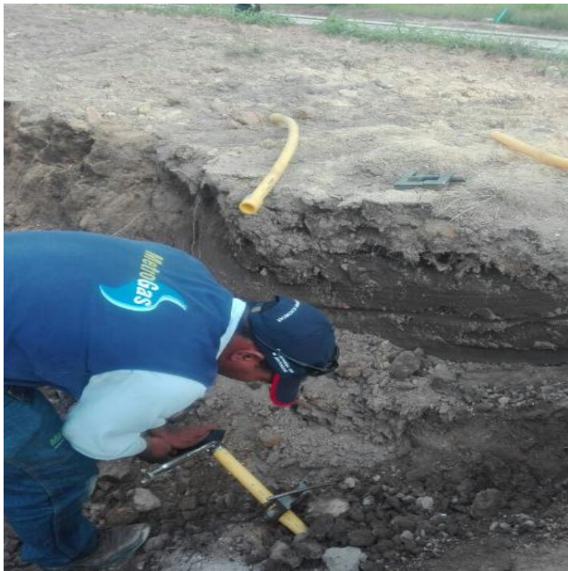
Imagen 15. Reparación de tubería de gas
