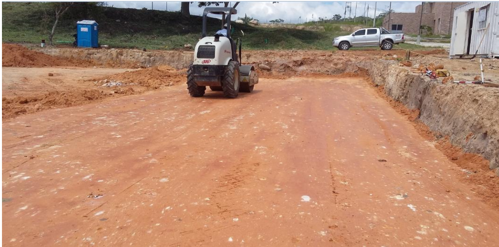
Imagen 17. Compactación de material
