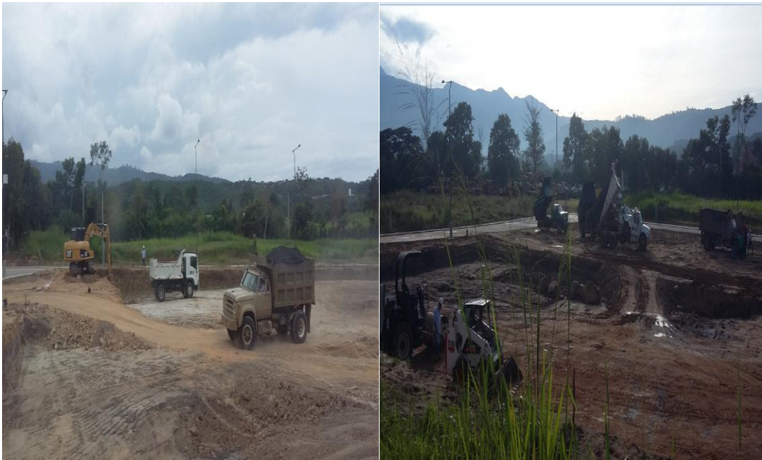
Imagen 20. Retiro de escombros con destino al botadero
