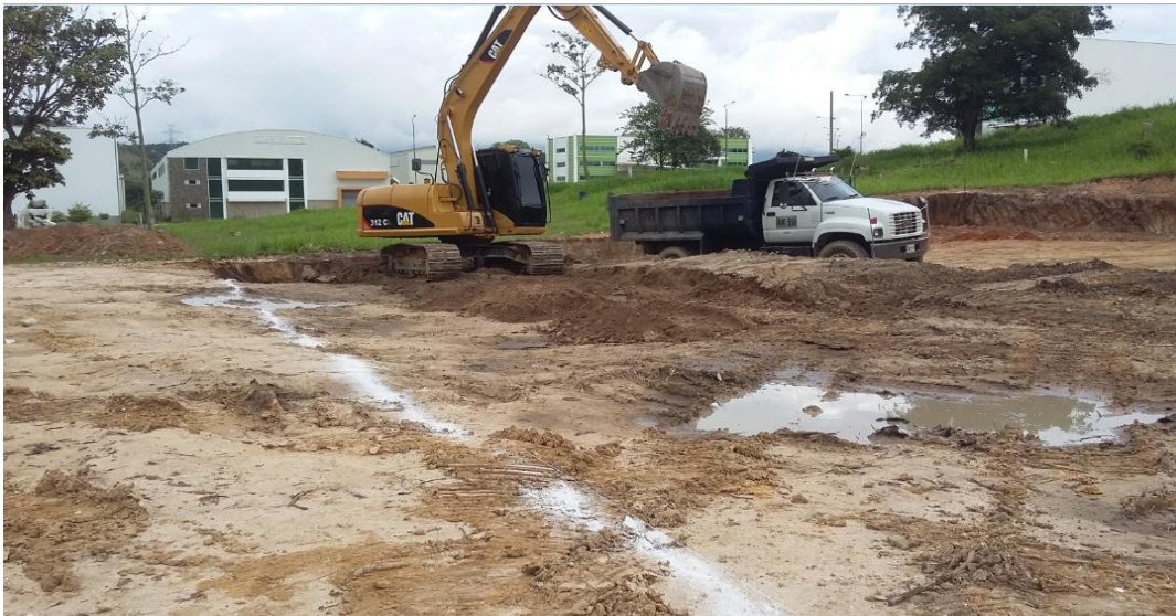
Imagen 21. Cargue de material mecánico
