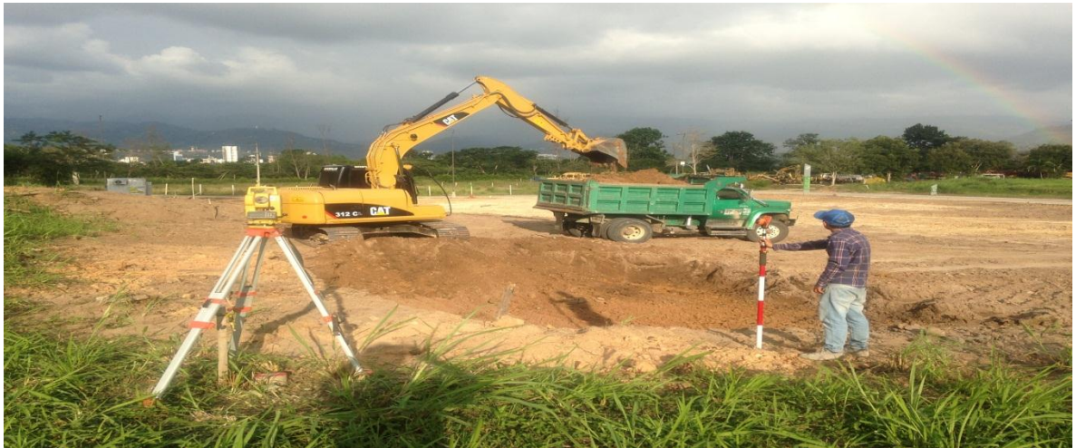
Figura 5. Control con estación avance corte Fuente: Autor
