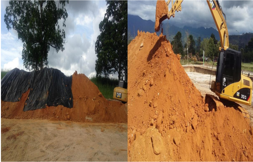
Imagen 16. Acopio, Apilamiento y protección de material de relleno
