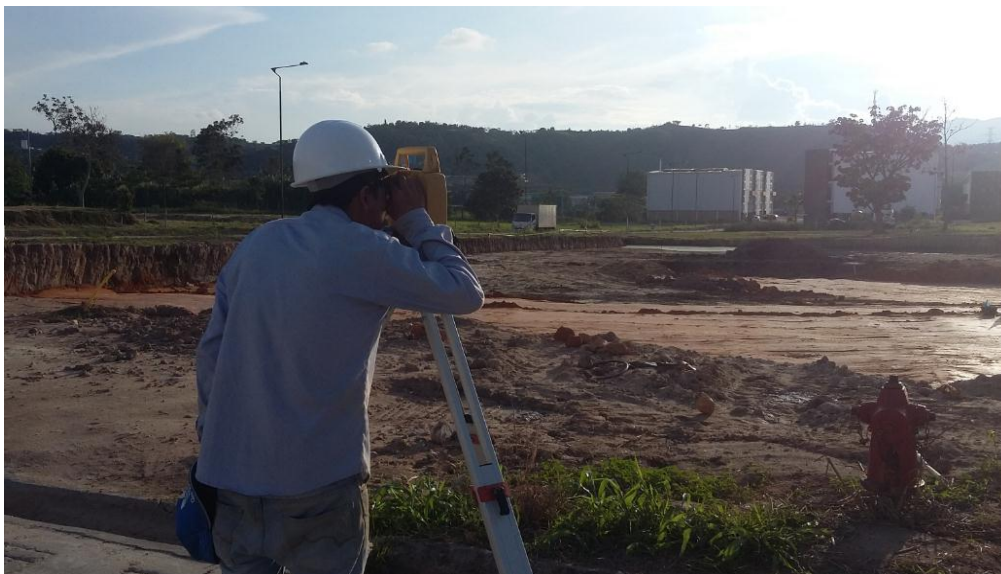
Imagen 30. Topografía para avance de obra
