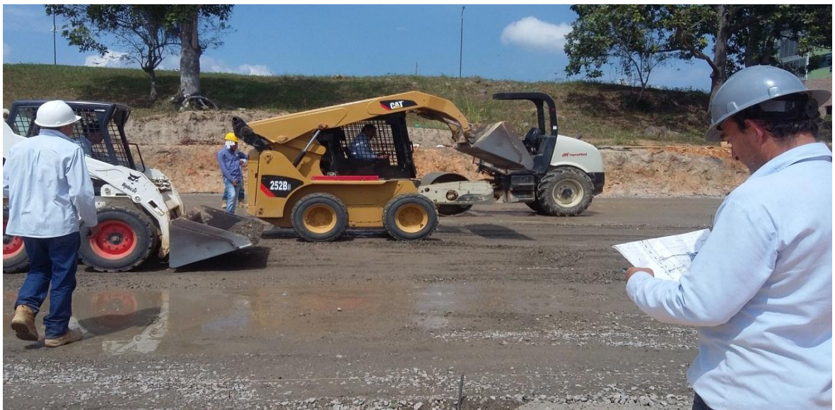
Imagen 18. Relleno Base Granular
