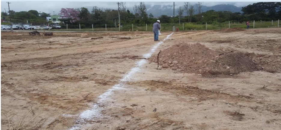
Imagen 9. Replanteo. Fuente: Autor
