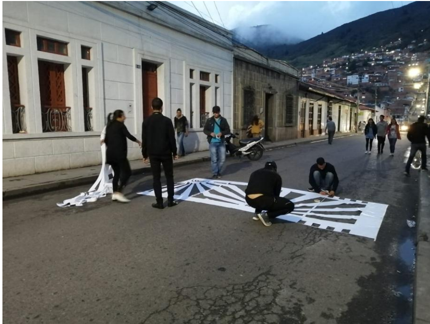
FIGURA 67 / PEGUE DE PLATILLAS AL PAVIMENTO
