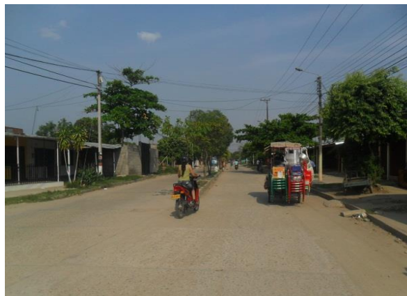
Foto 14. Vía Pedro Nel Jimenez- dique perimetral hacia la vereda Barrancones, via pavimentada en buenas condiciones
