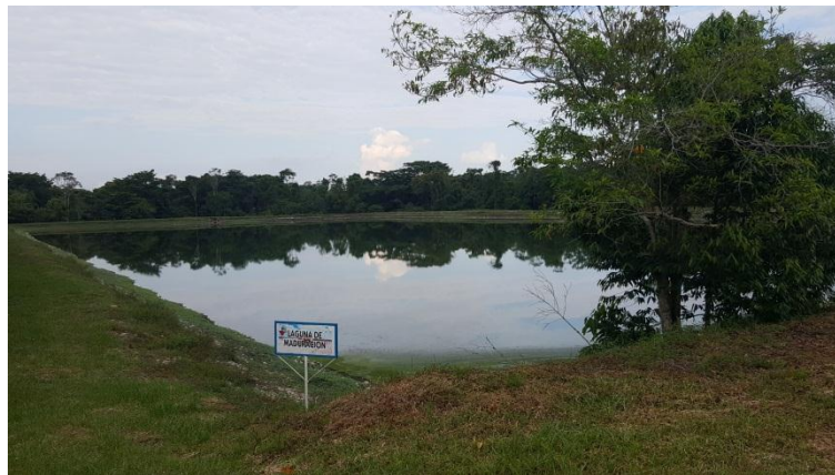
Fotografía 11. Laguna de Maduración tren antiguo.
