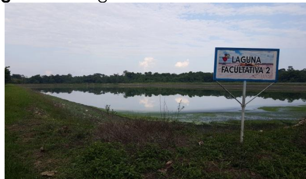
Fotografía 10. Laguna facultativa 2 tren antiguo.
