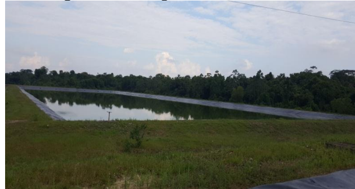
Fotografía 13. Laguna facultativa No 1.
