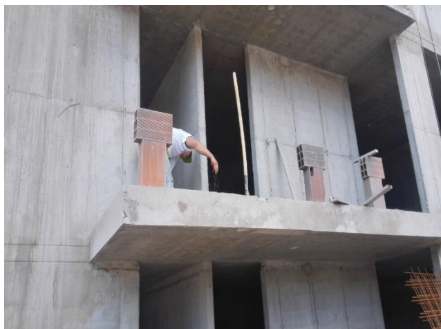
Foto 1 Obra en construcción de la Constructora Grupo Hogar
