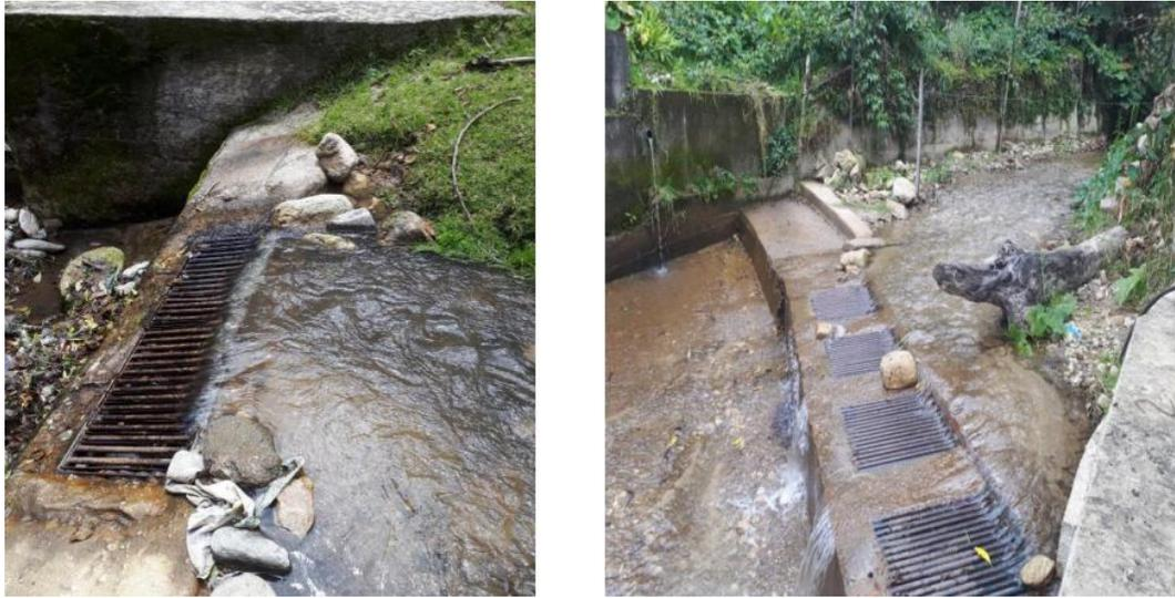
**Imagen 5.** Estructura de captación Quebrada El Rosal y Cariongo
