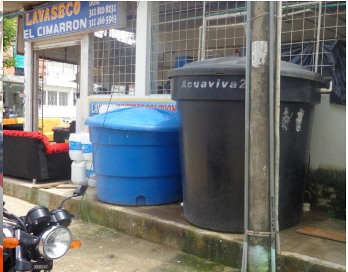
Imagen 110: Tanques de almacenamiento de agua
