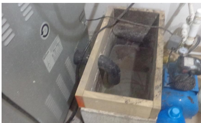
Imagen 132. Recirculación del vapor de agua, Lavaseco Lavamatic. Fuente Vargas, A.
