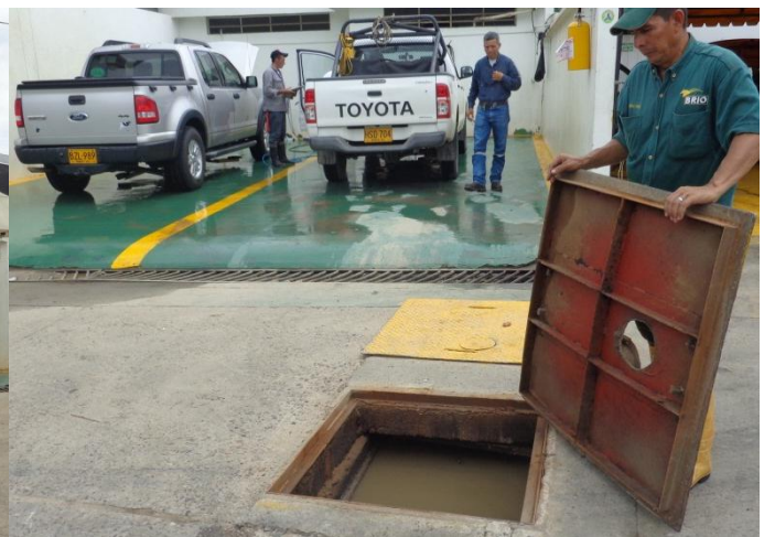
Imagen 74. Inspección trampa de sedimentos
