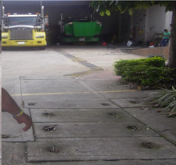
Imagen 22. Estructura trampa grasa
