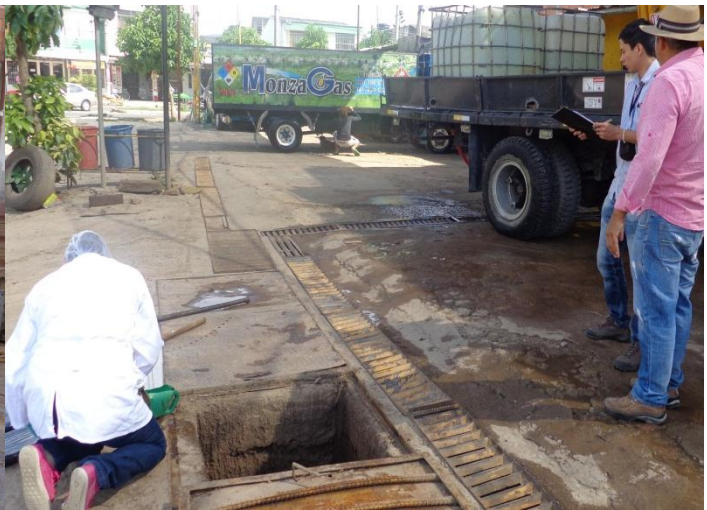
Imagen12. Revisión de trampa de grasas
