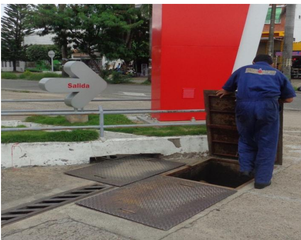
Imagen 78. Inspección trampas de grasa
