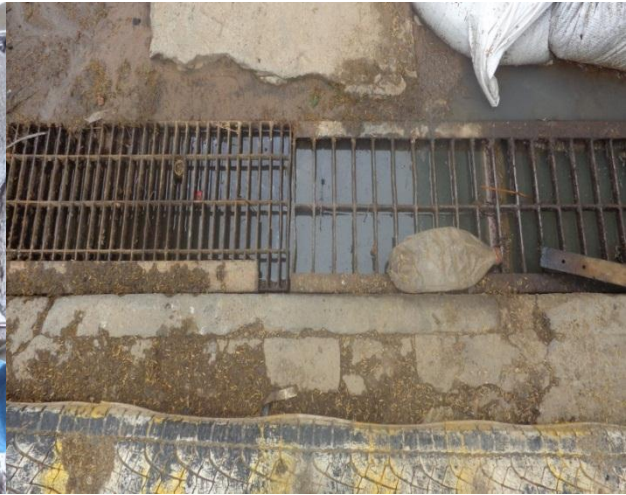
Imagen 34: Rejilla al final de rampa de lavado
