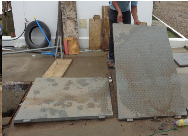
Imagen 48. Inspección Trampa grasas
