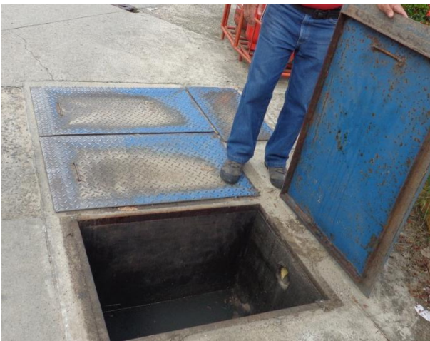
Imagen 83. Inspección trampas de grasa
