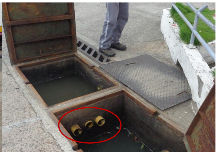
Imagen 79. Conexión trampas de grasa
