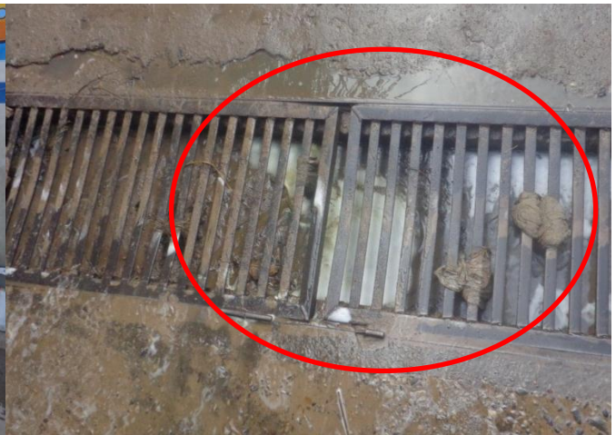
Imagen 69: Rejilla colmatada, por falta de
