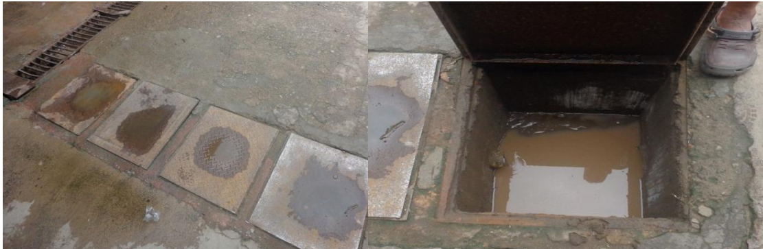
Imagen 24: Estructura de trampa grasas
