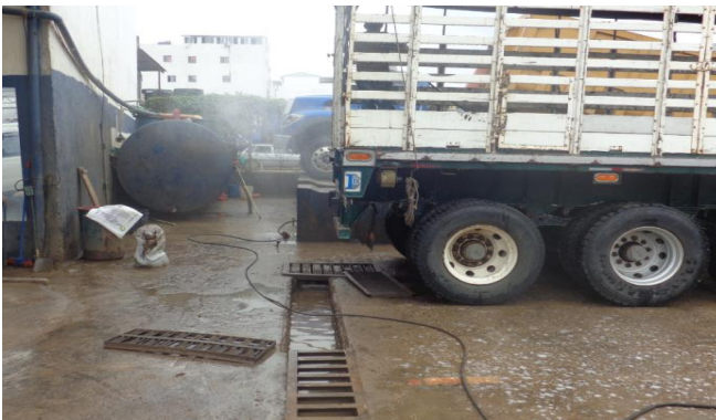
Imagen 52. Rejilla frontal y sedimentador
