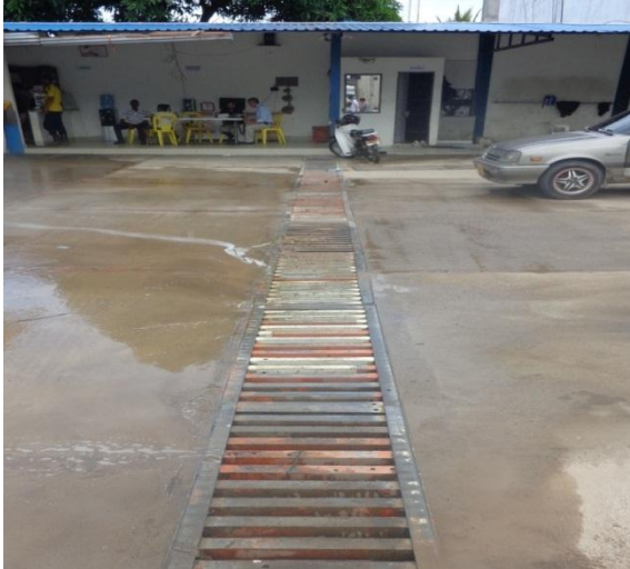
Imagen 6: Rejilla para retención de sólidos
