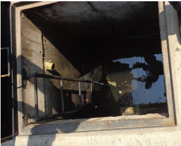
Imagen 90: Inspección trampa de sedimentos
