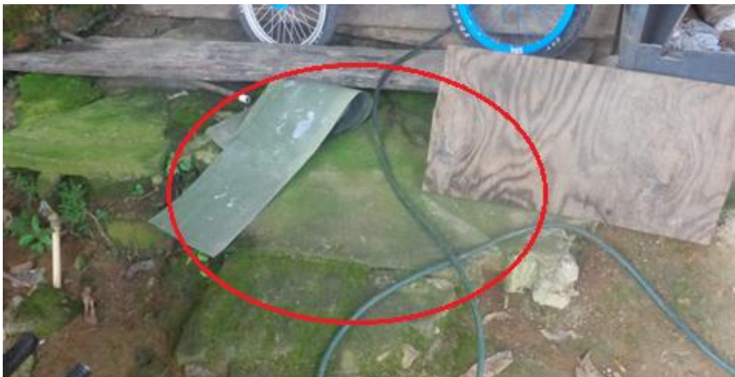
Imagen 111: Caja de inspección bajo concreto
