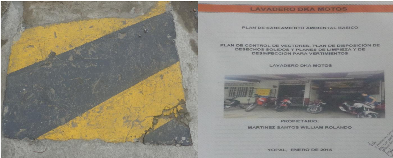
Imagen 44: Caja de inspección sellada
