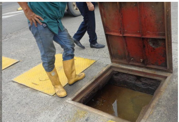
Imagen 76. Inspección trampa grasas
