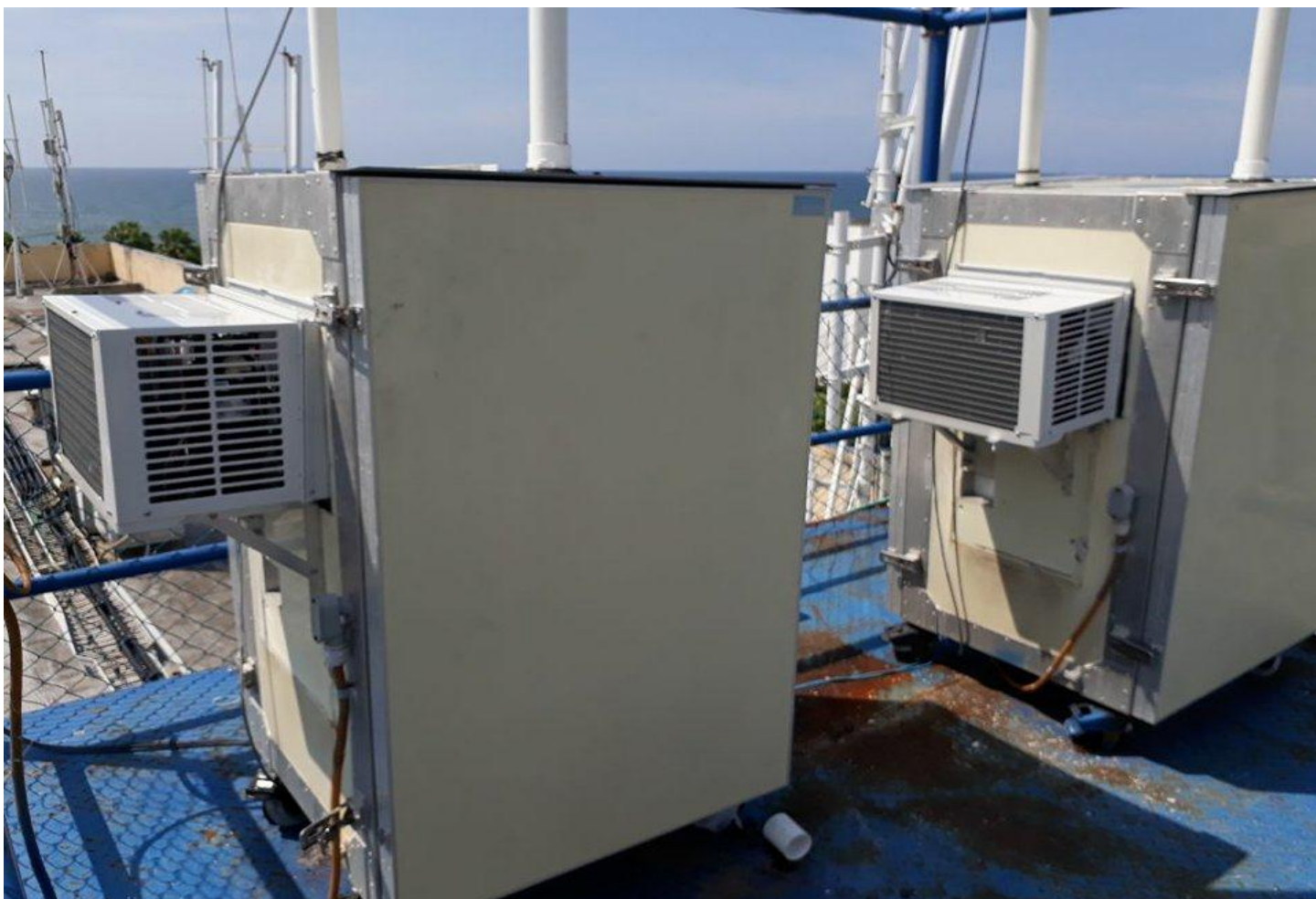
Figura 20. Instalación nuevos aires acondicionados Estación base naval
