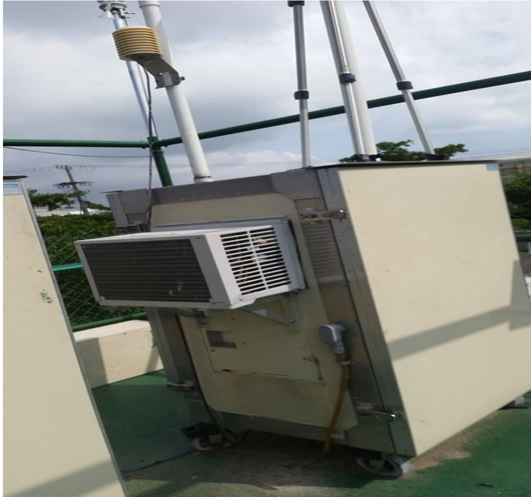
Figura 21. Instalacion nuevos aires acondicionados Estacion Mamonal
