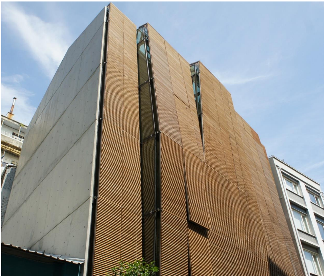
Ilustración 22. Fachada Principal de Ipera 25
