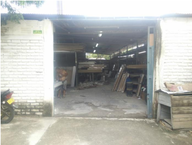
Ilustración 17 Fachada de la fábrica
