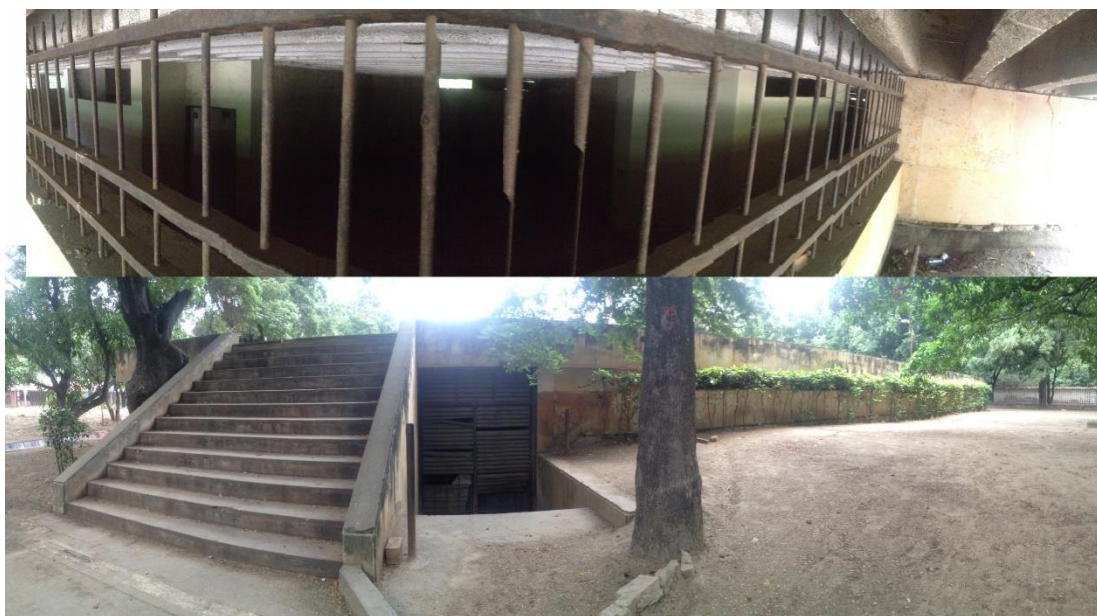
Figura 80 Sótano del parque Gran Colombiano. Fuente: propia.
