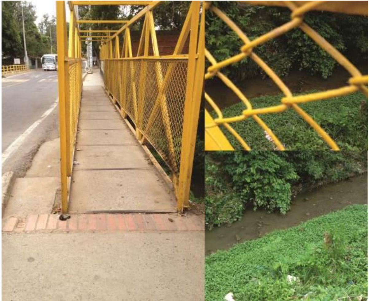
Figura 74 Fotografías del Calicanto Fuente: propia.
