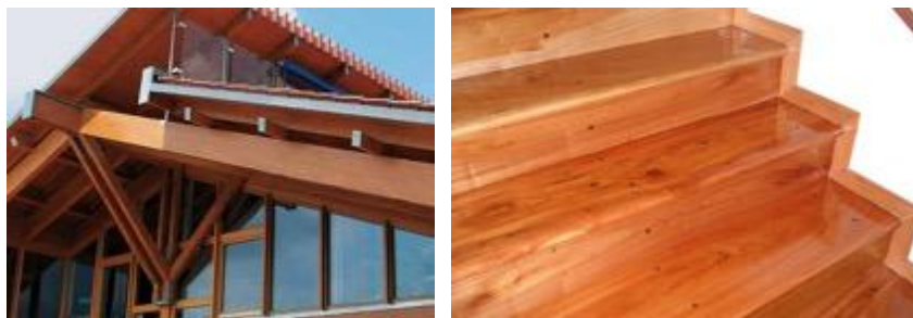
Figura 7. Cercha madera dura y escalera maderas duras
