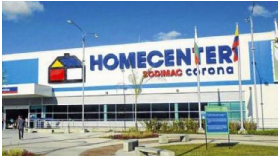
Figura 64. Home Center, Autopista norte Bogotá
