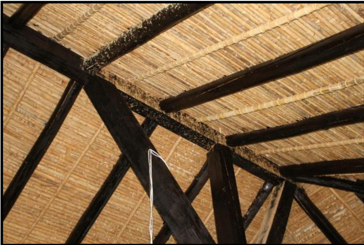
Imagen 20 La Casa Valencia presenta afectaciones en los elementos estructurales correspondientes a la cubierta ya que es evidente la presencia de plagas en las maderas que la conforman afectando la integridad estructural y física de los elementos de la misma.
