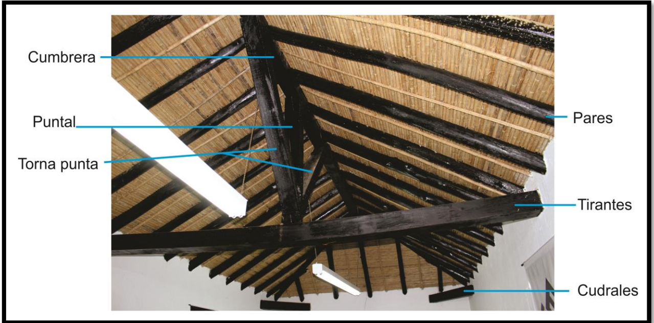
Imagen 20 La Casa Valencia presenta afectaciones en los elementos estructurales correspondientes a la cubierta ya que es evidente la presencia de plagas en las maderas que la conforman afectando la integridad estructural y física de los elementos de la misma.
