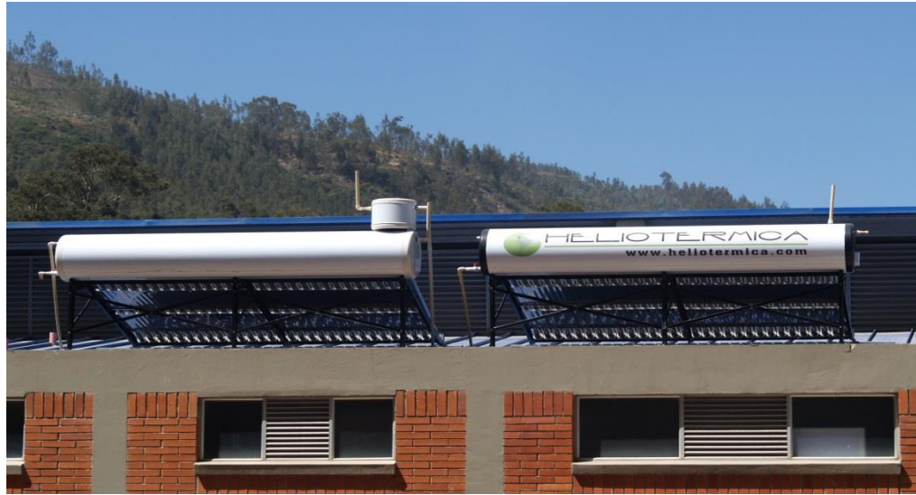
Ilustración 36. . Instalación de sistemas térmicos en Argos Sogamoso, año 2013 instalado por Heliotermica.
