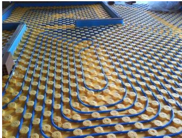
Ilustración 18: Piso radiante.
