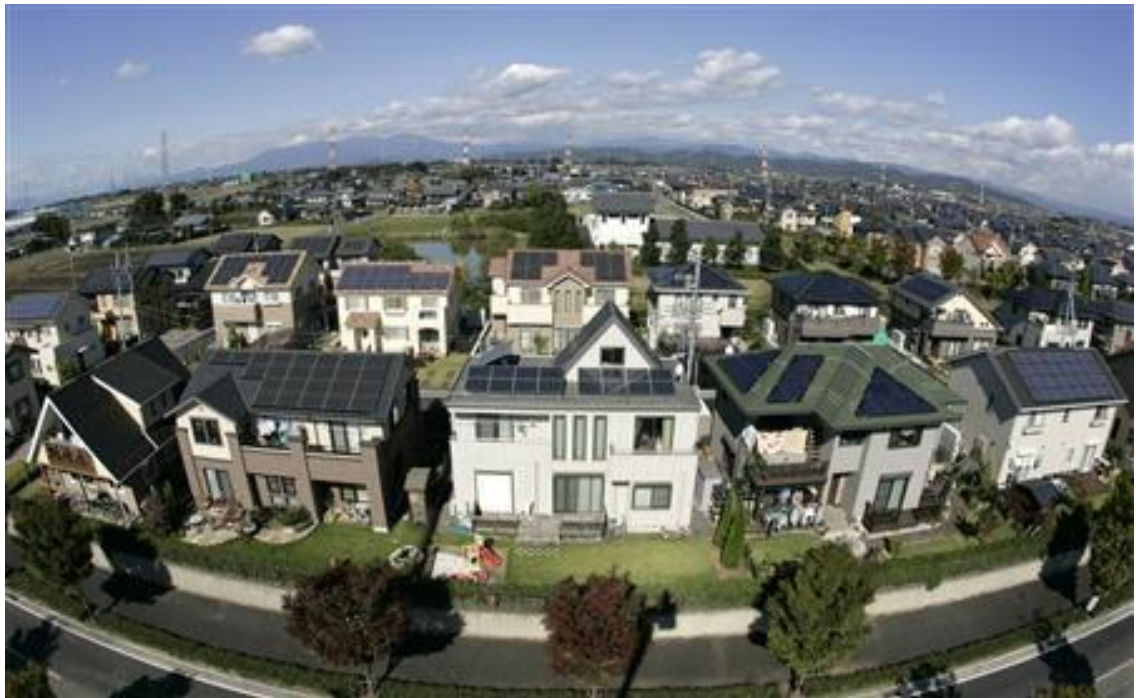
Ilustración 26. Vecindario accionado con energía solar.
