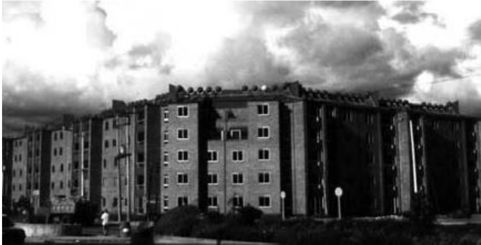
Ilustración 34. Vista de los 1250 colectores solares instalados por el centro las Gaviotas ha mediado de los ochenta en Ciudad Salitre, en Bogotá, Urbanización del Banco Central Hipotecario.
