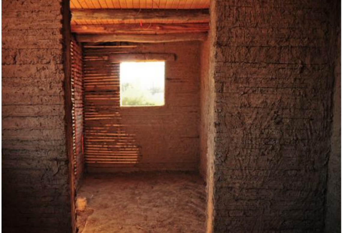
Figura 10. Representación del método quincha. Fuente: Autor 2019.
