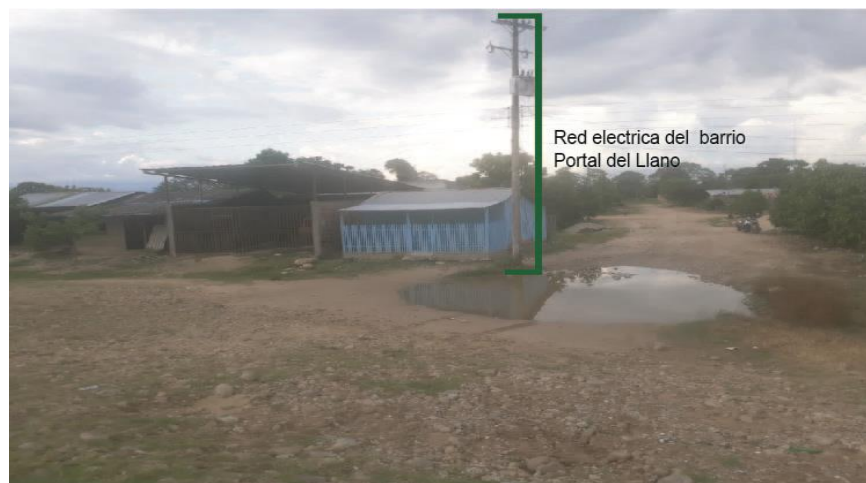
Figura 3. Red eléctrica del barrio portal del llano. Fuente: Autor 2019.
