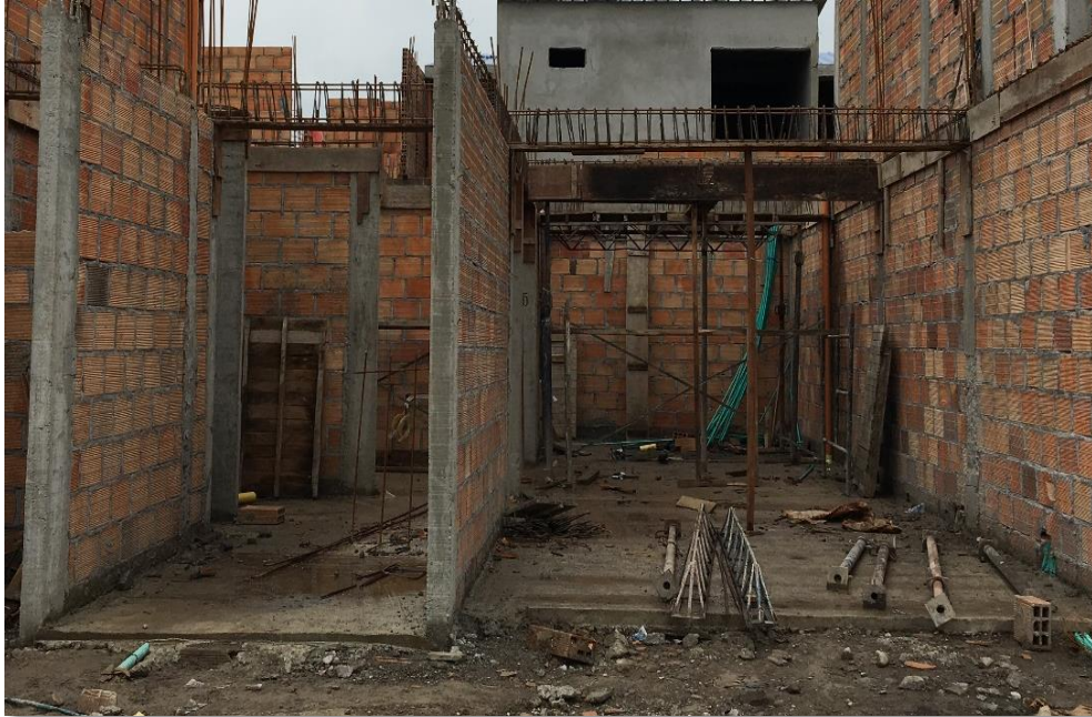
Figura 33. Casa después de fundido el alistado Fuente: Propia
