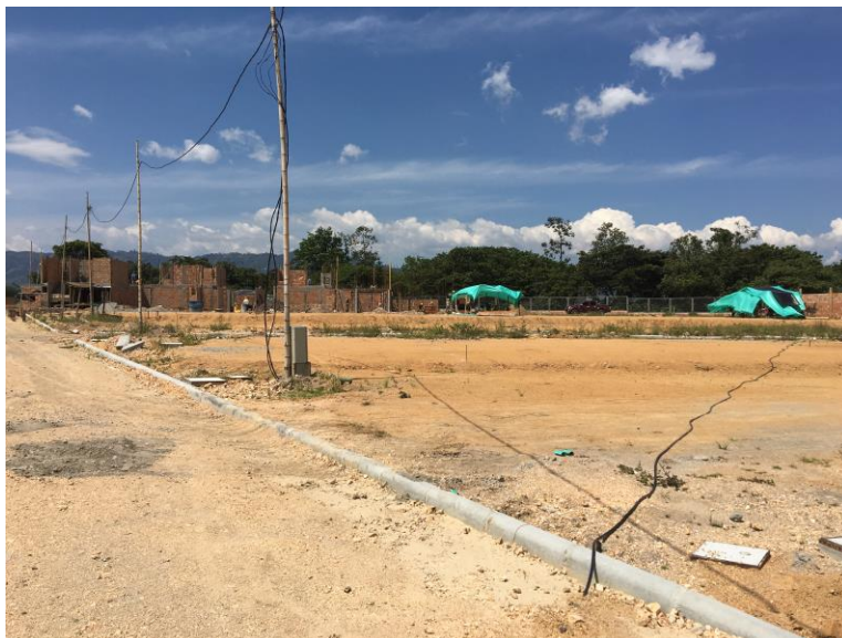
Figura 5. Estado inicial de la obra Fuente: Propia
