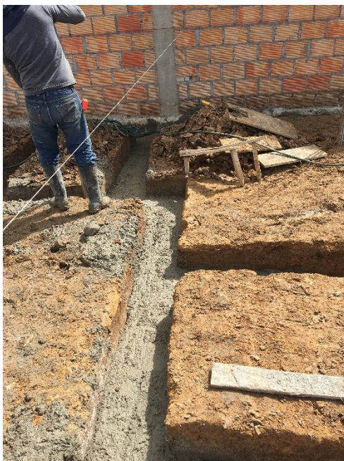
Figura 14. Solado de limpieza y nivelación Fuente: Propia.
