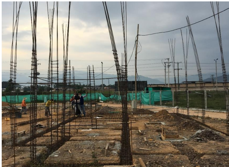
Figura 25. Instalación de aceros de columnas Fuente: Propia
