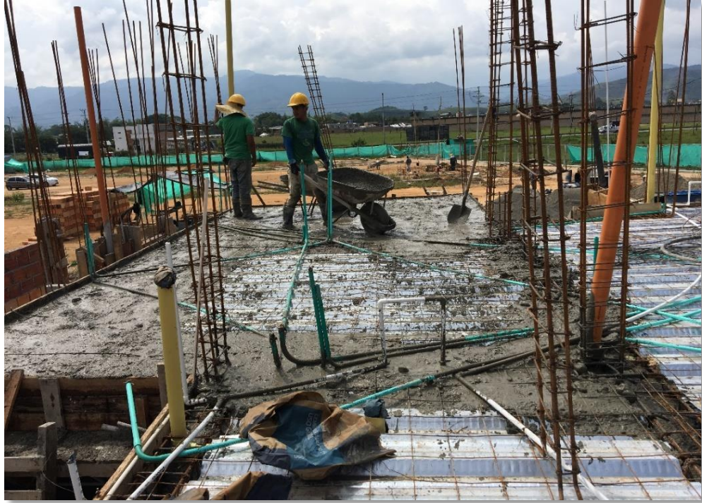
Figura 54. Fundición de la losa de entepiso Fuente: Propia
