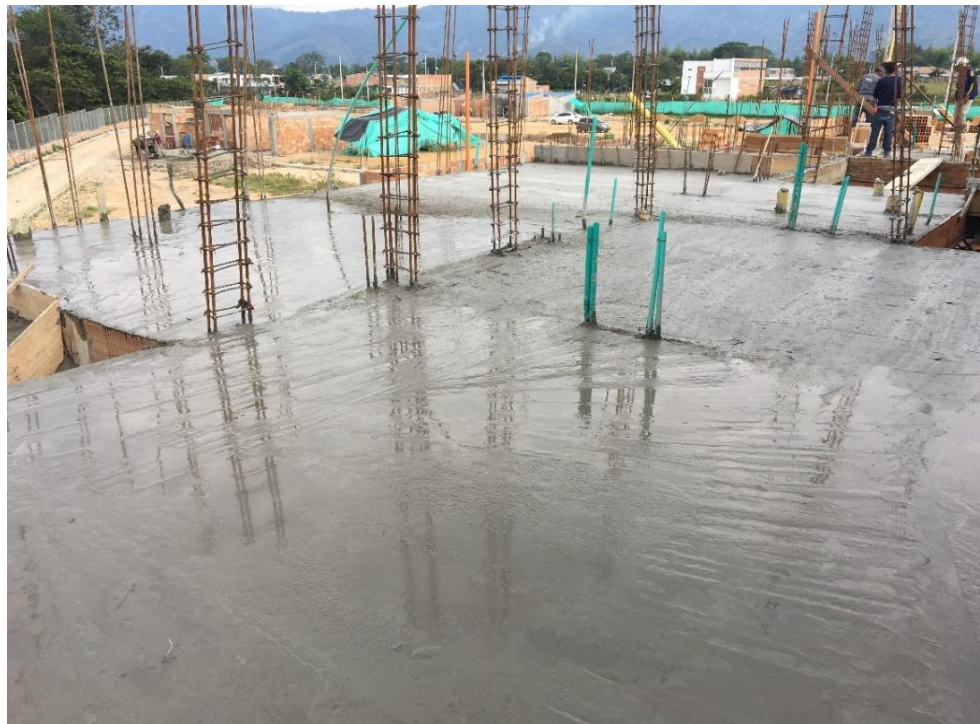
Figura 55. Losa de entepiso fundida Fuente: Propia
