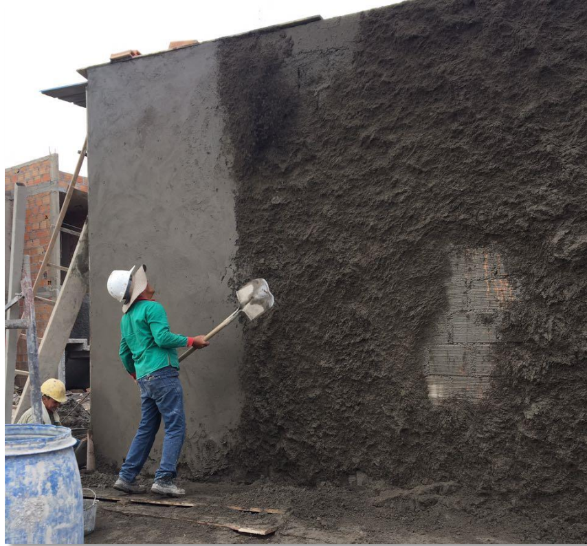
Figura 47. Maestro pañetando la parte exterior Fuente: Propia
