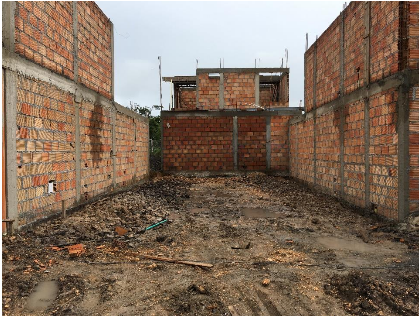
Figura 10. Explanación lote vivienda dos pisos.
