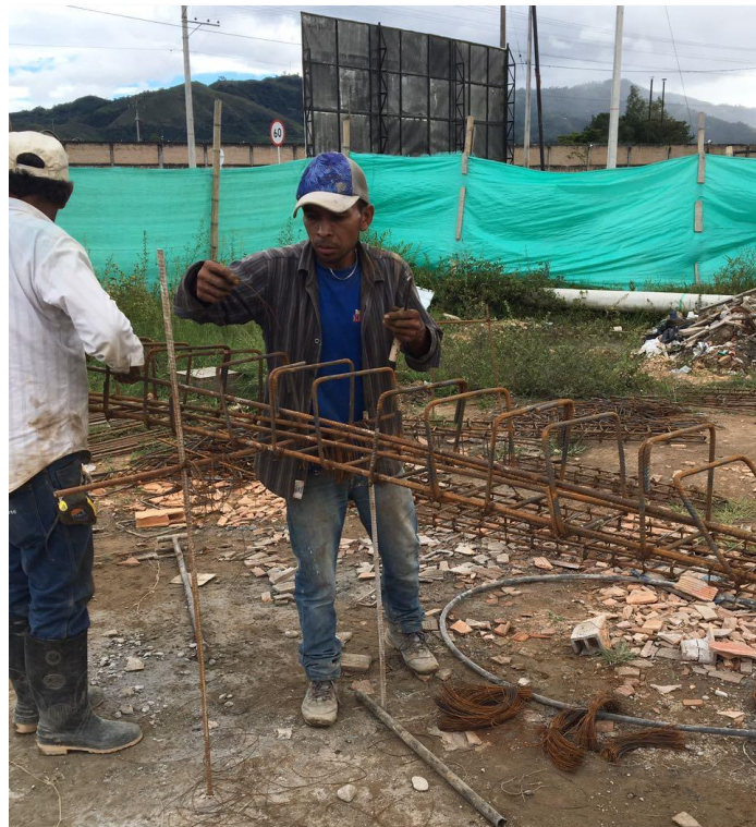
Figura 16. Figurado de acero para cimentación Fuente: Propia
