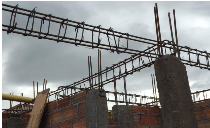
Figura 28. Acero de las vigas aéreas Fuente: Propia
