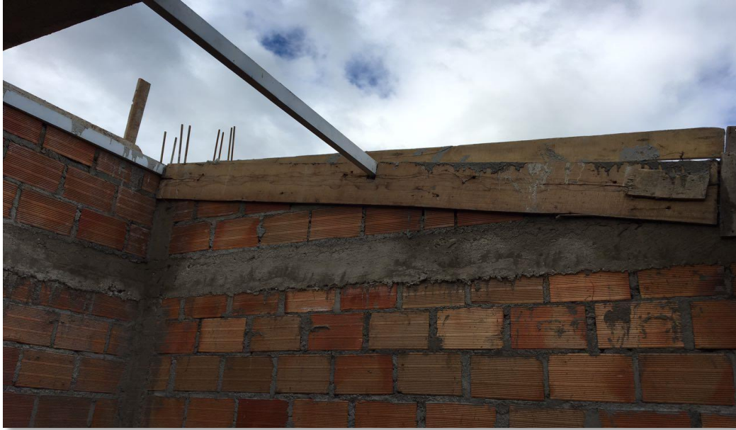
Figura 41. Viga cinta fundida y amarrada a los perfiles de cubierta Fuente: Propia
