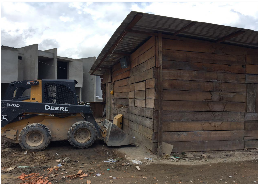
Figura 61. Almacén de la obra Fuente: Propia
