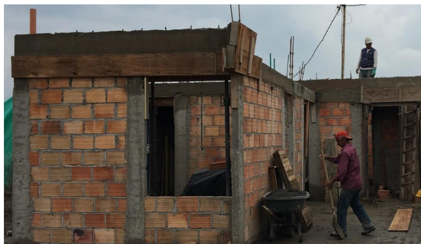
Figura 29. Colocación de las formaletas de vigas Fuente: Propia
