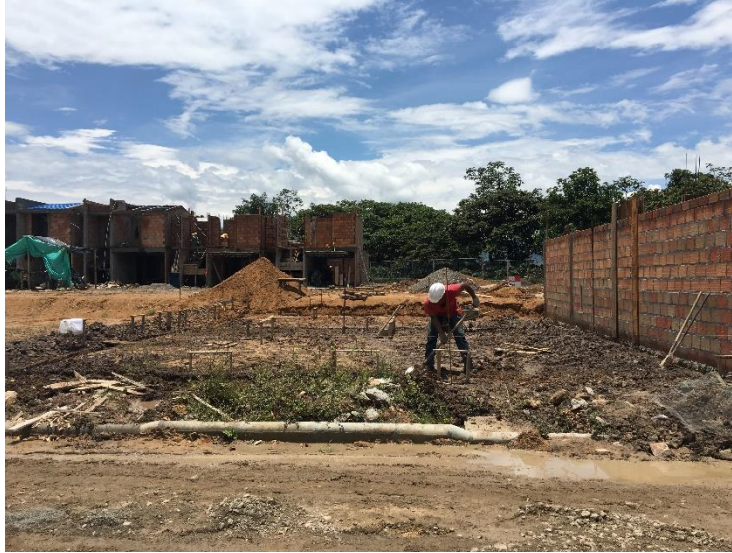
Figura 13. Excavación manual Fuente: Propia
