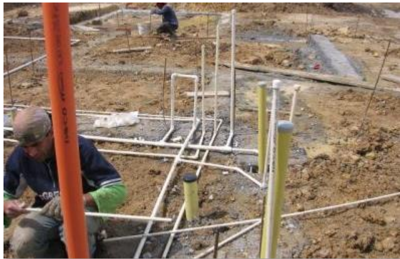
Figura 20. Oficial instalando las conducciones Fuente: Propia
