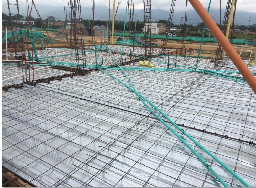
Figura 52. Instalación de la lámina metal deck, malla electrosoldada y conducciones Fuente: Propia
