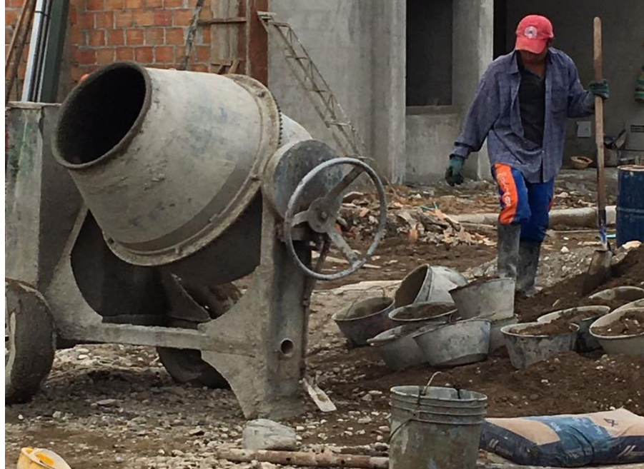
Figura 31. Cuñetes con el material para fundir el alíado Fuente: Propia
