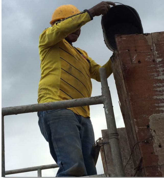
Figura 26. Fundición de las columnas Fuente: Propia
