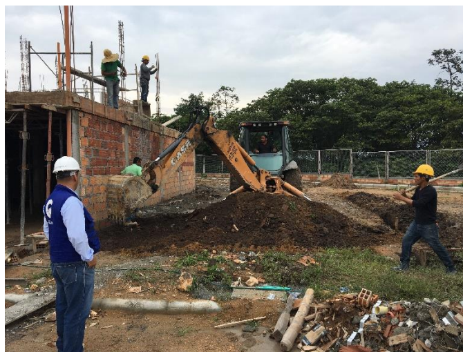
Figura 12. Excavación mecánica Fuente: Propia
