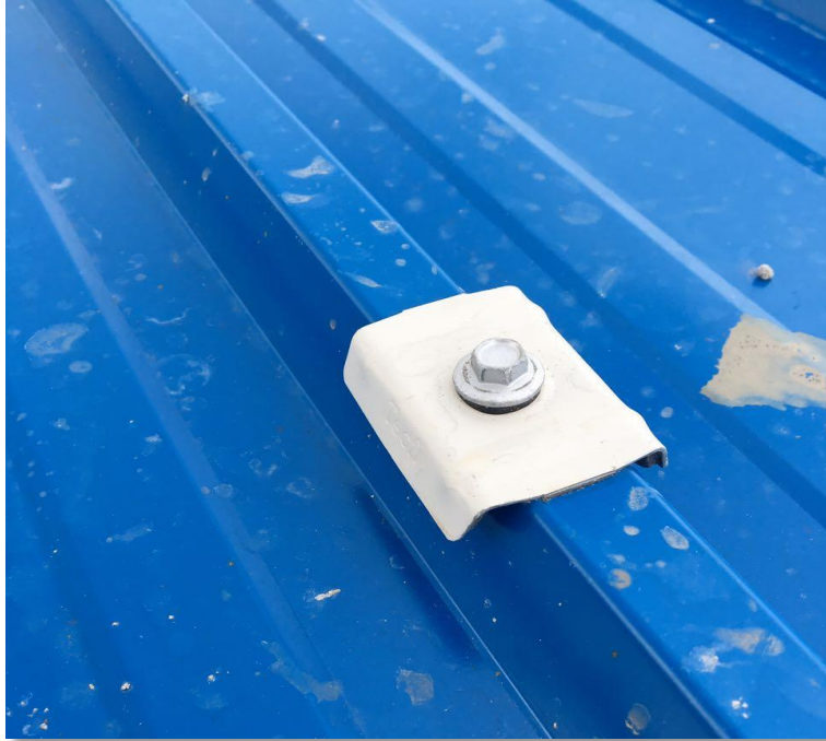
Figura 44. Detalle del tornillo y fijadores para asegurar la cubierta Fuente: Propia
