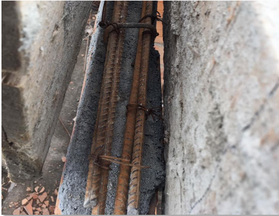
Figura 39. Refuerzo de la viga cinta previo a la fundición Fuente: Propia
