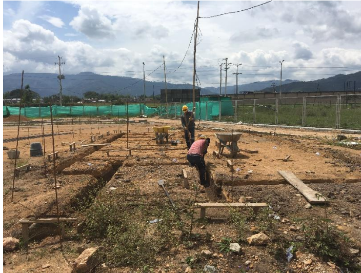
Figura 11. Puentes en el terreno para el correcto replanteo Fuente: Propia
