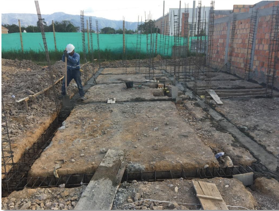
Figura 17. Fundición de la cimentación Fuente: Propia
