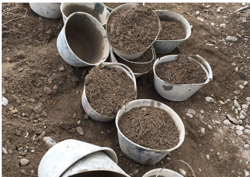
Figura 30. Baldes con el material para fundir el alistado
