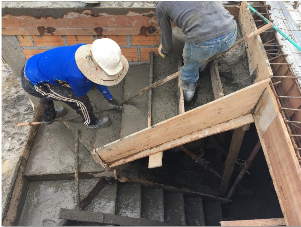
Figura 58. Fundición de las escaleras Fuente: Propia
