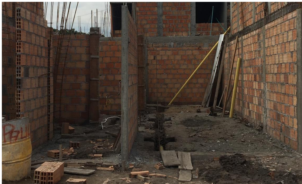
Figura 32. Casa en preparación para el alíado Fuente: Propia
