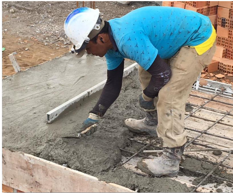
Figura 38. Fundición de la losa para tanque de almacenamiento Fuente: Propia
