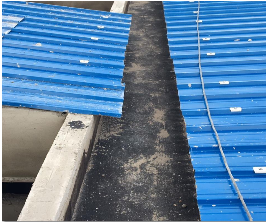
Figura 37. Viga canal recubierta con impermeabilizante Fuente: Propia
