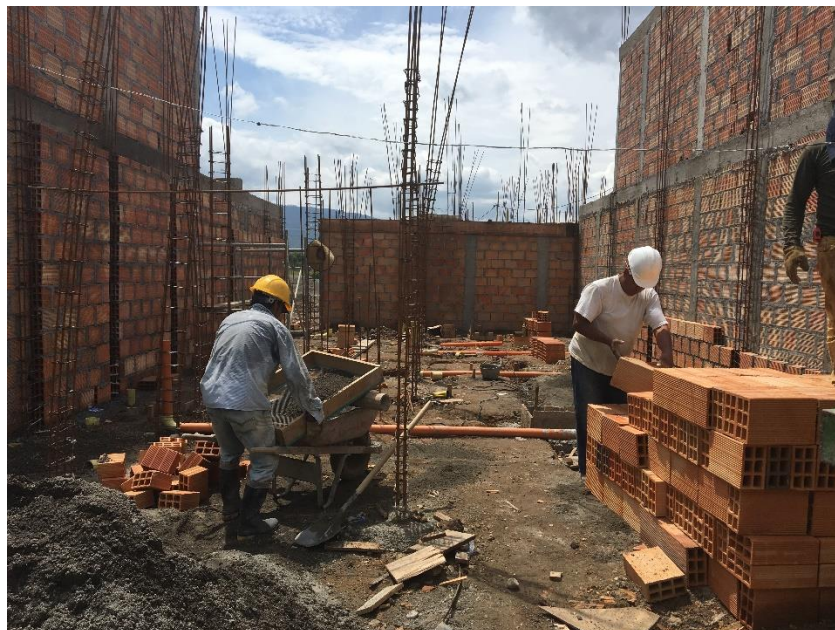
Figura 23. Maestro y obrero en levantamiento de muros Fuente: Propia
