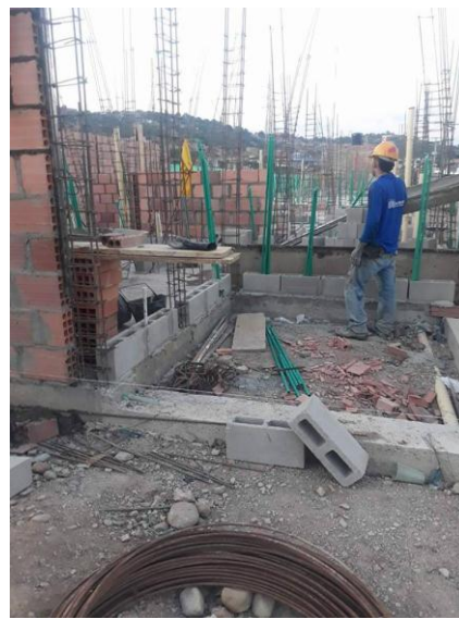
Figura 34. Replanteo bloque estructural m12 Fuente: autor.
