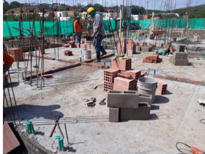
figura 32. Replanteo mampostería ladrillo macizo. Fuente: autor.
