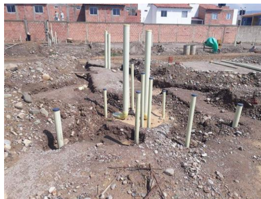
Figura 24. Instalación sanitaria. Fuente: autor.
