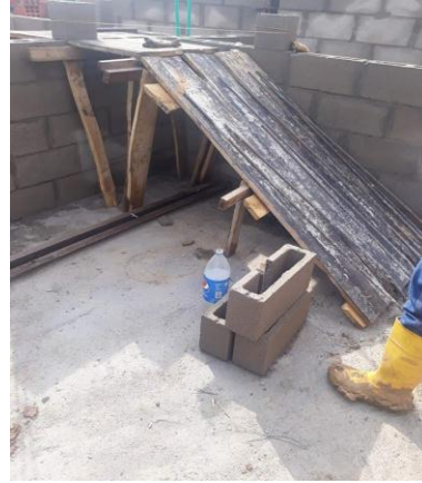
Figura 29. Encofrado escalera. Fuente: autor.
