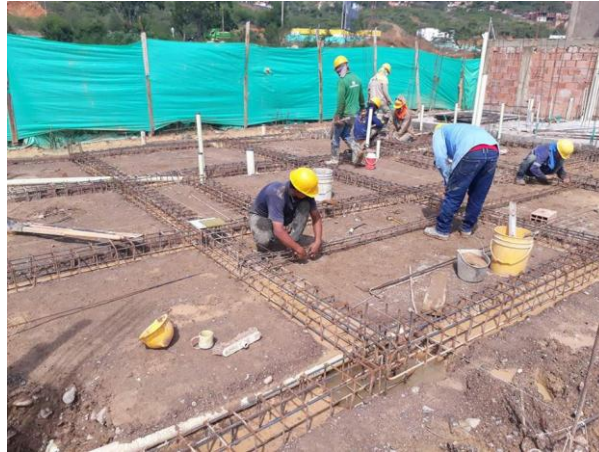
Figura 27. Montaje estructura placa de cimentación. Fuente: autor.
