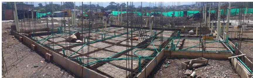
Figura 30. placa de cimentación antes de fundir. Fuente: autor.
