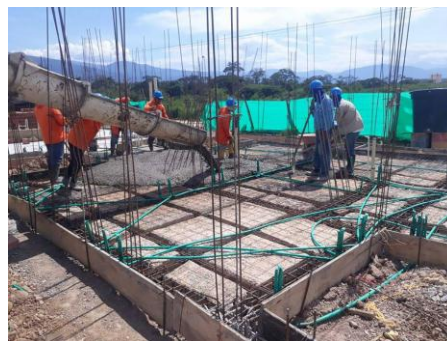
Figura 31. Fundida placa de cimentación. Fuente: autor.
