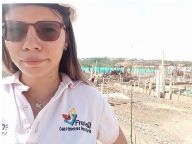
Figura 31. Levantamiento acta de entrega instalación sanitaria. Fuente: autor.
