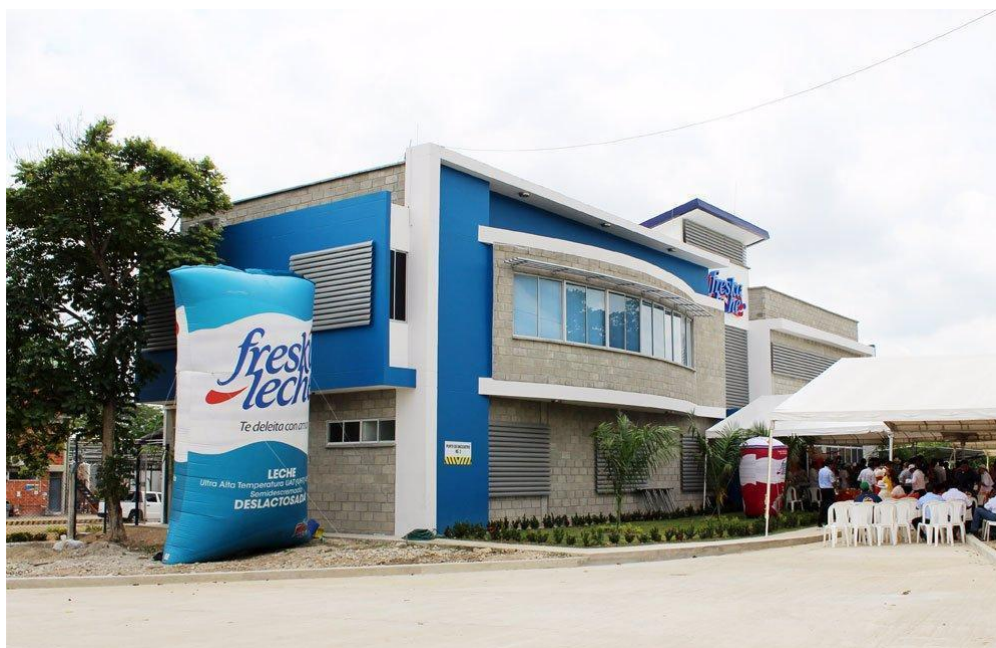
Imagen 1. Visualización parcial instalaciones Freskaleche S.A.S.
