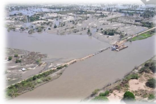
Fotografía 3. Boquete Canal del Dique Municipio de Santa Lucía Reparado/Gobernación del Atlántico.
