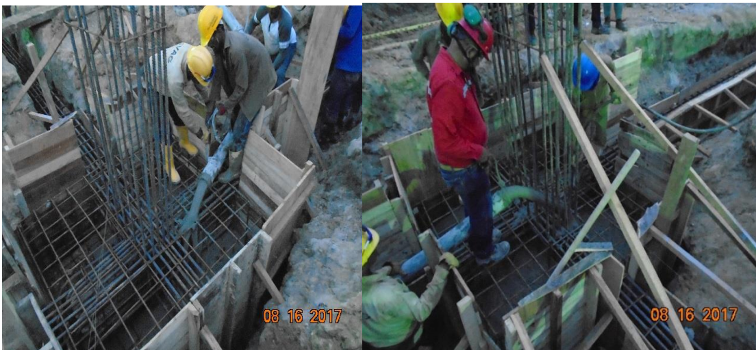
Figura 19. Fundida de vigas y zapatas de cimentación
