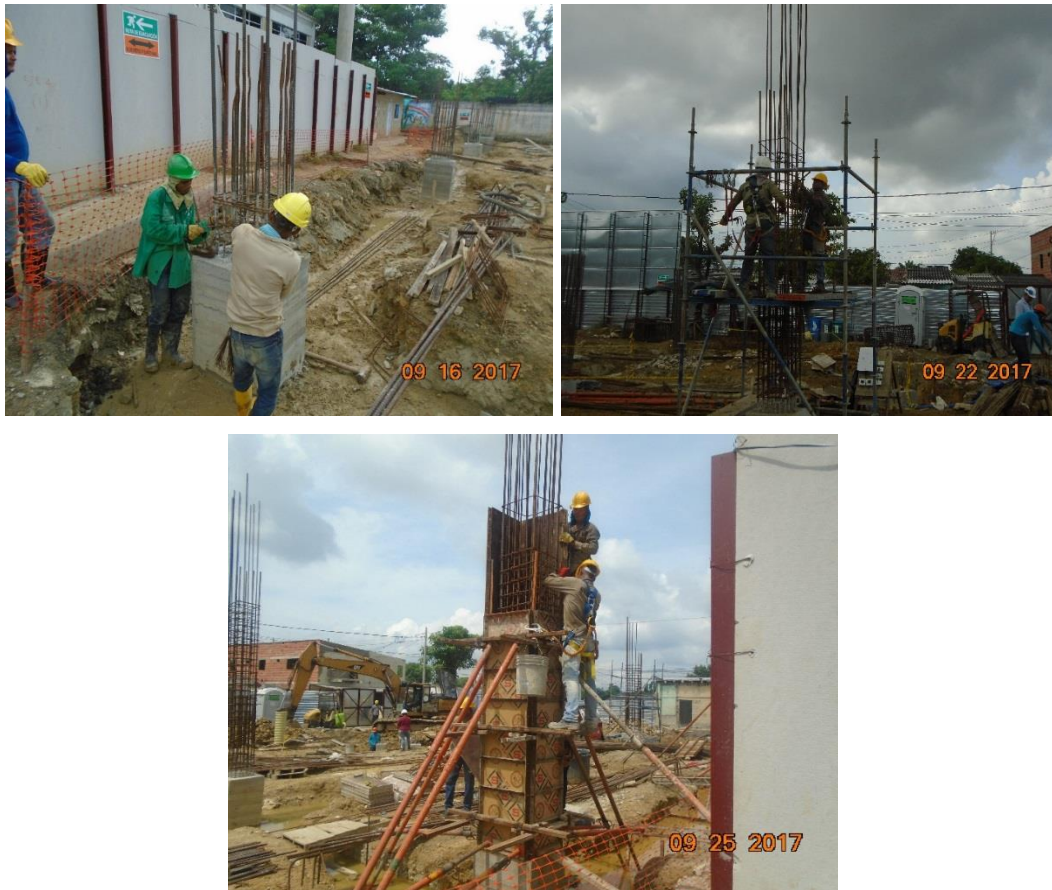
Figura 26. Figuración de acero de refuerzo para columnas
