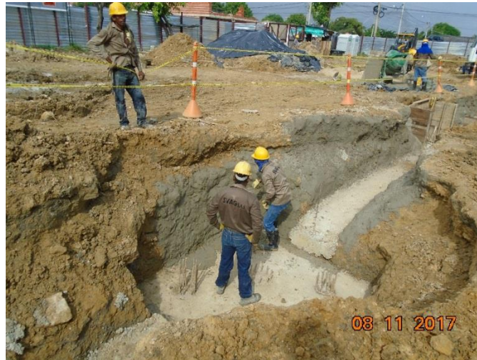
Figura 16. Protección de talud con concreto pobre
