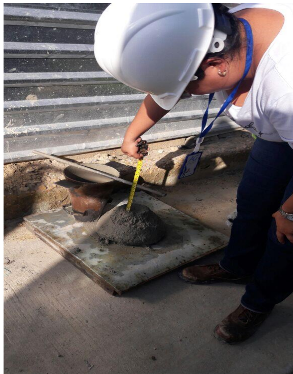
Figura 34. Verificación prueba de slump
