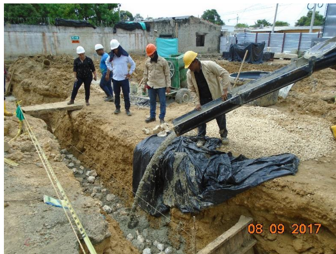
Figura 15. Construcción concreto ciclópeo
