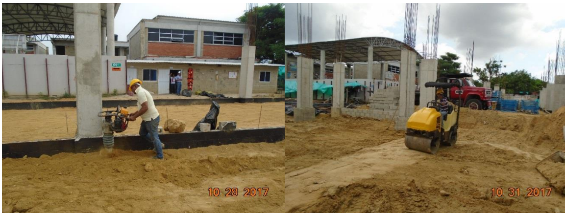
Figura 29. Relleno con material seleccionado
