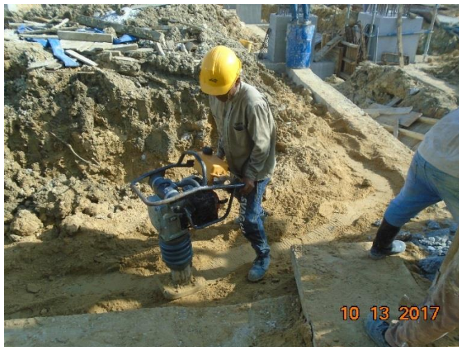
Figura 23. Relleno perimetral de vigas
