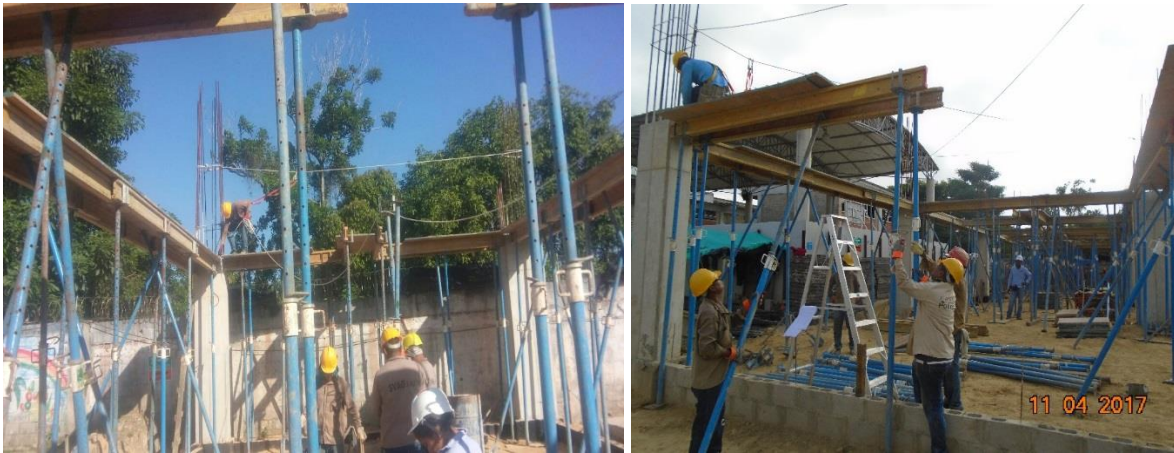
Figura 30. Entarimado de placa de segundo piso
