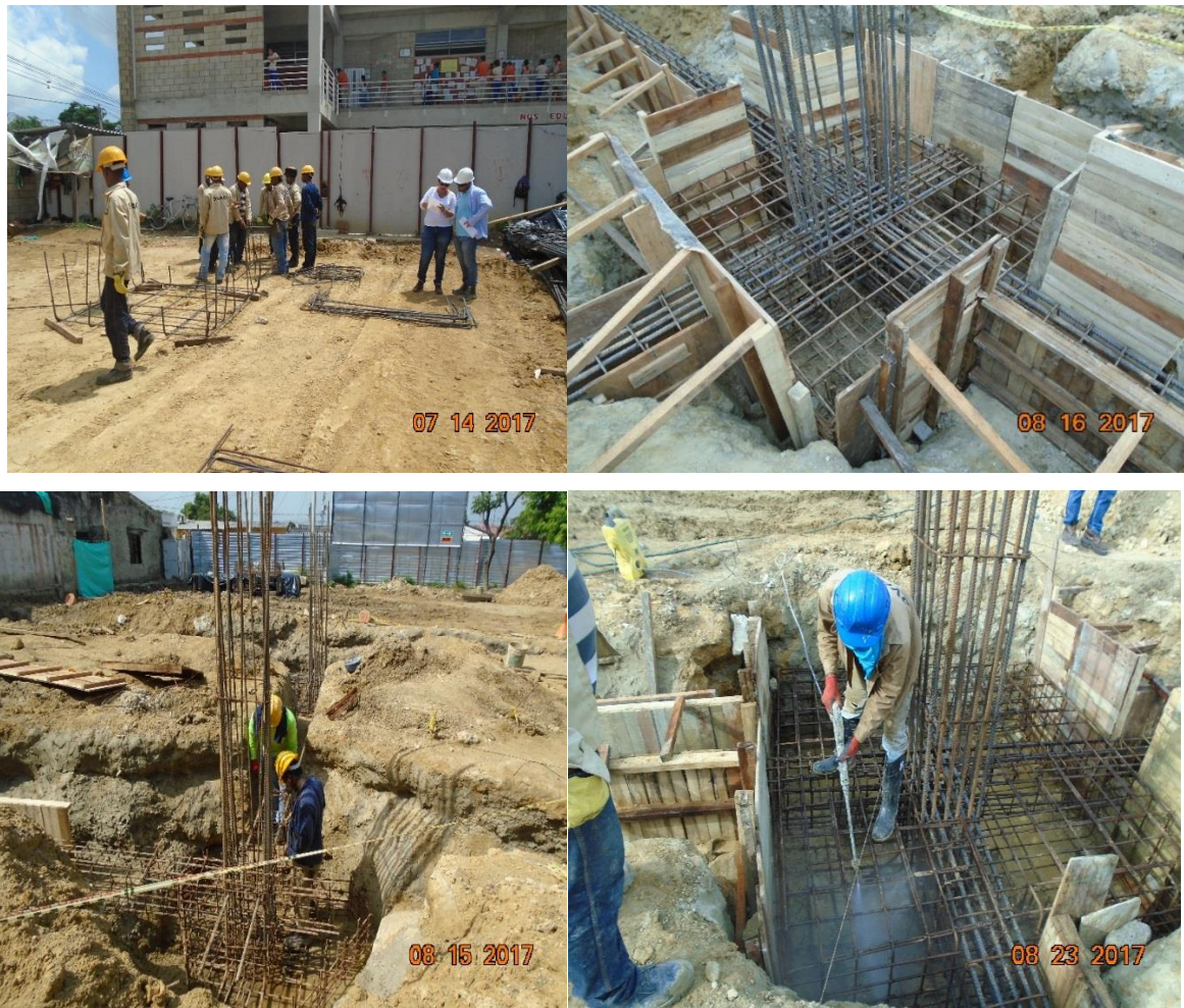
Figura 17. Figuración, colocación y limpieza de acero de refuerzo
