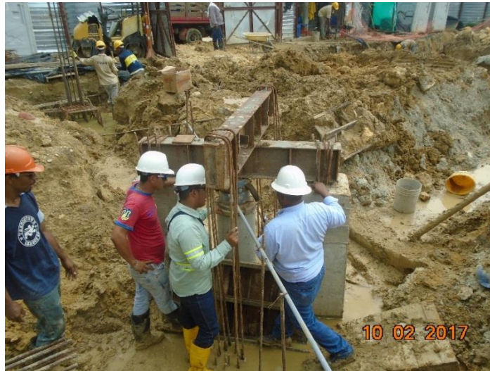
Figura 12. Prueba de carga
