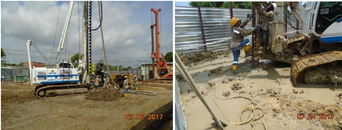
Figura 10. Perforación, fundida, y colocación de acero de refuerzo en pilotes
