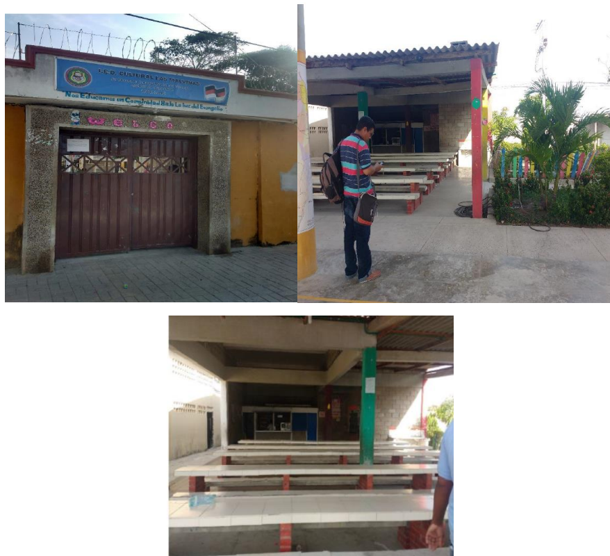
Figura 5. Ubicación del plantel (antes de iniciar la obra).
