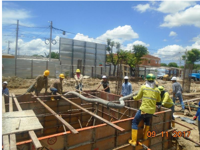
Figura 22. Fundido tanque subterráneo
