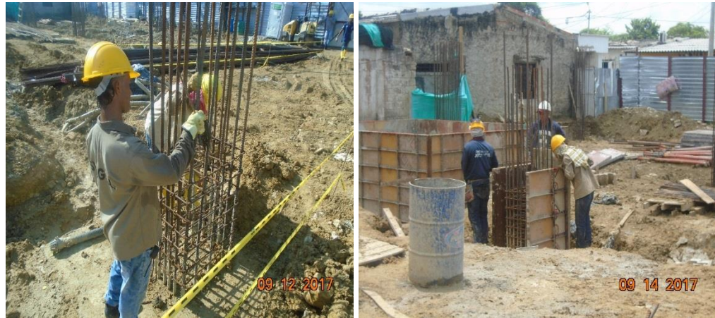
Figura 24. Figuración y encofrado de pedestales de columnas
