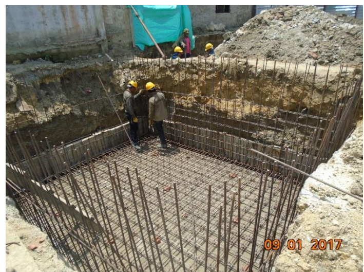
Figura 21. Figuración y colocación de acero en tanque subterráneo
