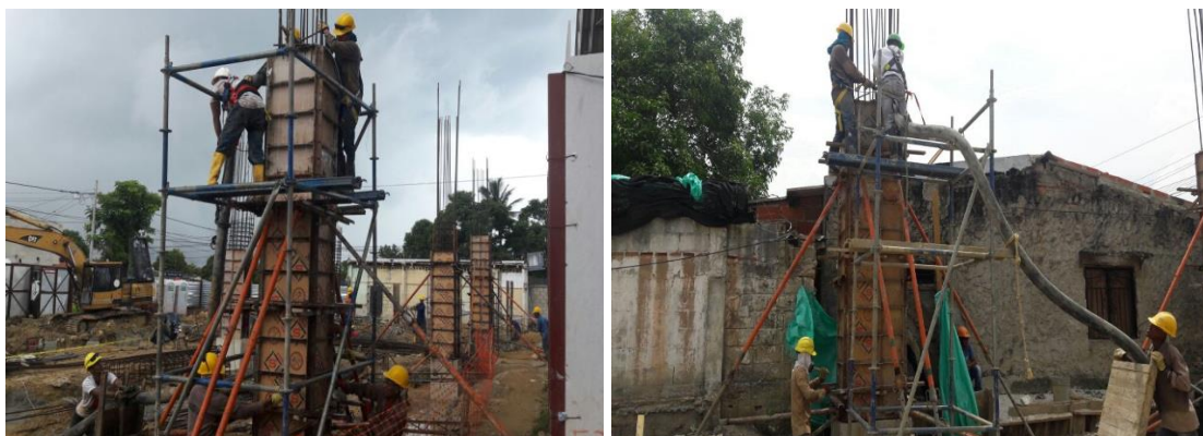
Figura 27. Fundida de columnas
