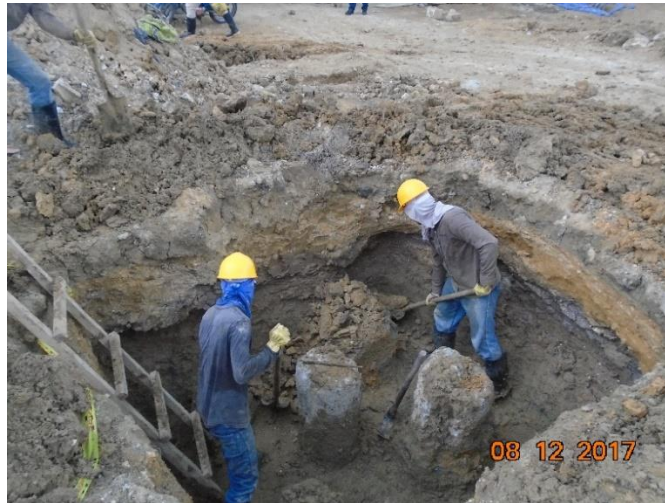
Figura 13. Excavación para vigas y zapatas de cimentación
