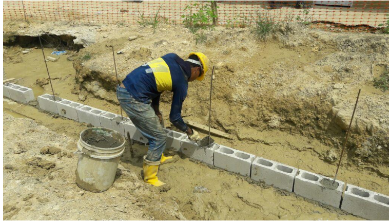
Figura 28. Levante de mampostería
