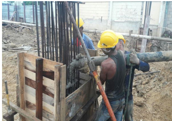
Figura 25. Fundida de pedestales de columnas
