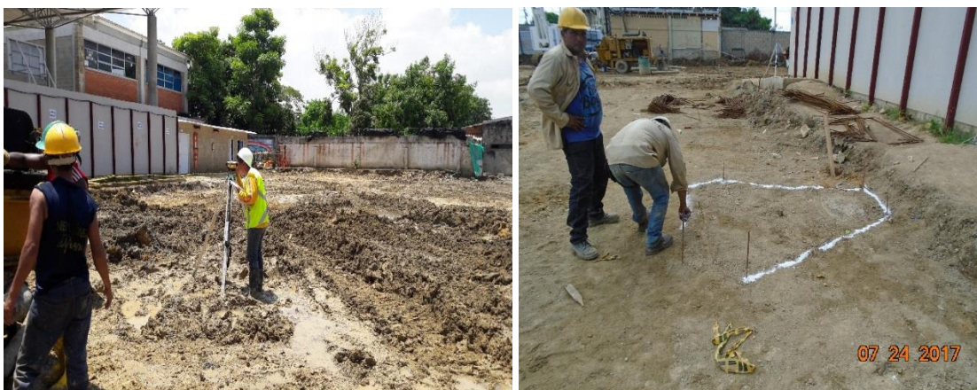
Figura 9. Trazado y verificación de niveles
