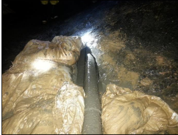
Imagen 13. Bombeo de mortero en perforación derecha aguas arriba. Fuente: Autor
