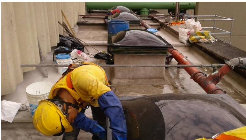
Imagen 32 limpieza de cúpulas y aseo de placas. fuente: Autor
