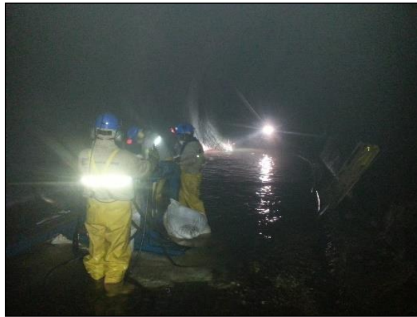
Imagen 8 Actividades de perforación aguas arriba. Fuente: Autor
