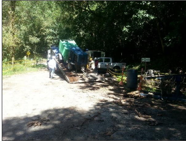
Imagen 4 descargue de equipos de perforación. Fuente: Autor
