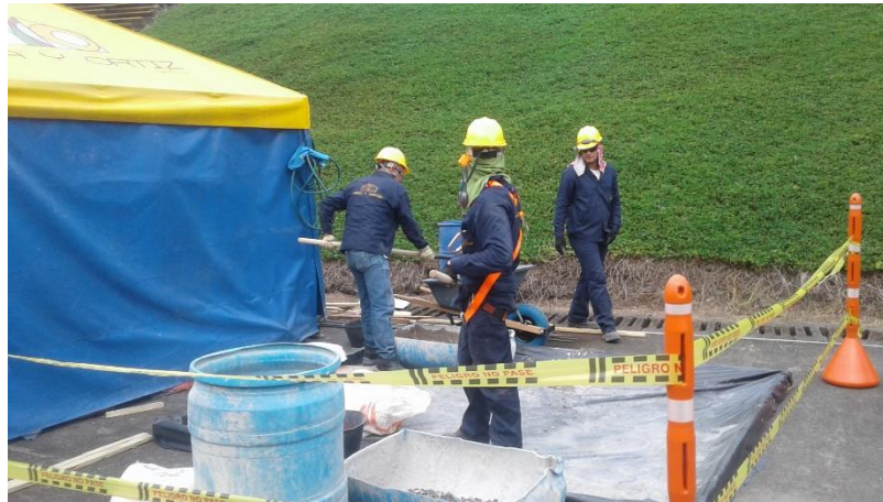
Imagen 21 Zona de mezclado para concreto. Fuente: Autor
