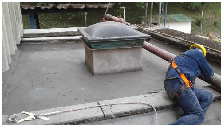
Imagen 26 Aplicación mortero listo reforzado con fibra. Fuente: Autor
