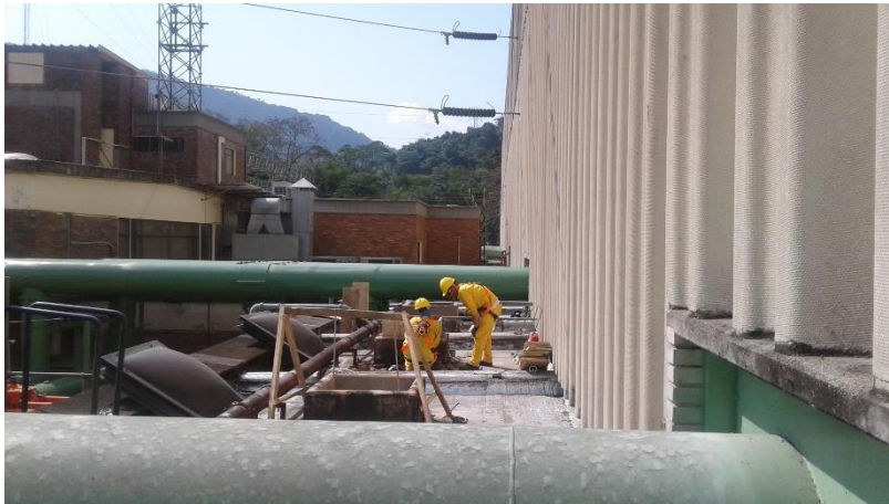
Imagen 19 Instalación de formaletas y hierros. Fuente: Autor
