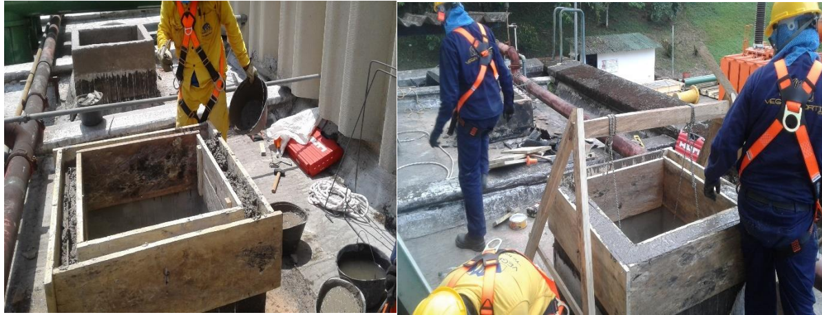
Imagen 20 Fundición de suplemento en claraboyas. Fuente: Autor
