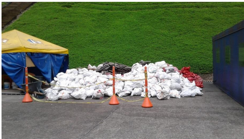
Imagen 30 Área designada para depósito de escombros. Fuente: Autor
