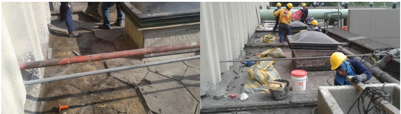
Imagen 23 levantamiento de prefabricado. Fuente: Autor
