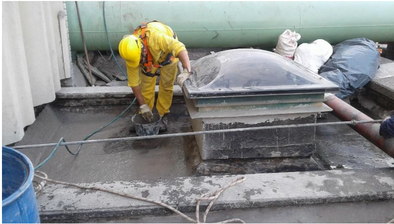
Imagen 24 Aplicación de Xypex concentrado
