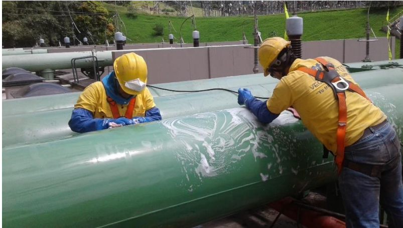
Imagen 31 limpieza de tubos de conducción de líneas hacia transformadores. Fuente: autor
