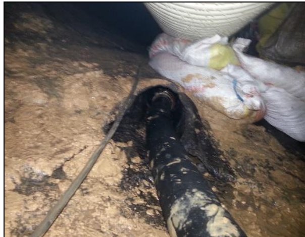
Imagen 12. Bombeo de mortero en perforación izquierda aguas arriba. Fuente: Autor
