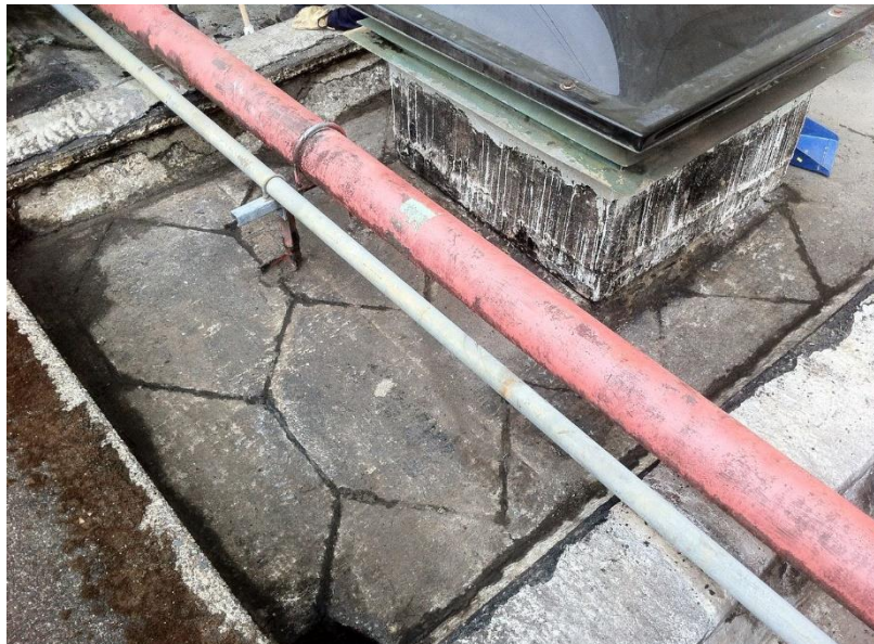
Imagen 22. Retiro de manto asfáltico. Fuente: Autor
