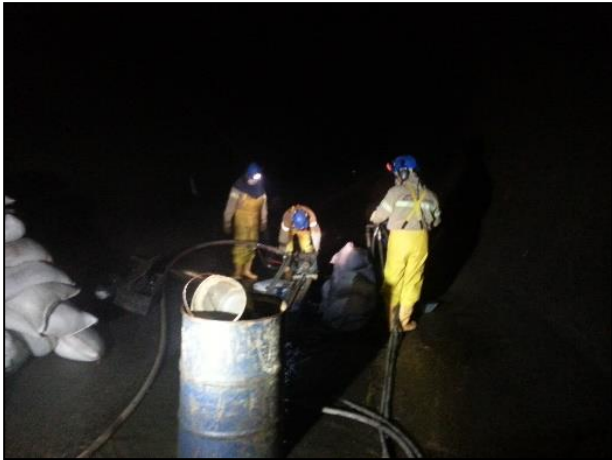
Imagen 7 Inicio de actividades de perforación. Fuente: Autor
