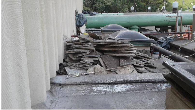
Imagen 29 depósito de material prefabricado. fuente: autor
