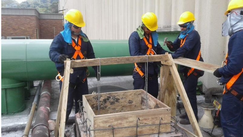
Imagen 18 Instalación de hierros y formaletas para suplemento de
