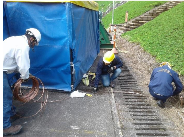
Imagen 14 Instalación de puestas a tierra del campamento. Fuente: Autor
