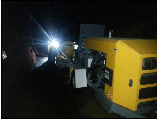
Imagen 9 Ubicación de bomba putzmeister. Fuente: Autor
