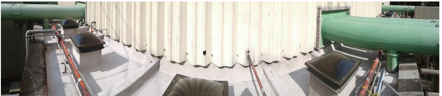
Imagen 34 Estado final de entrega de obra.
