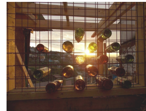
Estructura en Acero sobre Muros en barro con botellas recicladas para iluminación natural
