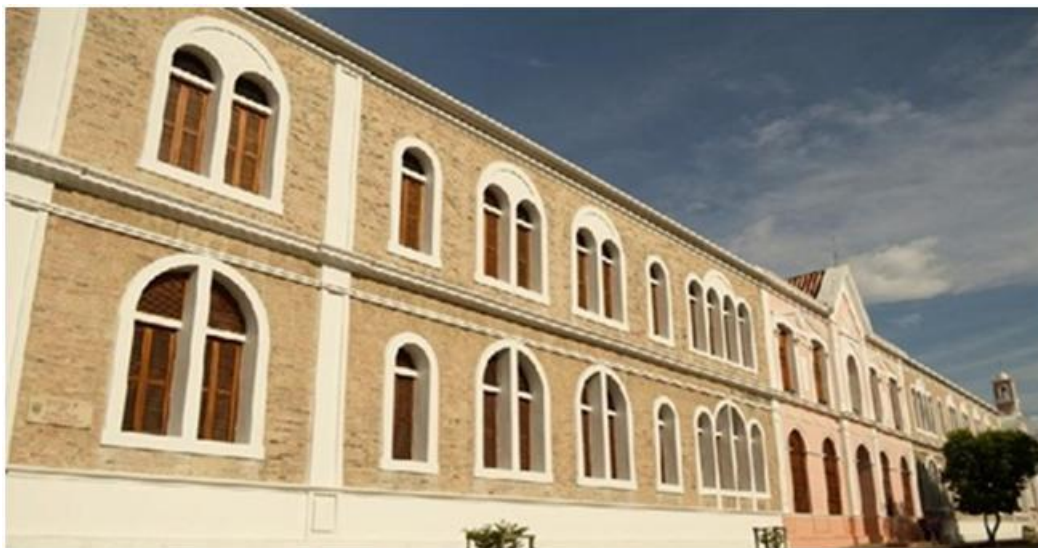
Fachada Lateral de la Biblioteca sobre la avenida 2ª Obra Ives Castañeda
