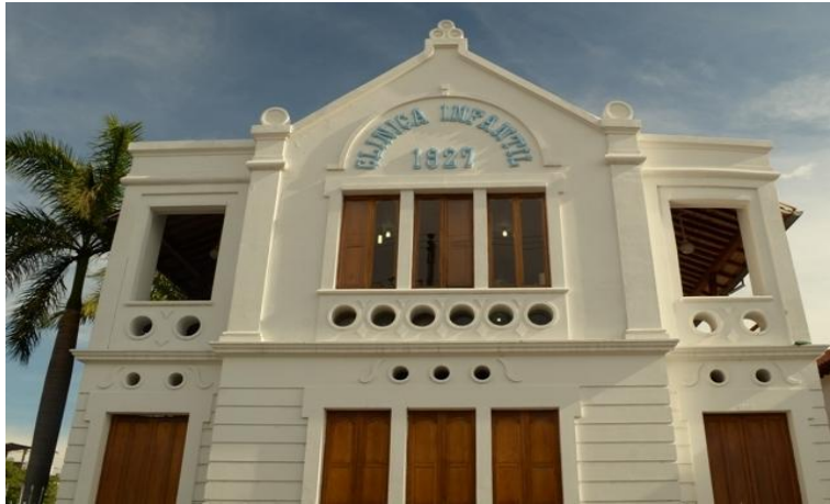
Detalle de Fachada Interna Bloque Clínica Infantil. Obra Ives Castañeda
