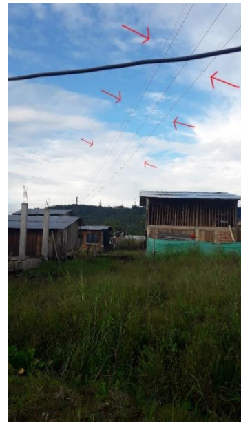
imagen 16-viviendas en zona de riesgo por redes de alta tensión-fuente autor
