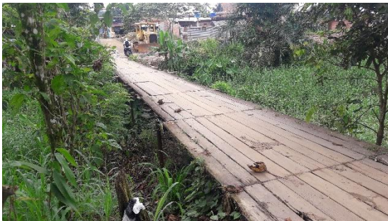
imagen 23-puente de acceso 2-fuente-autor
