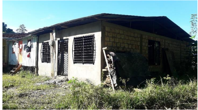
imagen 43-vivienda 2 en zona de riesgo por cota de inundación-fuente autor
