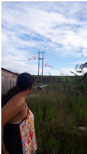
imagen 17-redes de alta tensión-fuente autor
