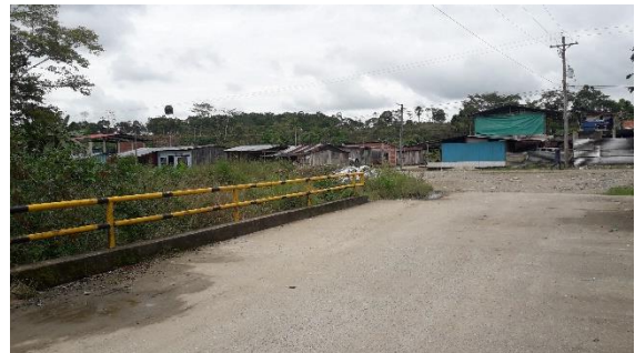
imagen 20puente de acceso 3-fuente-autor
