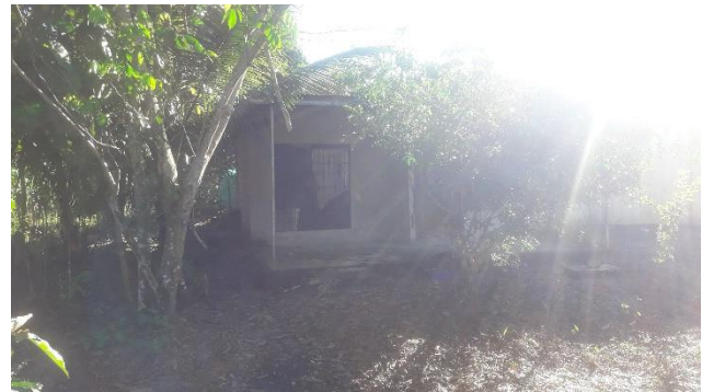
imagen 47-vivienda 6 en zona de riesgo por cota de inundación-fuente-autor
