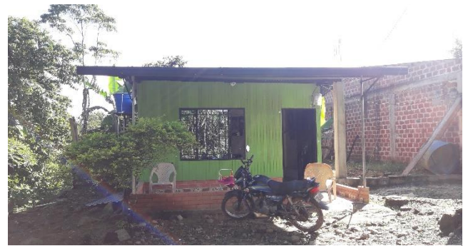
imagen 45-vivienda 4 en zona de riesgo por cota de inundación-fuente autor
