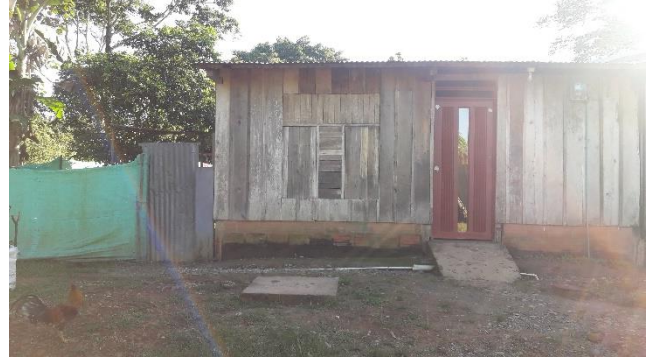
imagen 46-vivienda 5 en zona de riesgo por cota de inundación-fuente -autor
