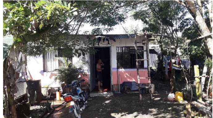
imagen 49-vivienda 8 en zona de riesgo por cota de inundación-fuente-autor
