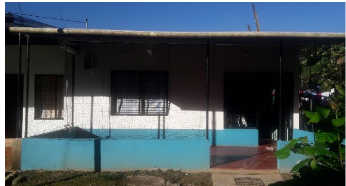
imagen 48-vivienda 7 en zona de riesgo por cota de inundación-fuente-autor
