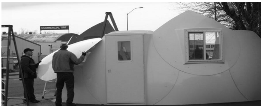
Ilustración 68 Proceso de ensamblaje del Intershelter. Fuente: Tomado de https://c2hh.com/product/intershelter-20ft-polar-dome/
