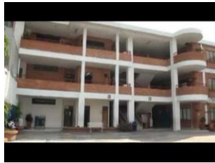
Liceo Nueva Generacion
