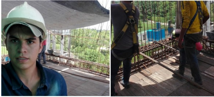
Figura 21. Amarre de acero vaciado de concreto para la placa, muros, vigas y columnas del ultimo nivel.
