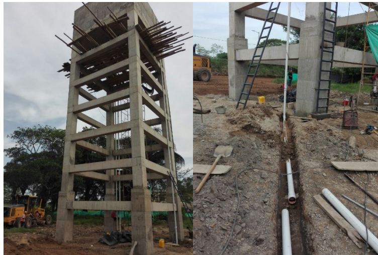
Figura 22. Instalación hidráulica y escalera hasta la h=20,45.
