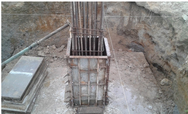
Figura 13. Instalación de la formaleta y Vaciado de concreto de pedestales.
