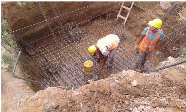
Figura 9. amarre del acero para las zapatas
