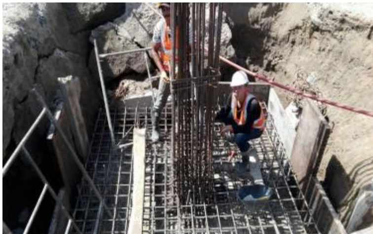
Figura 11. Amarre del acero para los pedestales.
