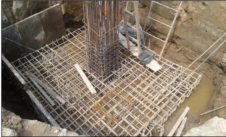
Figura 10. Amarre del acero para los pedestales y pilotes.
