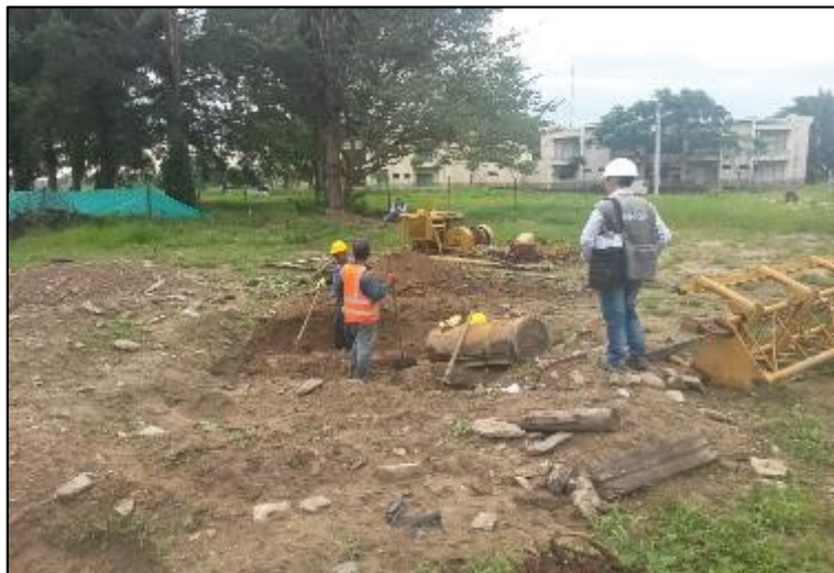
Figura 5. Excavación manual de material heterogéneo.
