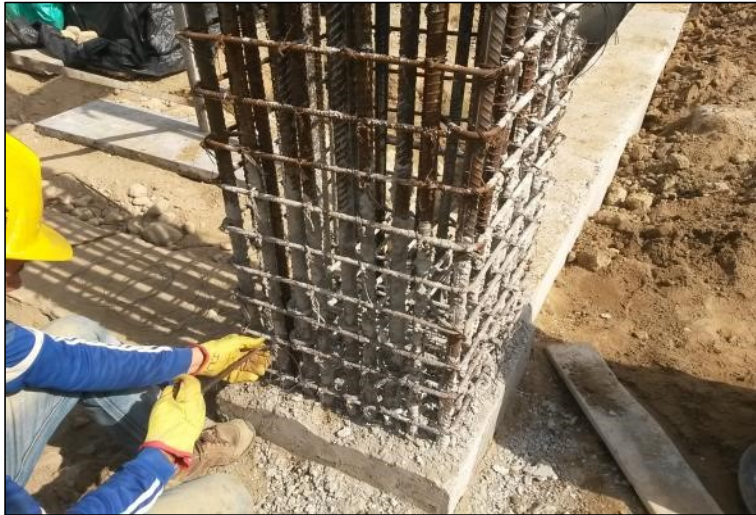
Figura 16. Amarre de acero para columnas.
