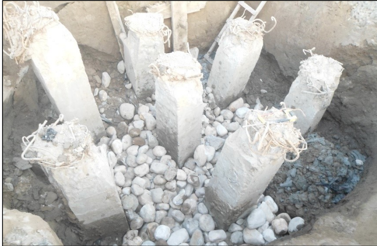
Figura 8. Rellenó con canto rodado alrededor de los pilotes.
