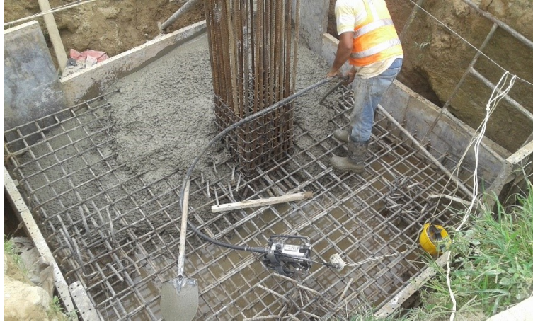
Figura 12. Vaciado de concreto en zapatas
