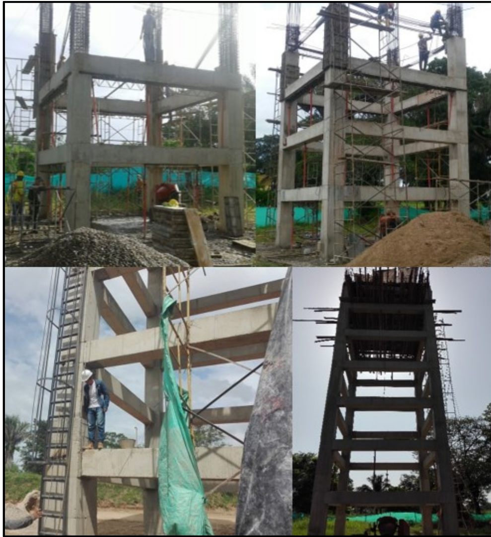
Figura 20. Columnas y vigas del nivel h=5 m, h=7.40, h=9.8m, h=12.20m y h=14.60m
