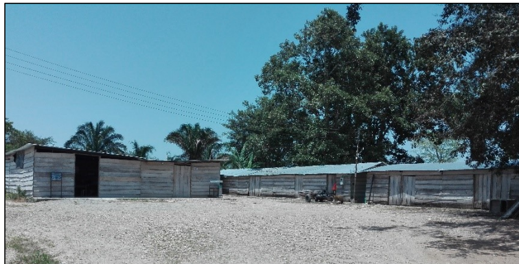
Figura 24. Bodegas de almacenamiento de materiales
