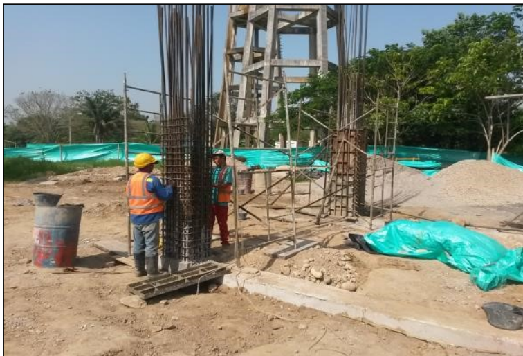
Figura 17. Amarre de acero para columnas y instalación de formaletas para las columnas del primer nivel.
