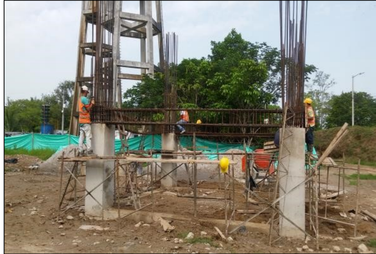
Figura 18. Amarre de acero para columnas y vigas aéreas de h=2.6\text{ m} .
