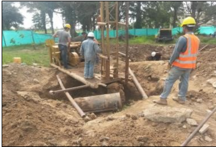
Figura 6. Hincada de pilotes.
