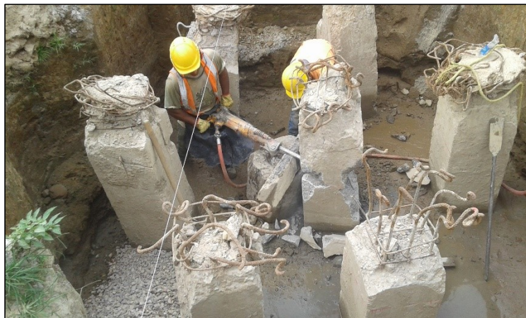
Figura 7. Descabece de los pilotes en concreto de 0.55 m
