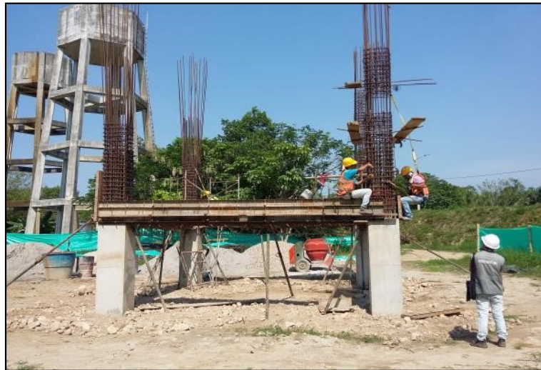
Figura 19. Amarre de acero para columnas de h=2.6\text{ m} al h=5\text{ m} .
