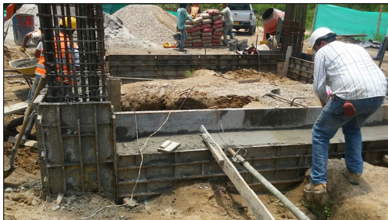
Figura 15. vaciado de concreto en las vigas de cimentación.
