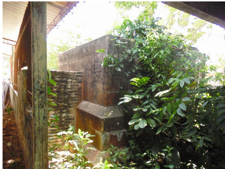
Imagen N° 28: Estación de Puerto Villamizar – Tanque de almacenamiento de agua para surtir las locomotoras y las instalaciones de la estación.
