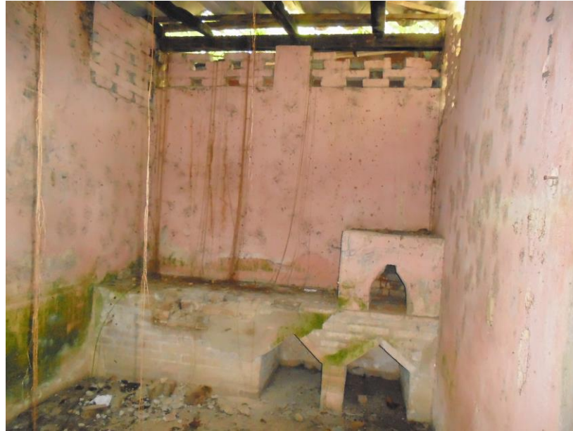
Imagen N° 27: Estación de Puerto Villamizar – Horno de leña fabricado en ladrillo tolete. Fuente: Esparza B, E. D; Vargas L., E.A & Rangel W, A. Trabajo de campo, septiembre de 2015.
