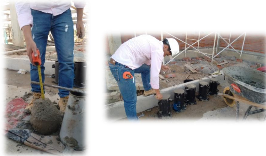
Figura 8. Ensayos de asentamiento y resistencia del concreto
