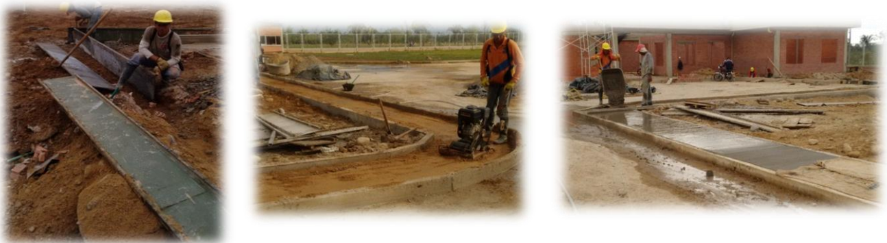
Figura 12. Replanteo, encofrado y vaciado de concreto para sardinel.
