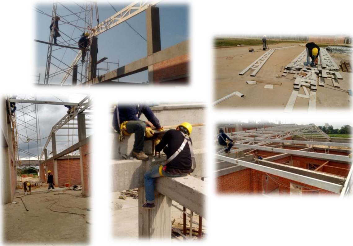
Figura 15. Montaje de estructura metálica para la cubierta.
