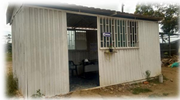
Figura 3. Oficina en obra
