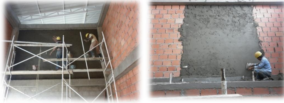
Figura 17. Pañete impermeabilizado para muros de la planta.
