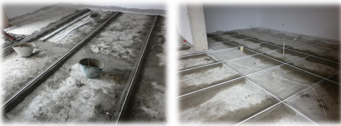
Figura 19. Mortero de nivel con dilataciones.
