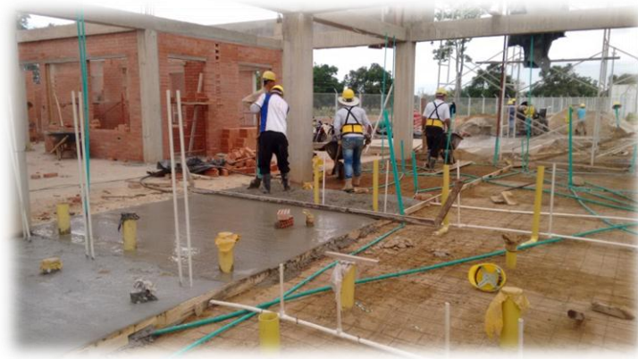
Figura 28. Encofrado, vaciado y vibrado de placa de ante piso.
