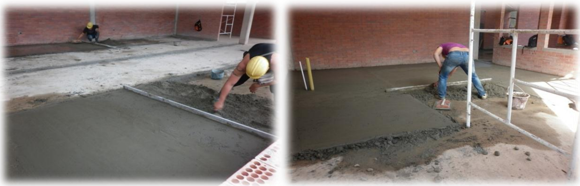
Figura 22. Mortero de nivel.
