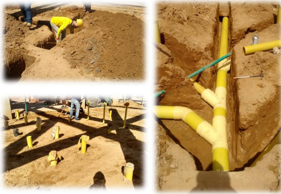
Figura 10. Excavación y tendido de tubería para puntos hidráulicos.
