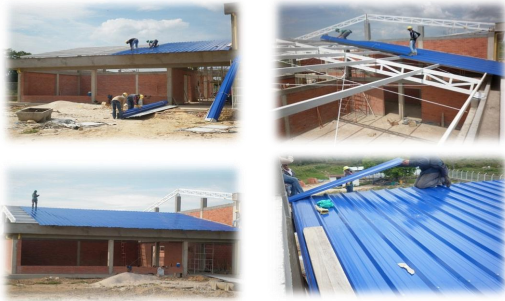
Figura 16. Techado con lamina master 1000.
