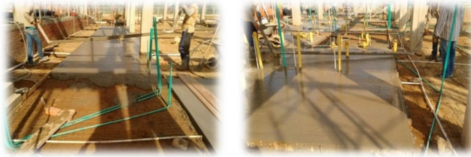
Figura 11. Vaciado de concreto para ante piso.
