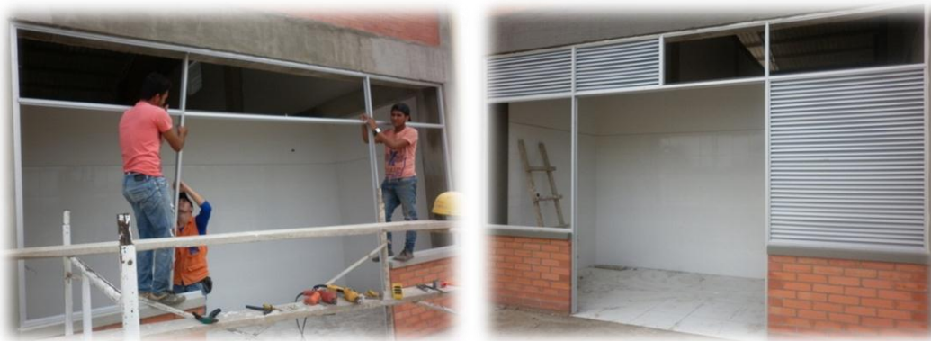
Figura 21. Montaje de puertas y ventanas en aluminio.
