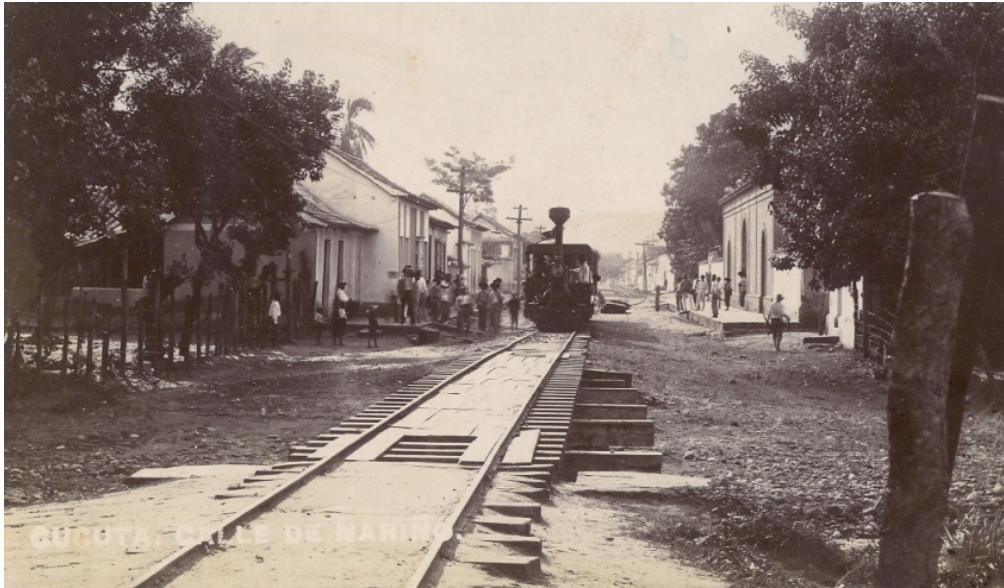
Ilustración N° 20: Fotografía de época de la Calle 10ª. o Calle de Nariño en sentido oriente - occidente, con el puente del ferrocarril sobre la Toma de El Brazo y el Matadero Curazao (a la derecha). Fuente: Repositorio Fotográfico de Norte de Santander – Fondo Cámara de Comercio de Cúcuta, 2017.
