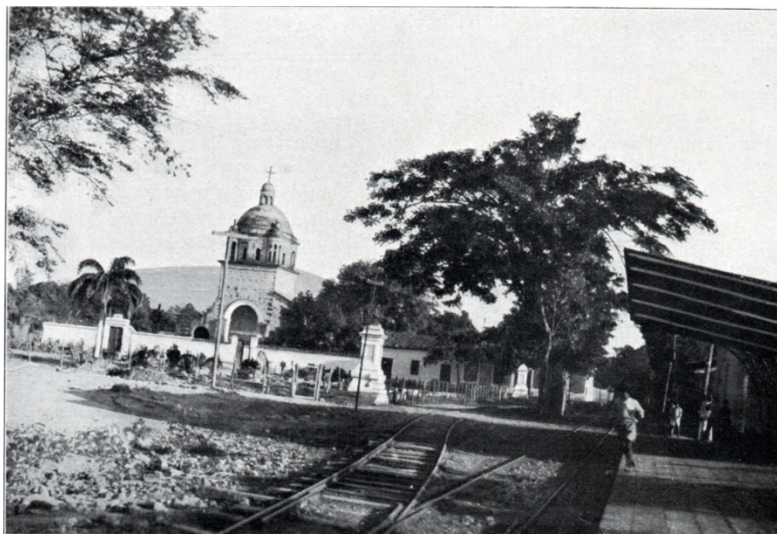
Ilustración N° 33: Fotografía de época tomada desde la plataforma o andén de la Estación Rosario . Fuente: Repositorio Fotográfico de Norte de Santander – Fondo Ferrocarril de Cúcuta , recuperada en 2017.
