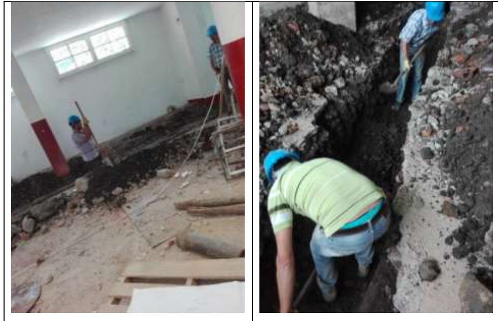
Figura 12. Excavación en material común hasta 2 metros.
