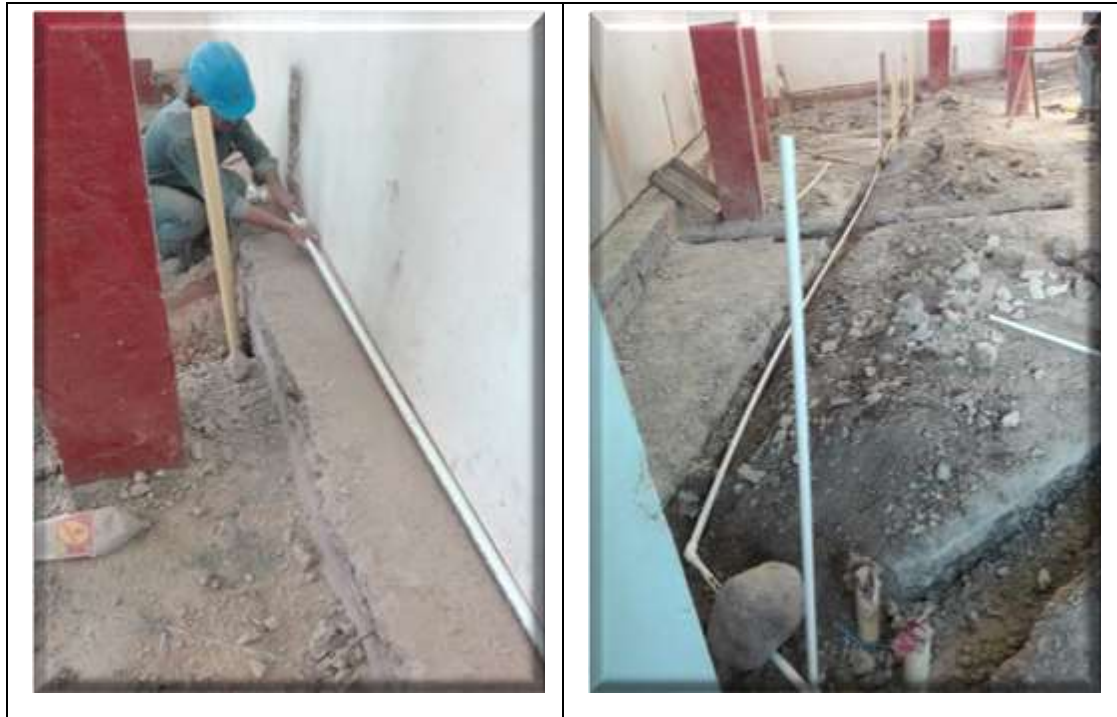
Figura 15. Instalación de tubería PVC RDE 21
