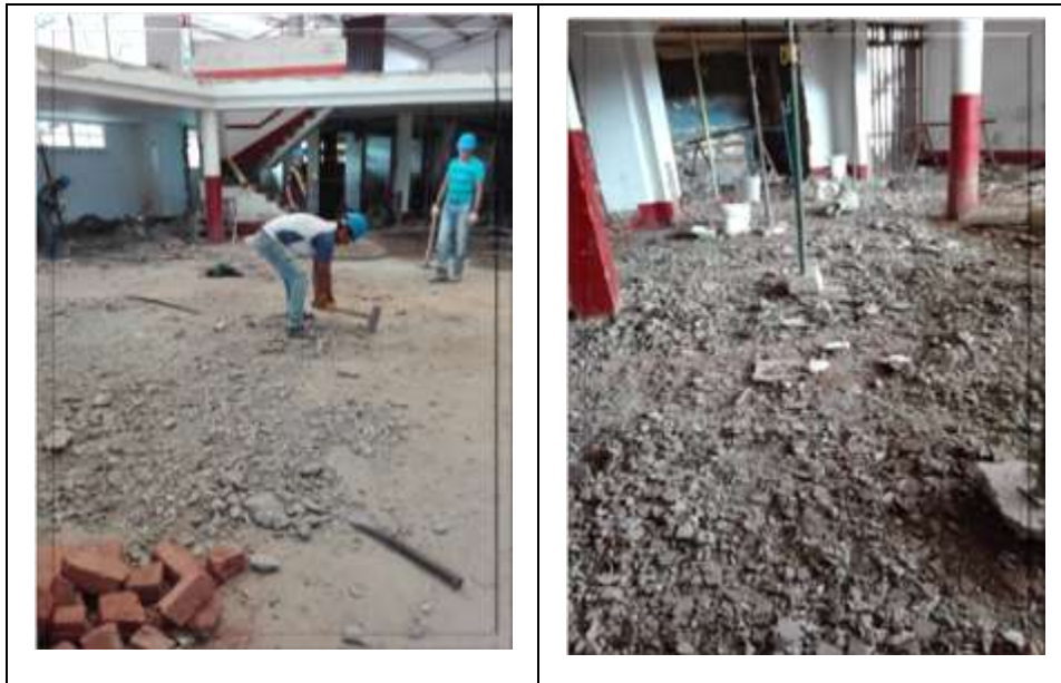
Figura 6. Demolición de pisos
