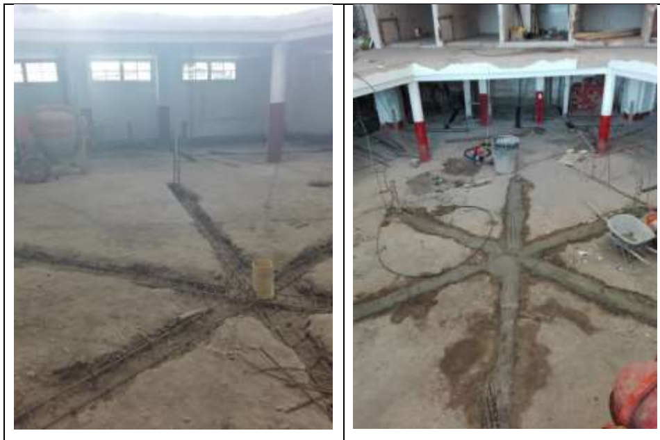
Figura 20. Vigas de cimentación
