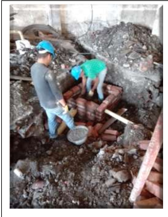
Figura 13. Construcción de cajas de inspección
