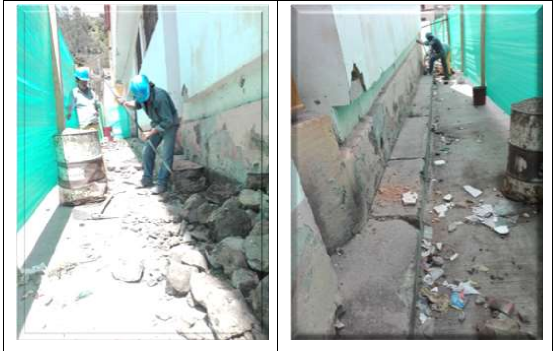
Figura 7. Demolición de andenes
