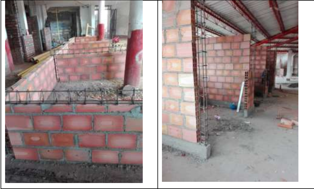
Figura 21. Columnetas y Viguetas de Confinamiento
