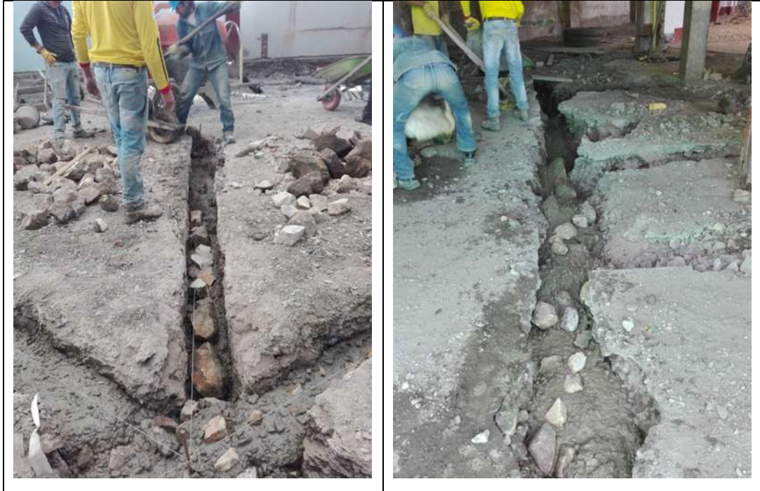
Figura 19. Concreto ciclópeo para cimentación de 2500 PSI
