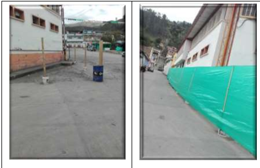
Figura 4. Cerramiento en lona verde del perímetro total.
