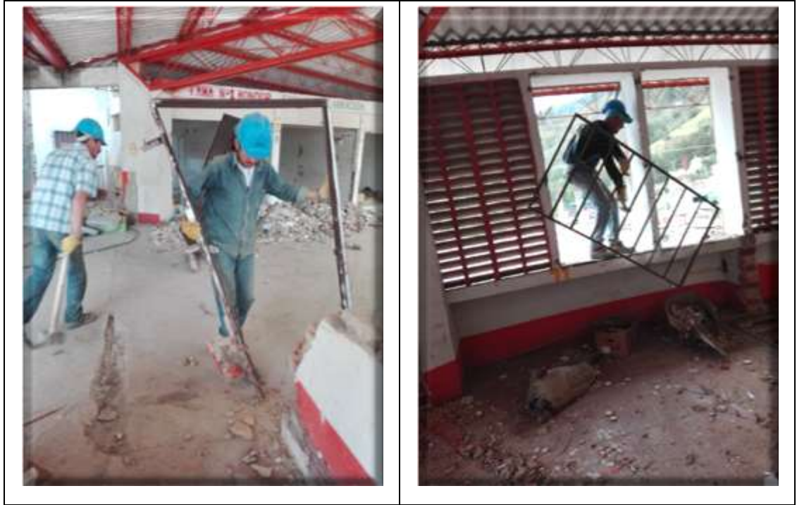
Figura 8. Desmonte y retiro de puertas y ventanas
