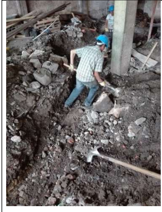
Figura 16. Relleno compactado con material común en sitio.
