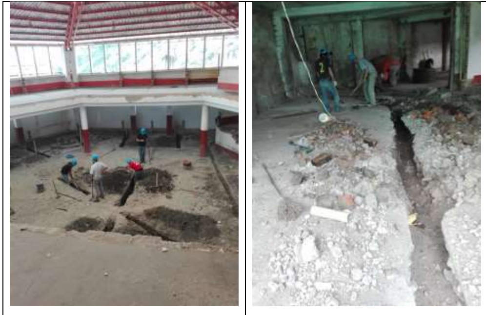
Figura 18. Excavación de material común para cimentaciones
