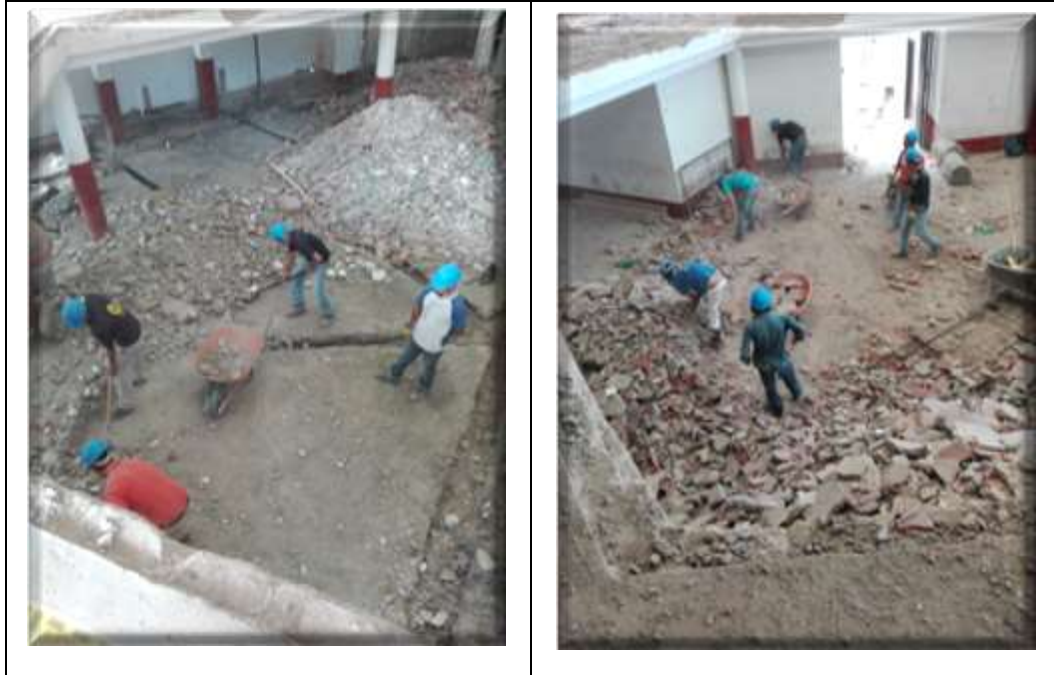
Figura 11. Retiro de escombros
