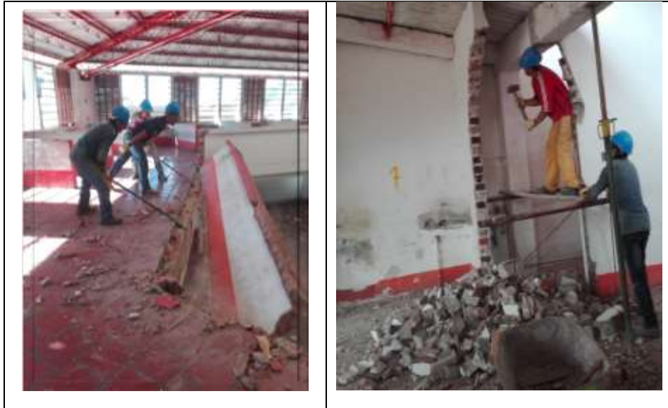
Figura 5. Demolición de muros
