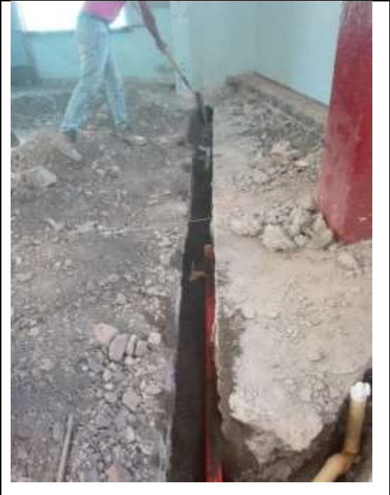
Figura 17. Relleno material de préstamo
