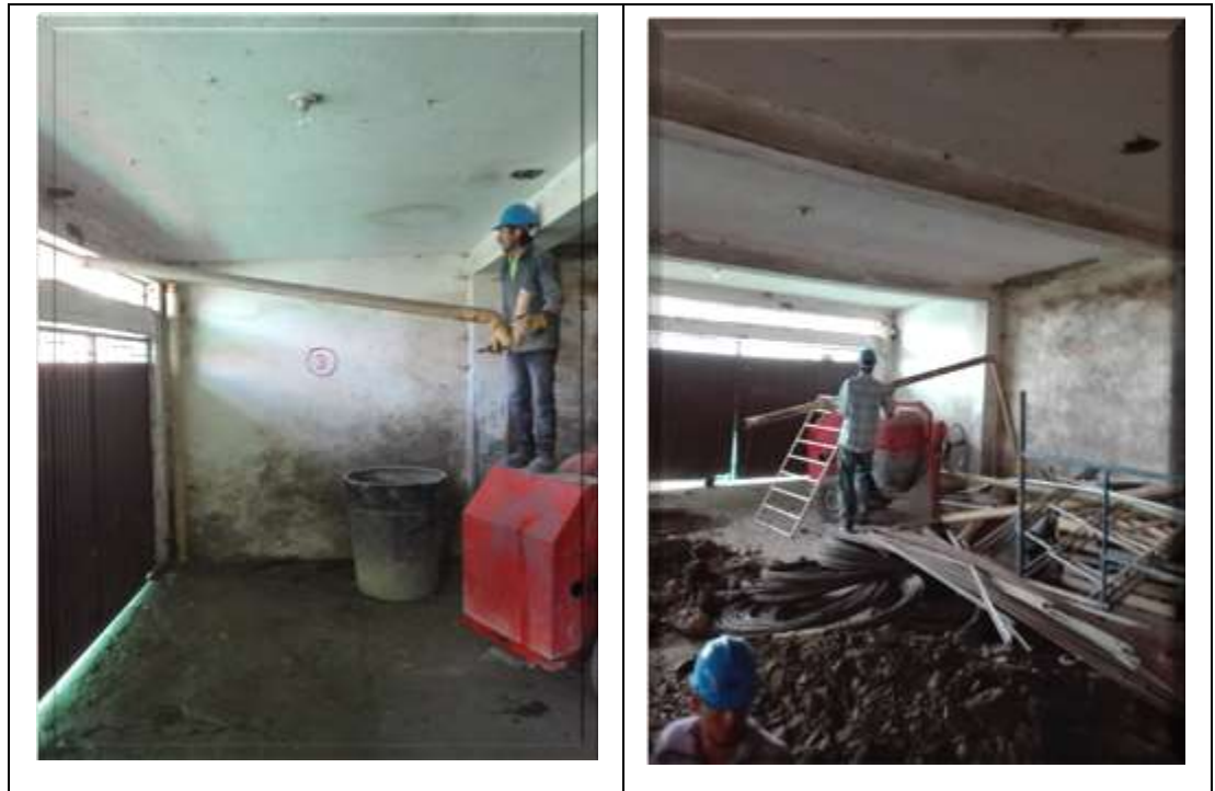
Figura 10. Desmante de tuberías de aguas residuales.
