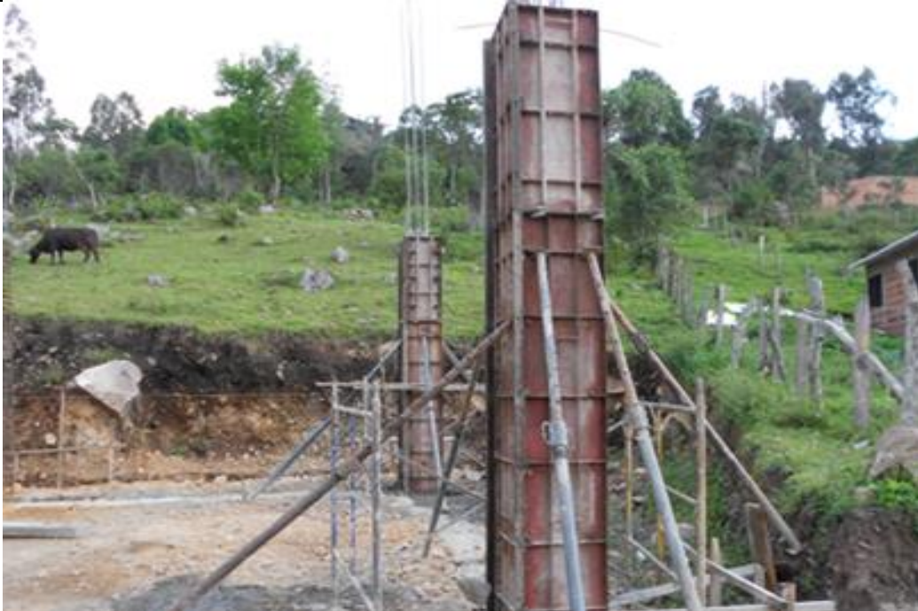
Figura 23. Armado y fundida en concreto de 3000 psi de columnas
