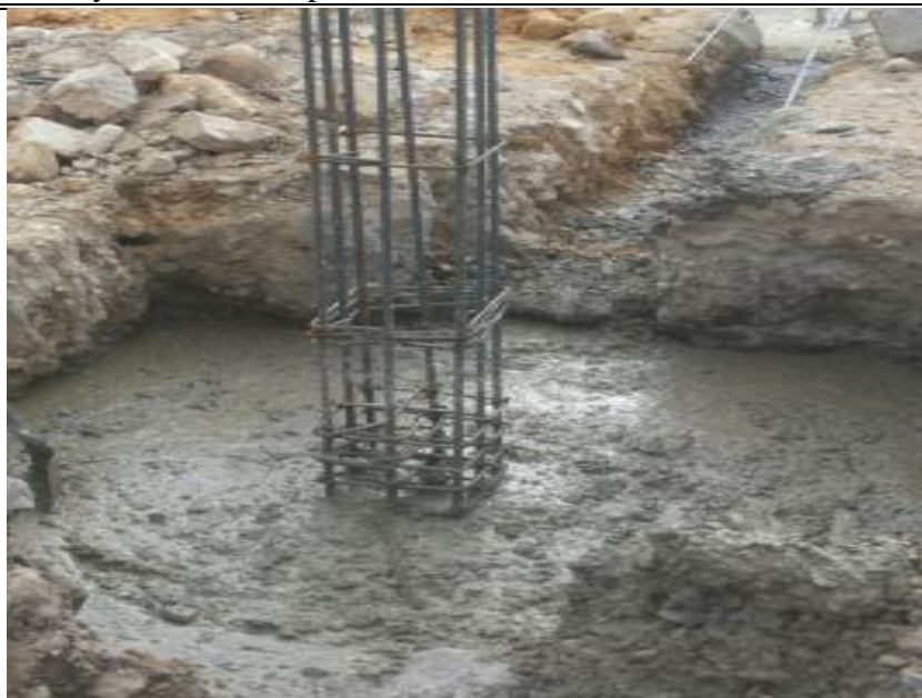
Figura 26. Armado y fundida de zapatas
