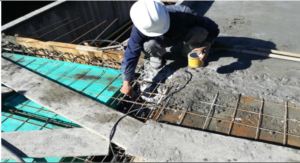
Figura 32. Aplicación de aditivo.
