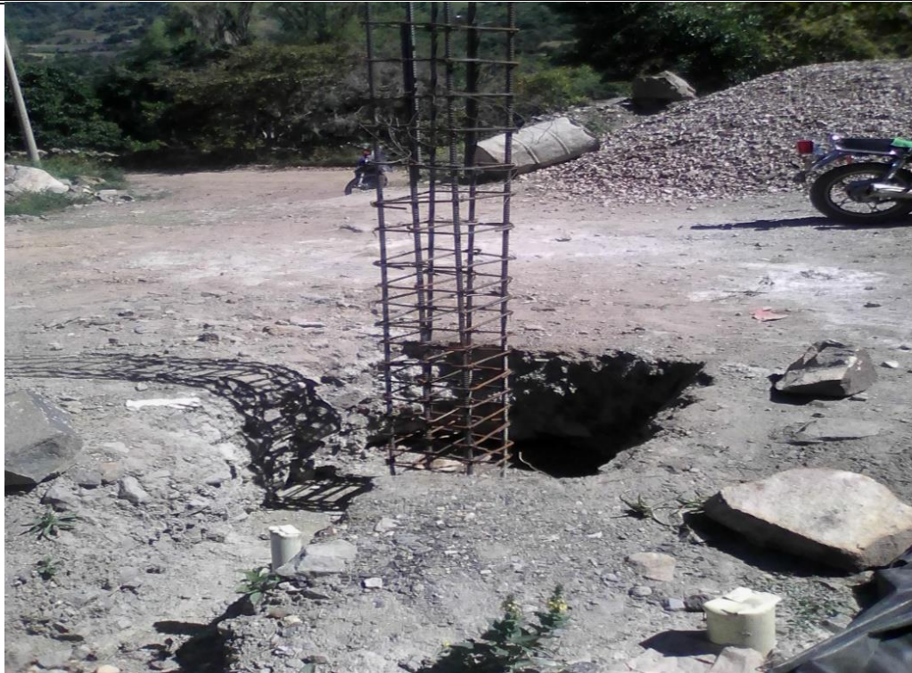
Figura 24. Detalle aceros columnas
