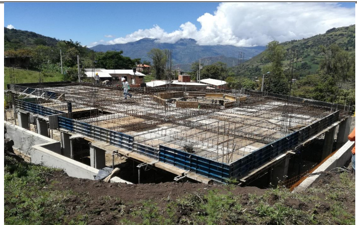
Figura 29. Armado de aceros placa de entrepiso
