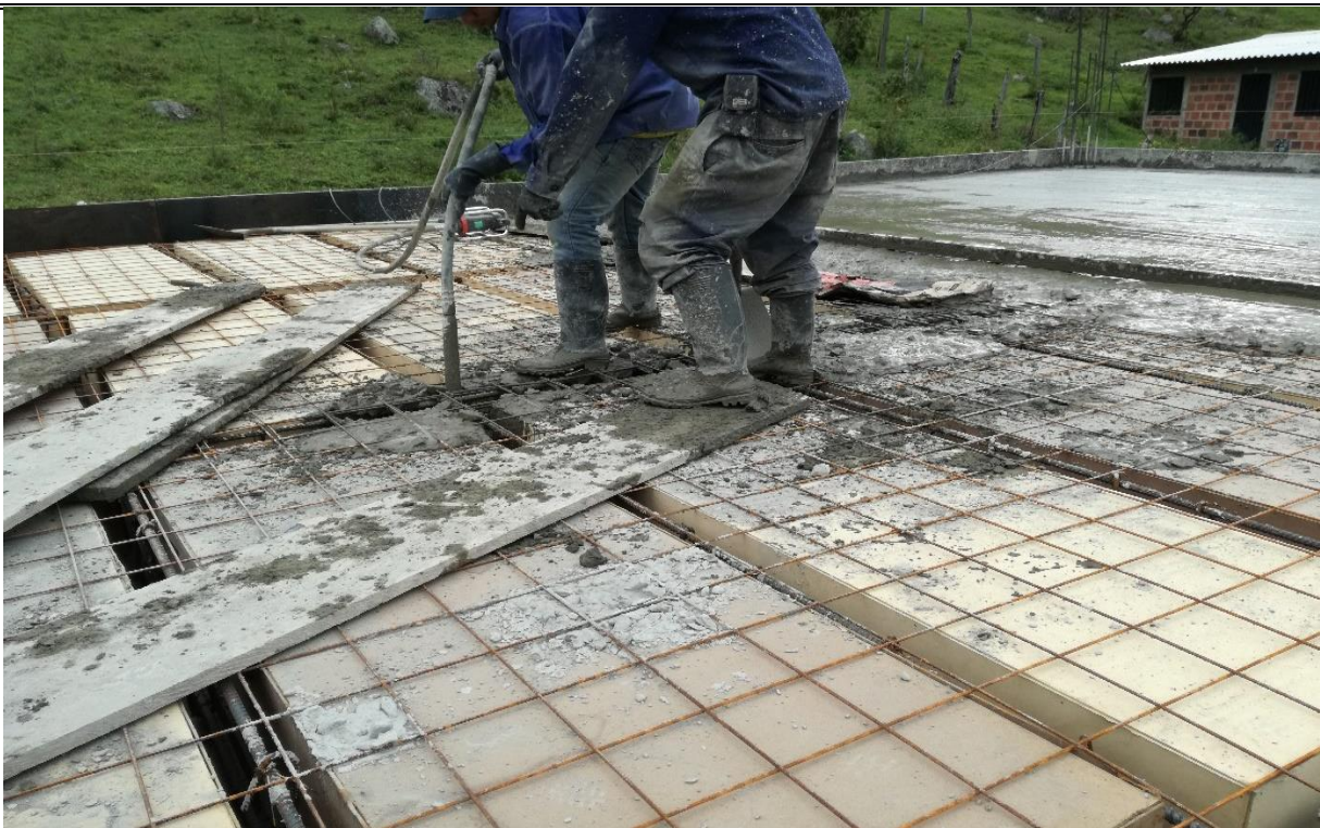
Figura 31. Vibrado a viguetas y vigas
