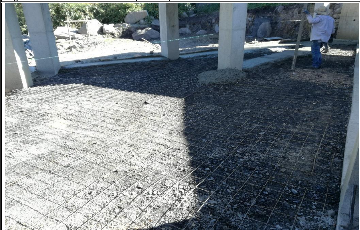
Figura 15. Malla electro soldada para antepiso.
