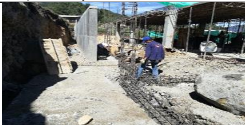
Figura 25. Armado y fundida de vigas de cimentación.
