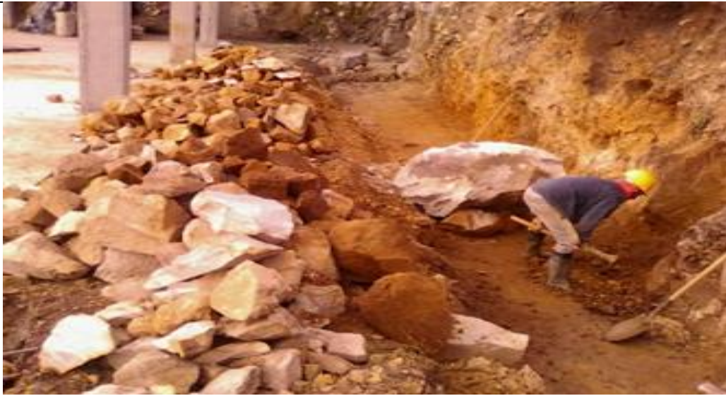
Figura 16. Excavación de talud para muro de contención
