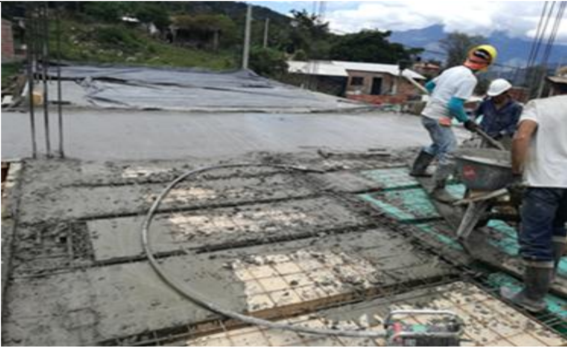
Figura 30. Fundida placa de entrepiso (vigas y viguetas).
