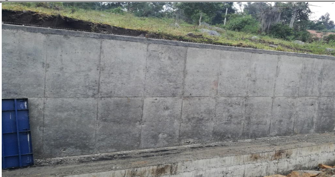
Figura 22. Muro de contención
