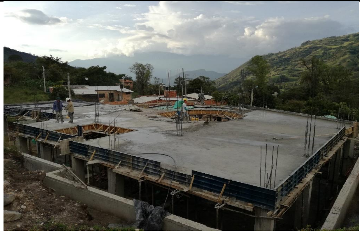
Figura 33. Fundida placa de entrepiso.
