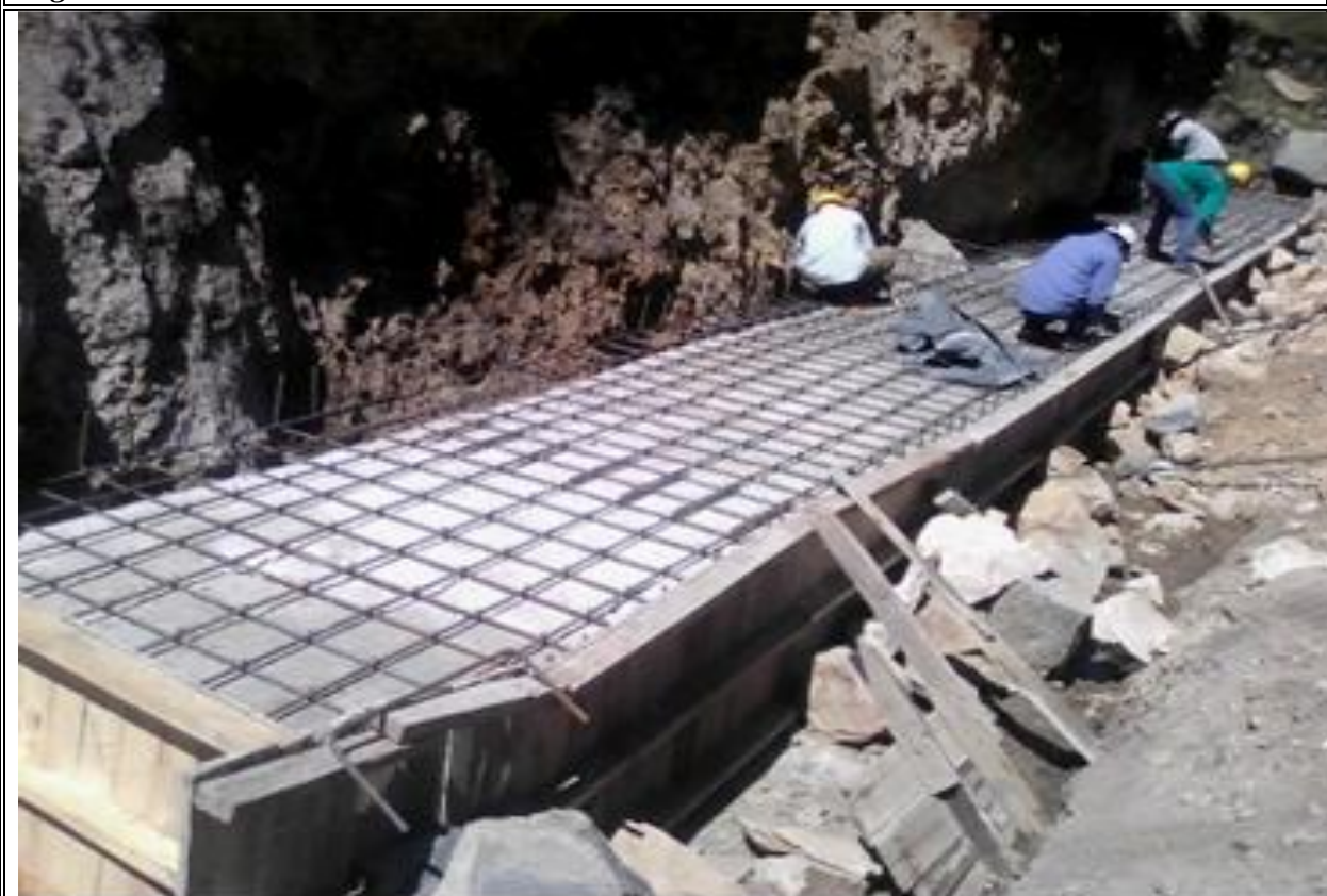
Figura 19. Armado de aceros base de muro de contención
