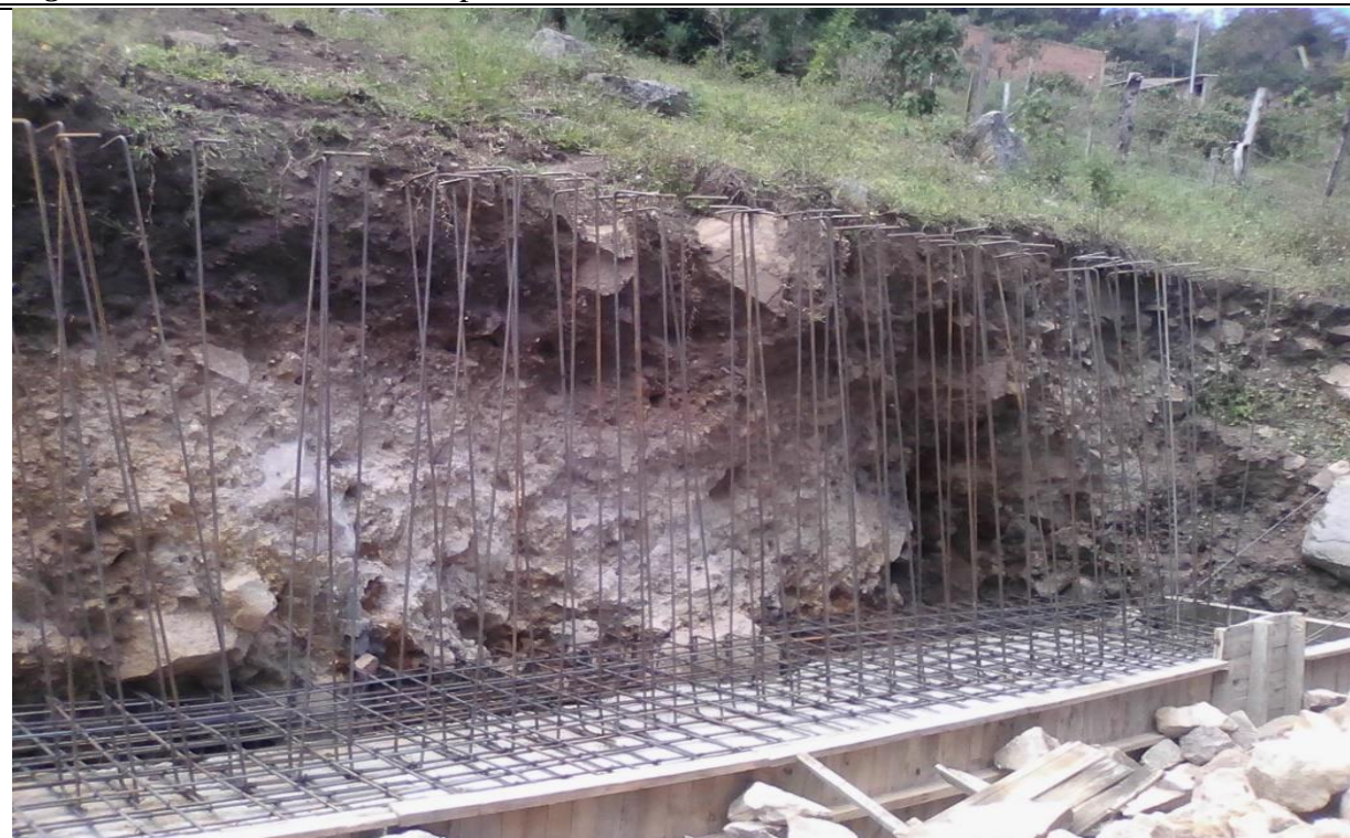
Figura 20. Armado de aceros para muro de contención
