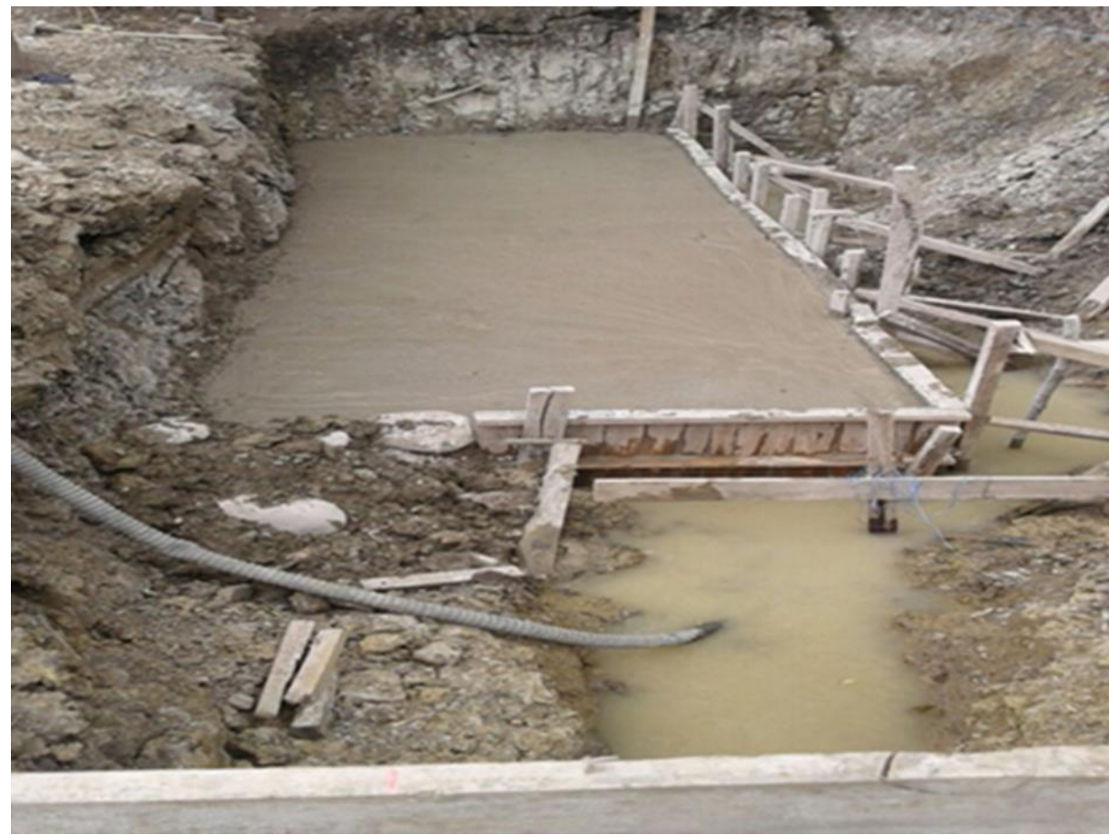
Figura 18. Concreto ciclópeo para bases de muro de contención
