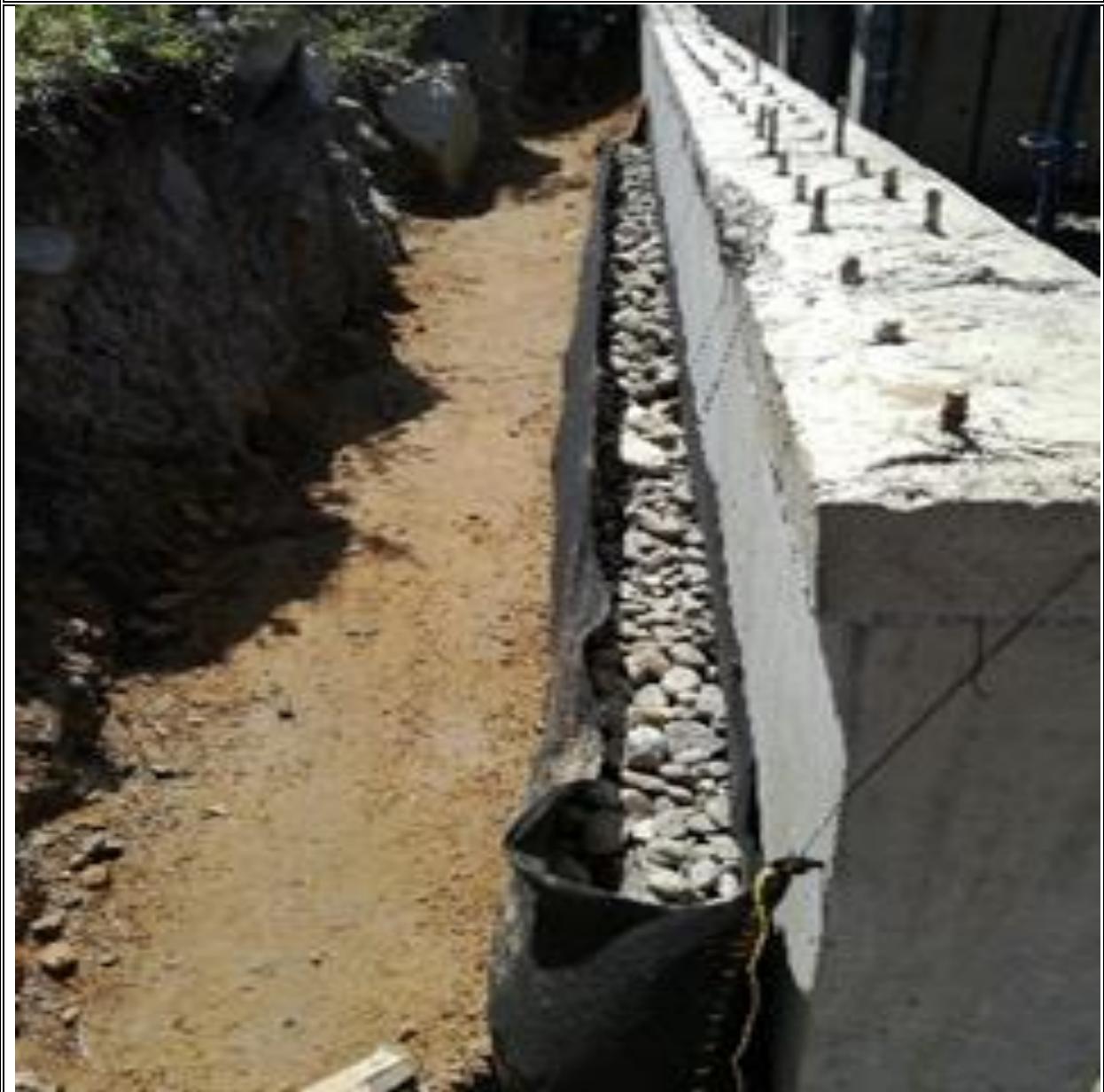
Figura 27. Elaboración de filtro y relleno del muro de contención
