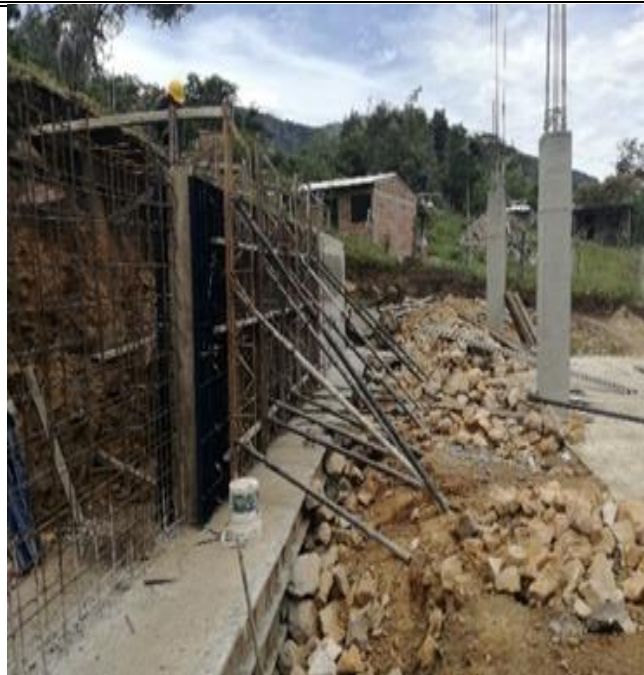
Figura 21. Fundida en concreto de 3000 psi para 40 metros lineales de muro de contención
