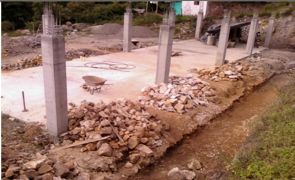
Figura 17. Excavación para muro de contención
