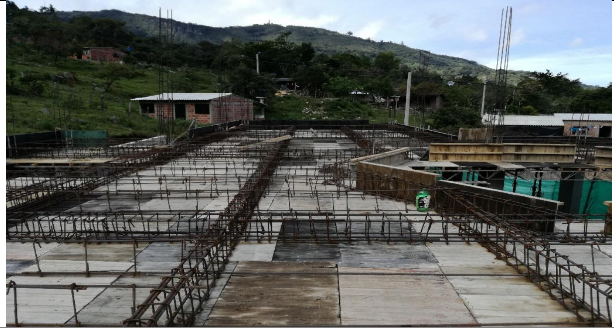
Figura 28. Armado de aceros viguetas y vigas
